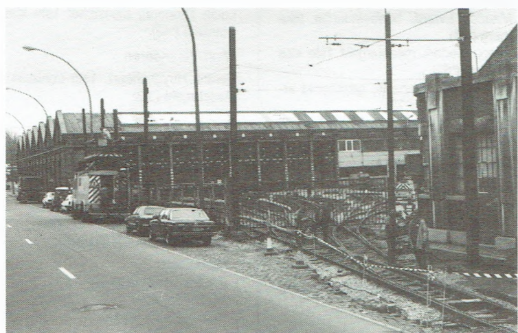
Te Oostende zijn grote werken aan de gang. Daar is men bezig de transpoorten van de stelplaats te vernieuwen. (Foto's: André Nys)
