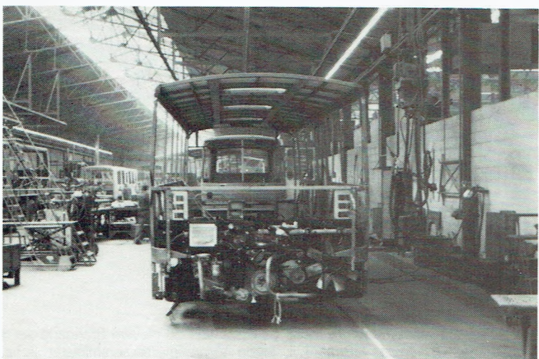
Nadat het geraamte van het dak op het chassis geplaatst werd, monteert men de motor. (Foto: Jean-Claude Tree)
