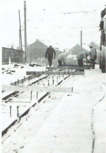
De werf op de Pont Bouvy in La Louvière. De arbeiders zijn bezig de sporen te leggen.
