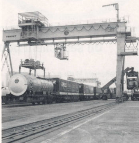
▲ Portique d'une capacité de 30, 40 tonnes...
