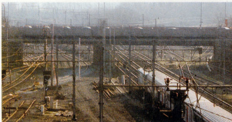
Été 97: le pont à la sortie de Louvain, direction Liège. Un lieu phare des travaux TGV. A gauche, l'embranchement Tivoli doit "glisser" au plus près du pont pour laisser le passage à la voie A actuelle de la ligne 36. A droite de la pile, les deux voies de la 36, qui encadreront la LGV, là justement où aura lieu la séparation. Le tunnel de Bierbeek est à 3 km. Tout à droite, la voie de garage fera place à la ligne 139.
