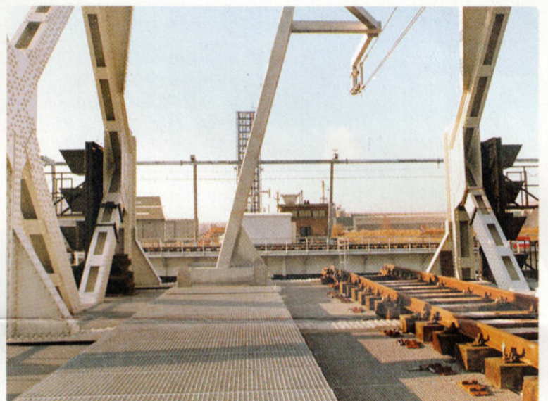
A l'avant-plan, la partie fixe sur le Rupel, ensuite la partie pivotante (la caténaire est à la perpendiculaire), et tout derrière, le pont levis au-dessus du canal.
