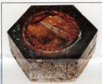
Découvert lors du premier contrôle effectué par le bureau, ce boulon "haute résistance" cassé se trouvait sur un chariot de type porte-spreaders de 150 tonnes qui charge ou décharge des containers de 40 tonnes. Sur 8 boulons qui tenaient l'essieu avant, deux étaient desserrés et celui-ci était cassé...
