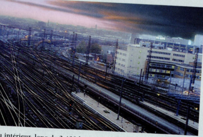
Le nouveau quai intérieur, long de 3.400 km, est modernisé. L'objectif : avancer, les trains avancer.
