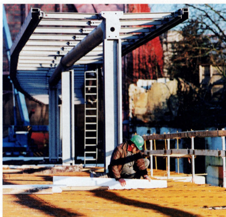
Les quais plus longs seront désormais pourvus d'une marquise.
