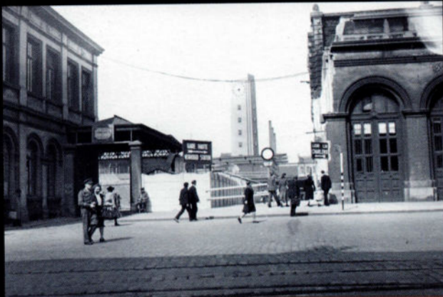
Bruxelles-Midi. Pendant les travaux de transformation, les trains arrivaient à la fois dans l'ancienne gare basse et dans la nouvelle gare haute (avril 1949).
