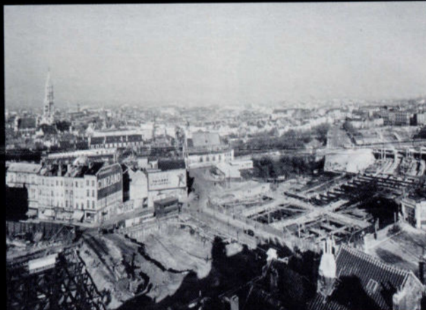
Construction de la Jonction Nord-Midi. Vue sur le tunnel direction Bruxelles-Nord. Mars 1940.
