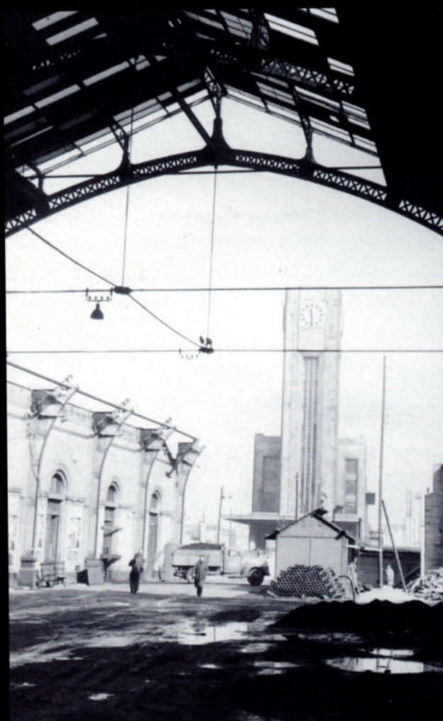
La nouvelle gare de Bruxelles-Nord (mars 1951).
