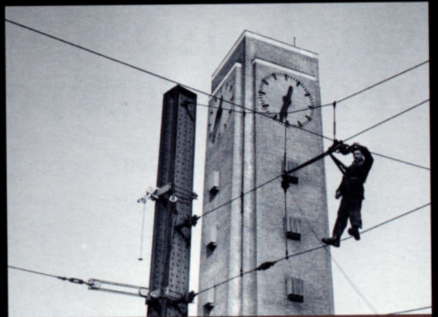
Bruxelles-Midi. Travaux aux caténaies. Mars 1952
