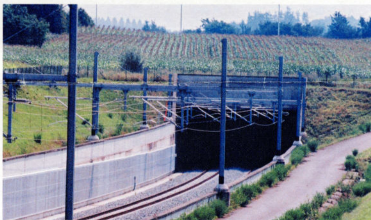
Le tunnel de Bierbeek accueillera les circulations commerciales tant en service intérieur qu'international.
