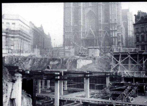
Construction de la Jonction Nord-Midi à hauteur de la cathédrale des St-Michel et Ste-Gudule. Novembre 1948
