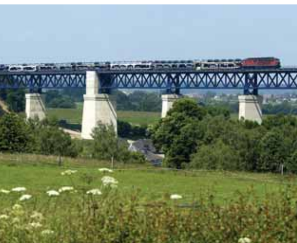
Le viaduc de Moresnet, bientôt sous tension
