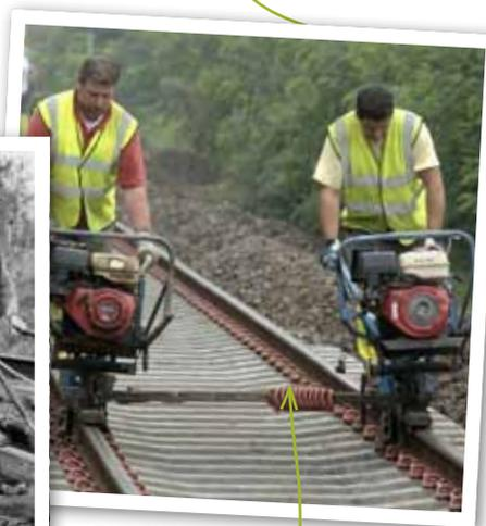
Si les tire-fonds sont toujours utilisés, il existe maintenant un autre système permettant de fixer les rails aux traverses: le clip Pandrol. Il s'agit d'une attache élastique en acier, pliée selon un profil spécialement étudié, que l'on emboîte à l'aide d'un outil, au lieu de visser. Sa grande facilité d'emploi et son absence d'entretien expliquent son utilisation sur un grand nombre de réseaux ferroviaires.
