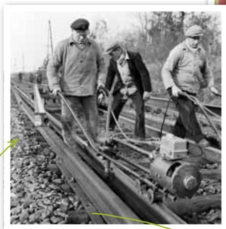
La tirefonneuse permet de visser/dévisser les tire-fonds qui maintiennent les rails en place. (Un tire-fond est une grosse vis que l'on serre dans un trou percé dans la traverse et dont la tête vient en contact avec le patin du rail)
