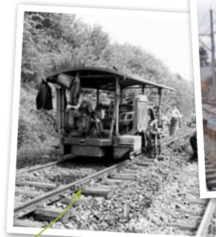
Une bourreuse (dans ce cas, mécanique) permet de compacter du ballast sous les traverses.
