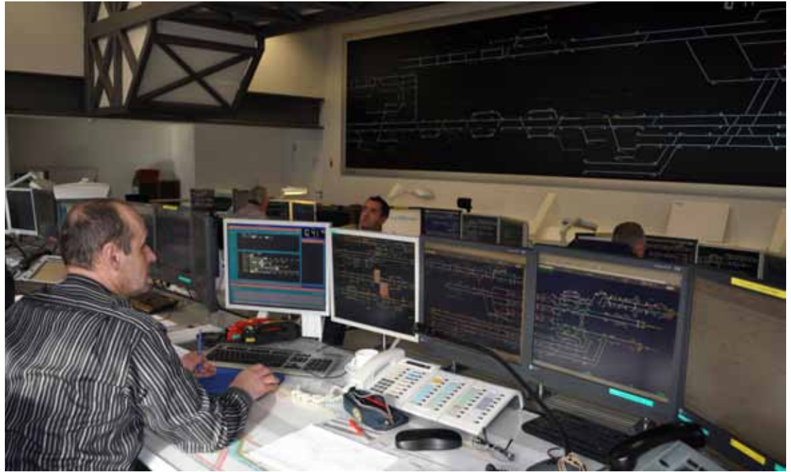
Depuis son poste de travail, Patrick dispose d'une vue complète sur la cabine et sur le tableau de contrôle optique.
