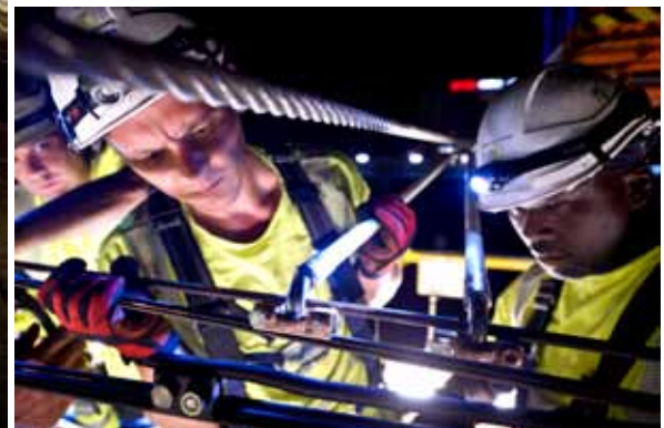
Les fils de la caténaire ont été fixés au câble porteur en inox
