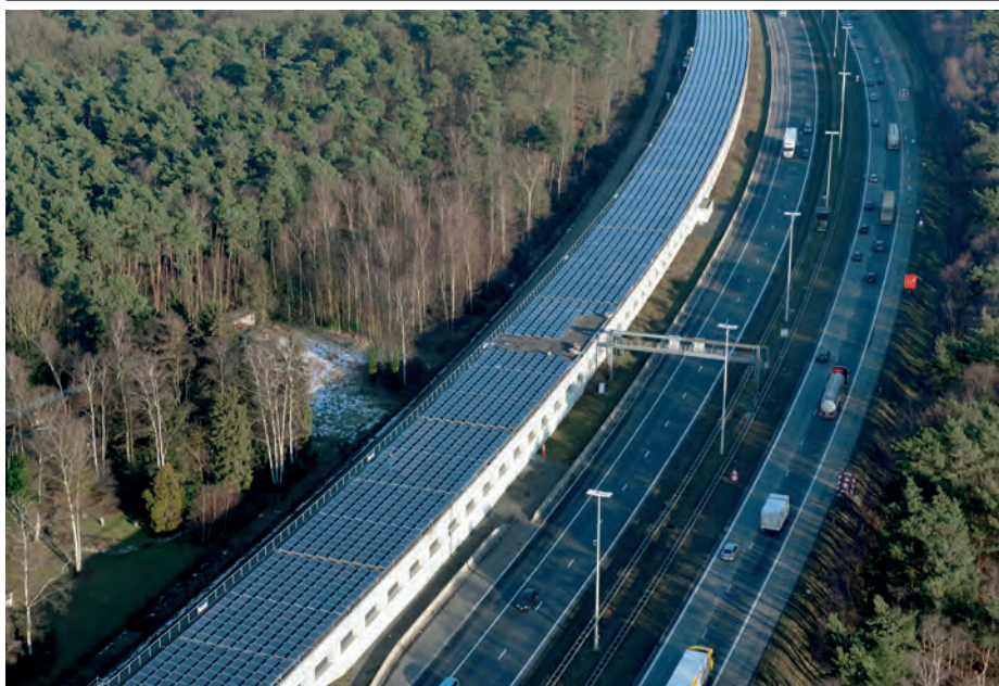
16.000 panneaux solaires sur le toit du tunnel ferroviaire sur la LGV4 à Anvers.
