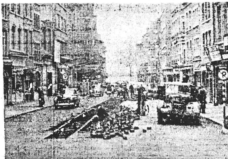
Les tramways namurois, que l'on avait décidé de peindre en blanc il y a vingt-cinq ans, ont définitivement vécu. On en a une nouvelle preuve en voyant des équipes d'ouvriers enlever, dans la rue de Fer, les rails devenus inutiles. Cette importante artère va pouvoir être remise définitivement en état. (Photo « Vers l'Avenir ».)
