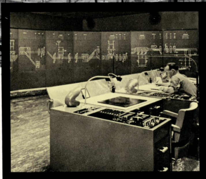
De gecentraliseerde bediening van de onderstations te Paris-Nord.
