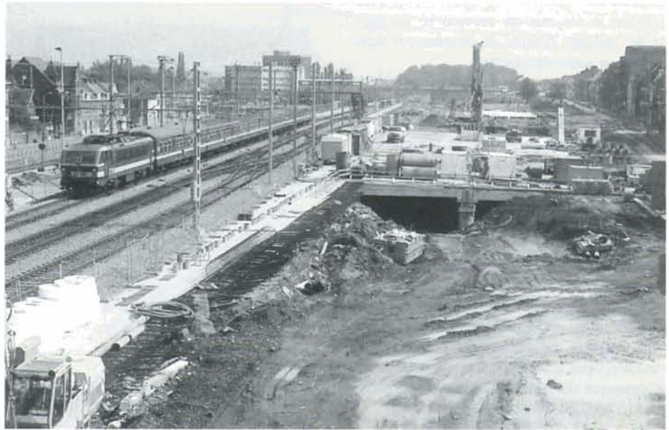
Ci-dessus : la gare de Halle côté Mons. Les voies provisoires sont posées sur la dalle de couverture des voies de la ligne 94, tandis que l'on distingue les deux pertuis des voies de la ligne 96 et TGV. Ci-dessous : la gare de Halle côté Bruxelles. A gauche, la trémie d'accès au pertuis TGV. Les murs de soutènement sont ferrailés; dans le fond, l'entrée du tunnel. Halle, 31 juillet 1995. Photos : Christian DOSOGNE.
