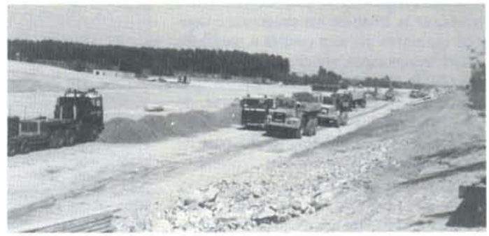
PHOTO 23-51 Confection des talus et mise en place de la couche de forme sur le site de la future base de maintenance du Coucou. La photo est prise en direction de Bruxelles. A gauche, la ligne 94. Les camions de chantier circulent à l'emplacement des futures voies TGV. Meslin, 3 août 1995. Photos : B. DIEU.
