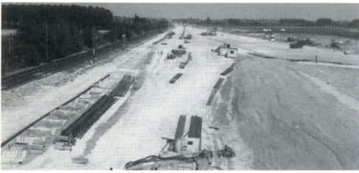
PHOTO 23-50 La future base du Coucou est coincée entre la ligne 94, à gauche, la ligne à grande vitesse, à droite, et la route Meslin-Arbre. On s'affaire actuellement à construire un quai de secours le long de la ligne 94 et poser la voie de raccord qui permettra d'accéder à la base et à la LGV en venant de Ath.
