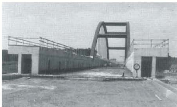
PHOTO 23-30 Le viaduc d'Antoing, qui franchit l'Escant, vu en direction de la France. De part et d'autre, de hauts murets devraient atténuer le bruit des trains. Dans le fond, le viaduc se prolonge par la tranchée couverte de Bruyelle. Antoing, 2-8-95.
