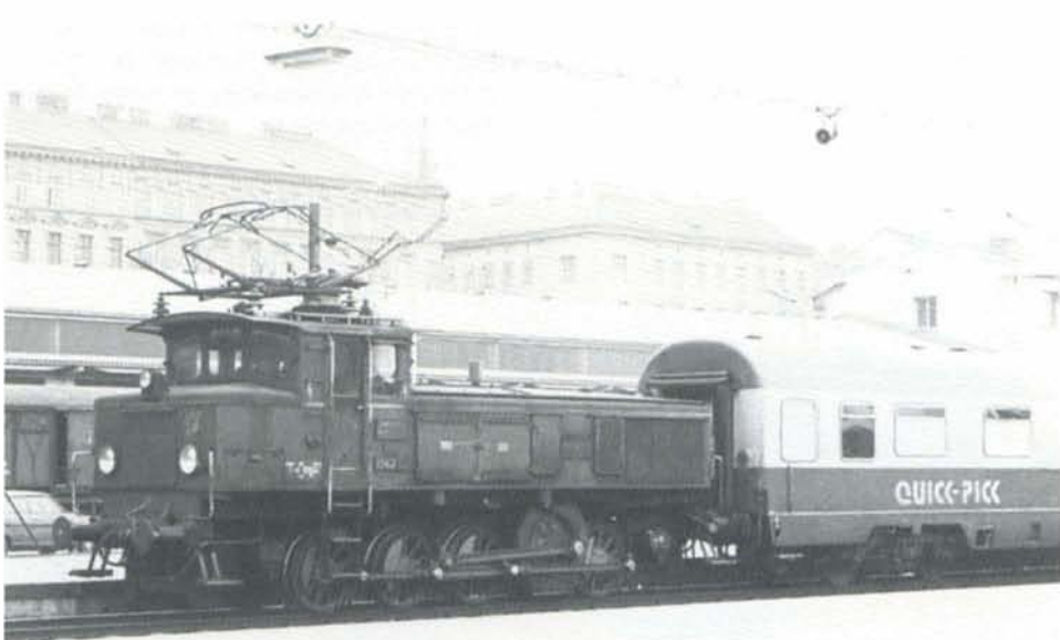
Les dernières locomotives électriques à bielles à voie normale ont quitté la scène ferroviaire en Autriche. Ici, la 1062.10, encore en livrée verte, manœuvre en gare de Wien-West une voiture-restaurant Quick-Pick de la DB, en février 1981.
