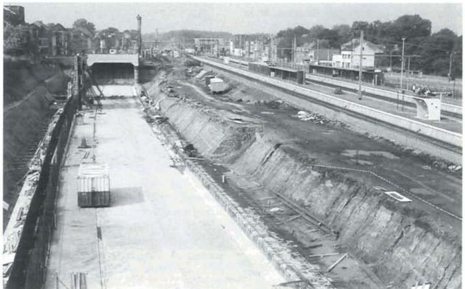
Ci-dessus : la gare de Halle côté Mons. Les voies provisoires sont posées sur la dalle de couverture des voies de la ligne 94, tandis que l'on distingue les deux pertuis des voies de la ligne 96 et TGV. Ci-dessous : la gare de Halle côté Bruxelles. A gauche, la trémie d'accès au pertuis TGV. Les murs de soutènement sont ferrailés; dans le fond, l'entrée du tunnel. Halle, 31 juillet 1995. Photos : Christian DOSOGNE.
