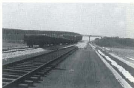
PHOTO 23-29 La voie provisoire, qui permet l'acheminement des 1er trains de route, a été posée par la SNCF sur quelques centaines de mètres en territoire belge. Les wagons, à gauche, transportent les traverses béton qui seront substituées à la voie provisoire lorsque les longs rails auront été déchargés. Rumes, 2 août 1995.
