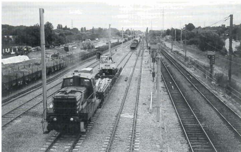
La ligne 26 en cours d'équipement côté Bruxelles. Les voies sont posées et l'on procède à l'électrification. La mise en service interviendra dans un peu plus d'un mois. Halle, 7 septembre 1995. Photo : Christian DOSOGNE.
