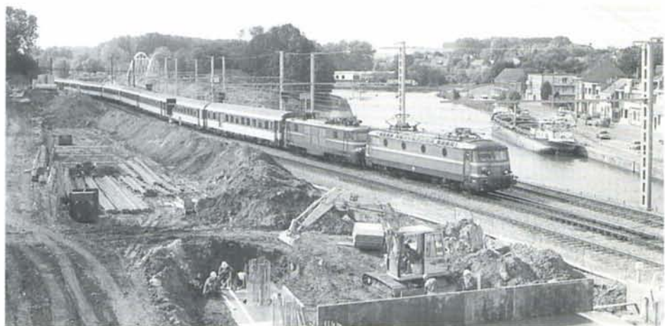
Le train international 281 Paris-Bruxelles-Amsterdam entre en gare de Halle. On aperçoit, en bas, la sortie du tunnel de la gare. A gauche, les terrassements de la future trémie d'accès. Halle, 29 septembre 1995. Photo : Christian DOSOGNE.
