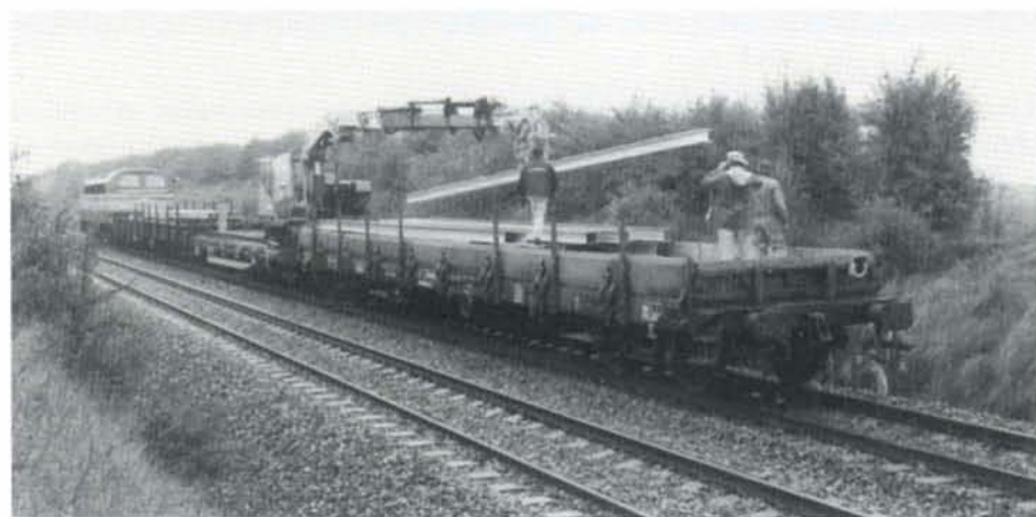
Lundi 25 septembre 1995 : le tout premier poteau support de caténaire est posé sur le sol de l'Athus-Meuse à 9h16. Offagne, 25 septembre 1995. Photo Tanguy BADIE.
