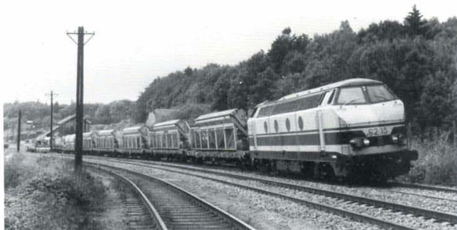
Le train bétonneur des assises des poteaux était remorqué par la très célèbre 6215, laquelle s'est spécialisée dans les travaux de voie! Vonèche, 25-9-1995. Tanguy BADIE.
