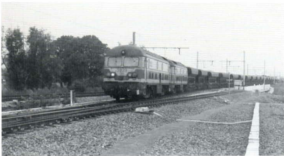
PHOTO 24-61 Afin de tester l'équipement de la base de St-Druon, un grand exercice a été organisé les 18 et 19 septembre. Une dizaine de trains ont ainsi été mis en marche entre St-Ghislain et St-Druon. Ici, un train de ballast remorqué par deux 59 quitte la ligne 78 et pénètre dans la base. Photo : Baudouin DIEU.
