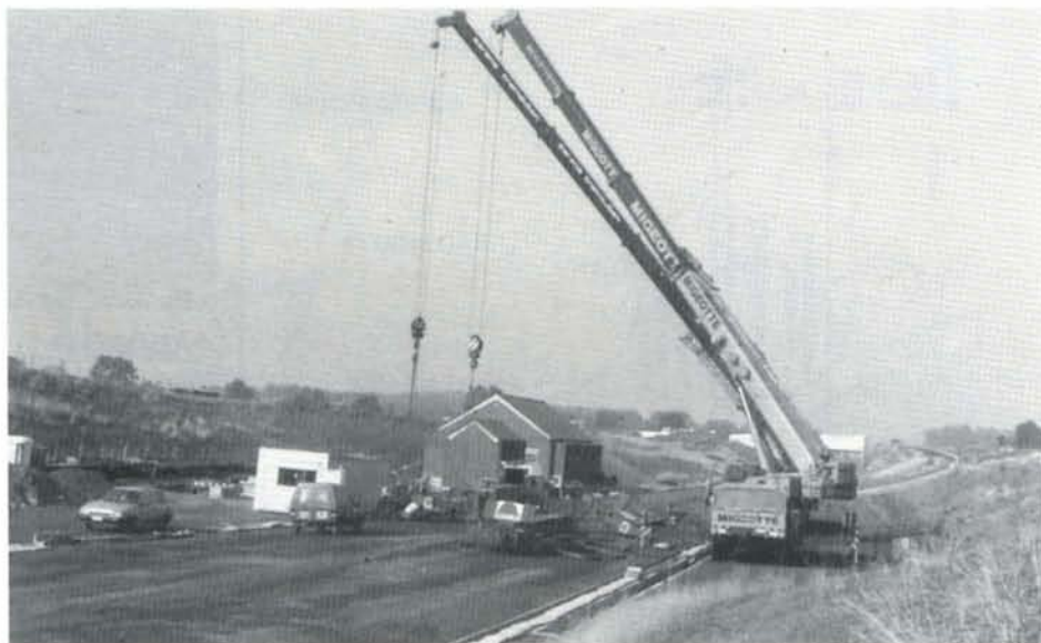
PHOTO 24-13 Deux énormes grues routières procèdent au montage, sur la plate-forme, du portique à pneus de l'entreprise Seco/DG. Antoing, 18 septembre 1995.
