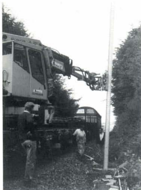
La pose du tout premier poteau support de caténaire situé à la BK 69,1 aux environs d'Offagne, 29 septembre 1995. Photo : Georges et Tanguy BADIE.
