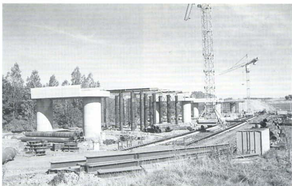
Construction du viaduc de quatre travées au lieu-dit Quenestine à Quenast. 8 octobre 1995. Photo : Christian DOSOGNE.
