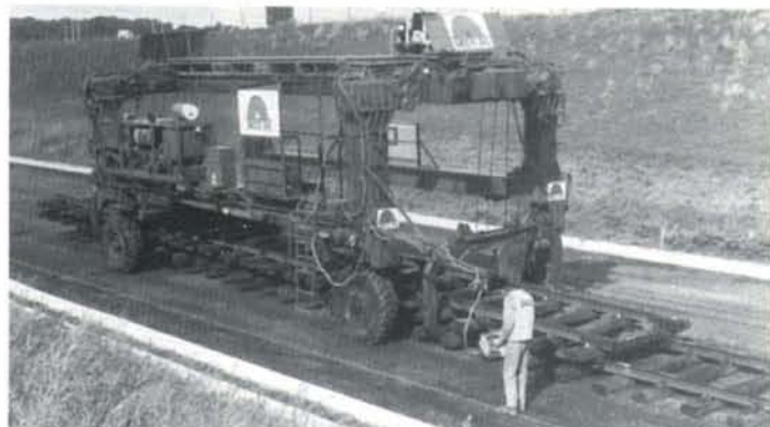
↑ PHOTO 24-51 ↓ PHOTO 24-52 Là, le portique sur pneus les décharge à même la plate-forme par paquets de 4 et les ajuste l'un derrière l'autre. Pendant ce temps, la navette est repartie chercher un autre chargement. Antoing, 25-9-1995.
