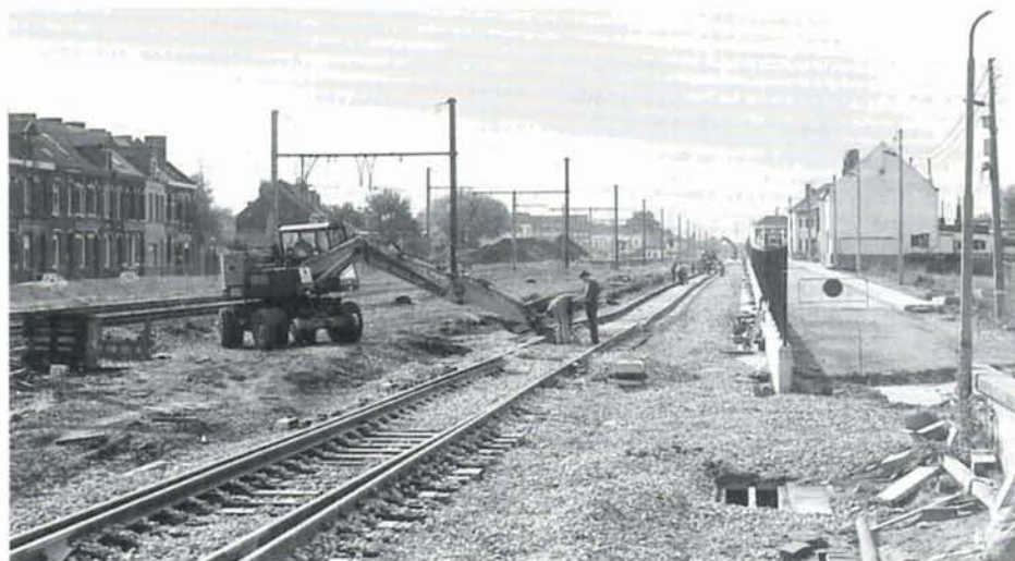
Ruisbroek : construction de la future voie B de la ligne 96 (voie vers Bruxelles). A l'avant-plan, un des appareils de voie de la nouvelle bifurcation de Ruisbroek. Ruisbroek, 5 octobre 1995. Photo : Christian DOSOGNE.
