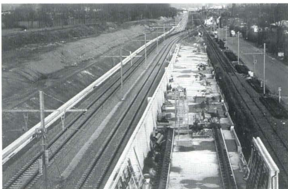
Etat d'avancement des travaux au viaduc de Lot. A gauche, les deux voies utilisées pour le passage des trains vers et venant de Bruxelles. A droite, l'ancienne voie A de la ligne va être ripée pour permettre l'acheminement des poutrelles de béton. Lot, 28 novembre 1995. Photo : Christian DOSOGNE.
