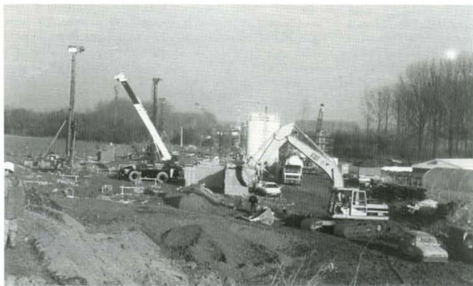
PHOTO 25-58 Vue du chantier du viaduc d'Arbre, prise à hauteur du canal Ath-Blaton vers Silly. Chièvres, 16 janvier 1996. Photo : Baudouin DIEU.
