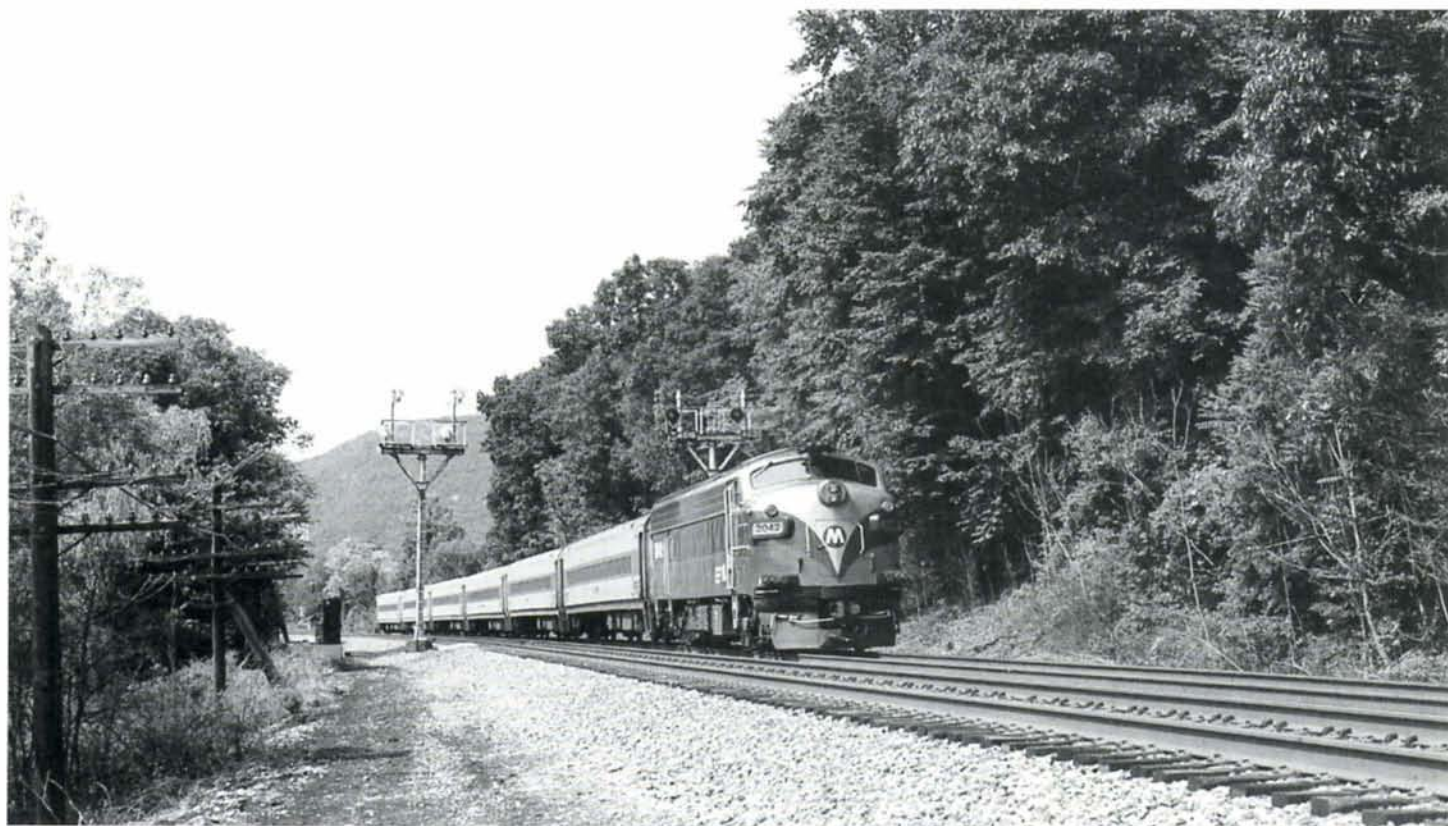
PHOTO 25-02 En 1991 et 1992, 7 FL9 du Metro-North (n° 2040 à 2046) furent entièrement remotorisées par ABB-Republic, et équipées d'un moteur GM type 710 de 3.200 HP. Ces machines circulent toujours en simple traction, comme ici la FL9 2042 (à l'origine New Haven 2022) photographiée le 5 juin 1995 entre Manitou et Garrison. Les "chandeliers" lumineux ont été mis hors service quelques jours plus tard. Photo : Jean-Luc VANDERHAEGEN.
