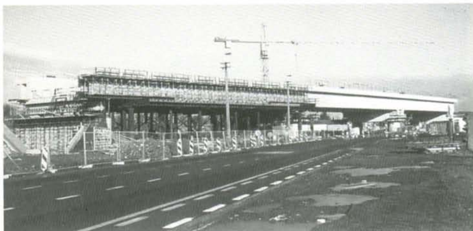
A Tubize, le viaduc qui enjambe la chaussée de Mons a déjà deux travées de construites. Tubize, 26 décembre 1995. Photo : Christian DOSOGNE.
