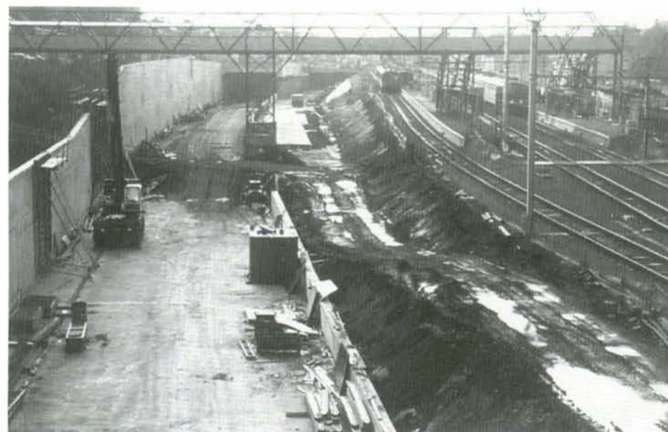
La trémie d'accès des deux voies TGV photographiée vers la gare. A droite, la gare provisoire. Halle, 29 décembre 1995. Photo : Christian DOSOGNE.
