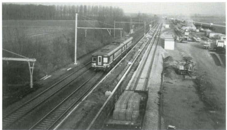
PHOTO 25-59 La base du Coucou est terminée, hormis quelques travaux de finition. On s'affaire à équiper le quai de secours, tandis que passe un train IR pour Grammont via Ath. Les wagons sont garés sur la future voie de raccord L94/LGV. Meslin l'Évêque, 16 janvier 1996. Photo : Baudouin DIEU.
