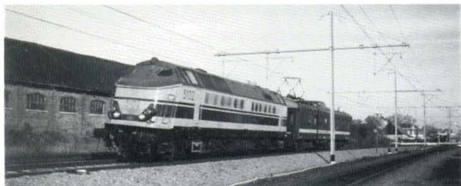
PHOTO 25-40 L'électrification de la ligne 73 Deinze-De Panne s'achève. Le 14 décembre 1995, la voiture de mesure 610 a parcouru pour la première fois la section Tielt-Lichtervelde afin de vérifier la caténaire. Le train d'essai est photographié à la sortie de la gare de Tielt, à côté de l'ancienne remise vicinale. Photo : Pierre HERBIET.
