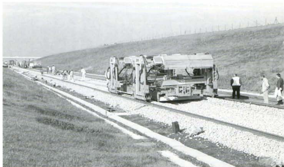
PHOTO 28-30 Le portique enlève les coupons de voie provisoire et met en place les traverses béton. Il roule sur les longs rails soudés préalablement déposés. Barry, 8 octobre 1996. Photo : B. DIEU.
