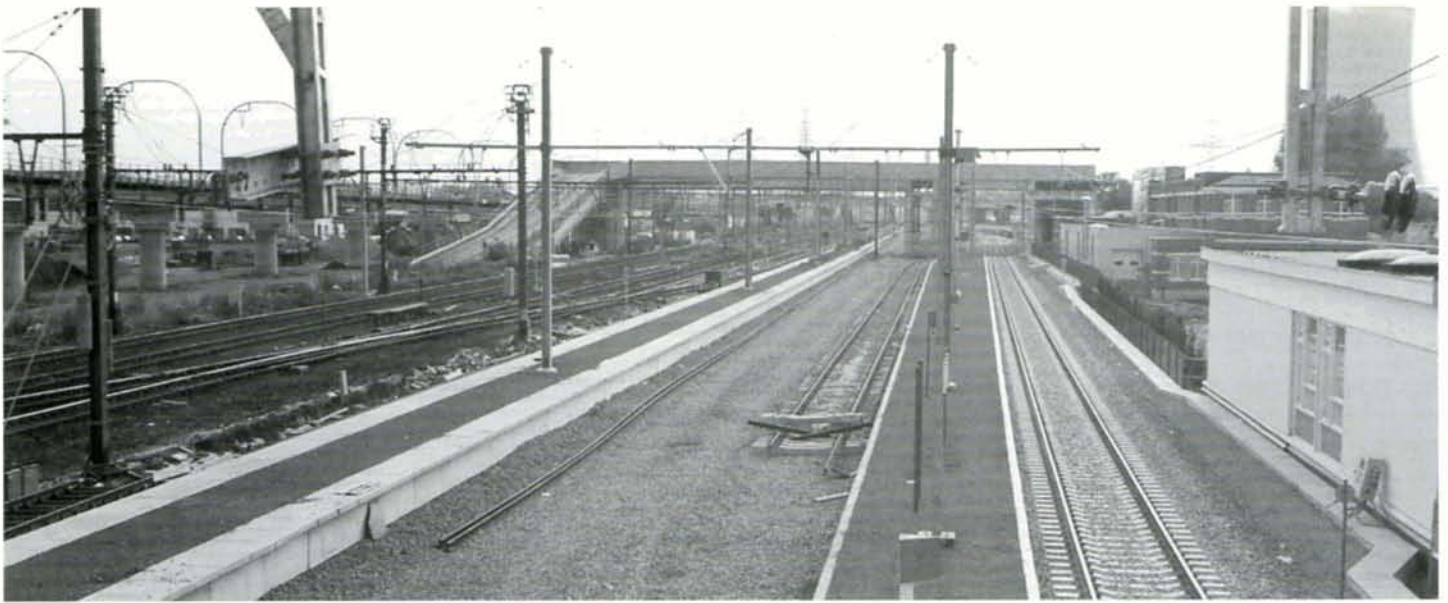
PHOTO 28-34 La physionomie de la gare de Forest-Voyageurs change profondément. La future voie B de la ligne 96A, à droite, est en service et desservie par un nouveau quai. Celui de la voie B de la ligne 96 est également construit. Entre les deux se trouveront deux voies de service. A gauche, le viaduc de la voie A de la ligne 96A prend forme et les portiques caténaires sont déjà en place. Dans le fond, le pont "Volkswagen". Forest, 14 octobre 1996. Photo : B. DIEU.
