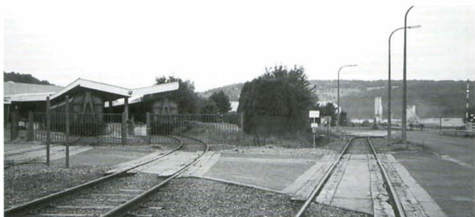
La ligne industrielle 288 : à gauche, le raccordement privé; à droite, le PN 6 de la rue Moriamé; à l'extrême-droite en contrebas, la Sambre. Photo : Michel LEBEAU.
