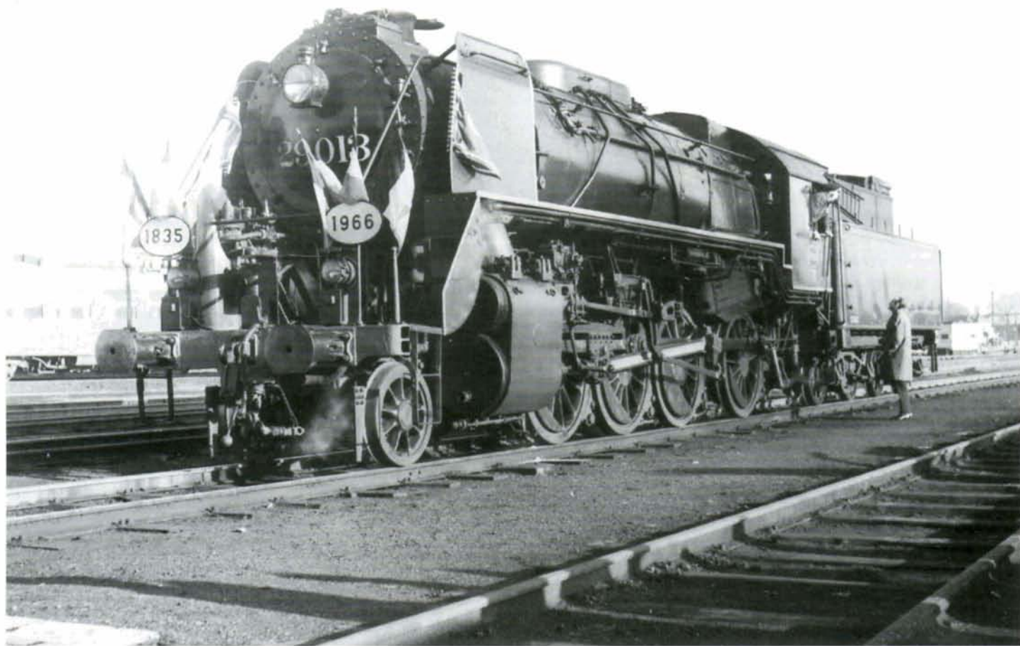
PHOTO BD 002 Le 20 décembre 1966, la 29.013 revêtue de son plus beau costume d'apparat s'apprête au dépôt de Ath à assurer le dernier train voyageurs à traction vapeur. Trente ans plus tard, alors que la SNCB désire commémorer cet anniversaire, la 29.013 doit subir une révision de sa chaudière, des avaries graves ayant été décelées au foyer. Photo : Bruno DEDONCKER, collection PFT ©.
