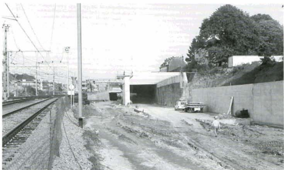
PHOTO 28-32 A Halle côté Mons, le tunnel est percé pour les deux voies TGV dont on distingue l'avancée en béton. A sa gauche, le pertuis des deux futures voies de la ligne 96. Halle, 14 octobre 1996. Photo : B. DIEU.
