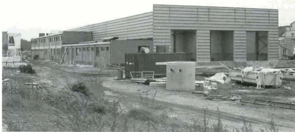
PHOTO 29-26 Les travaux de construction du nouveau poste d'entretien des voitures d'Antwerpen-Schijnpoort. 31 octobre 1996. Photo : Jean-Luc VANDERHAEGEN.
