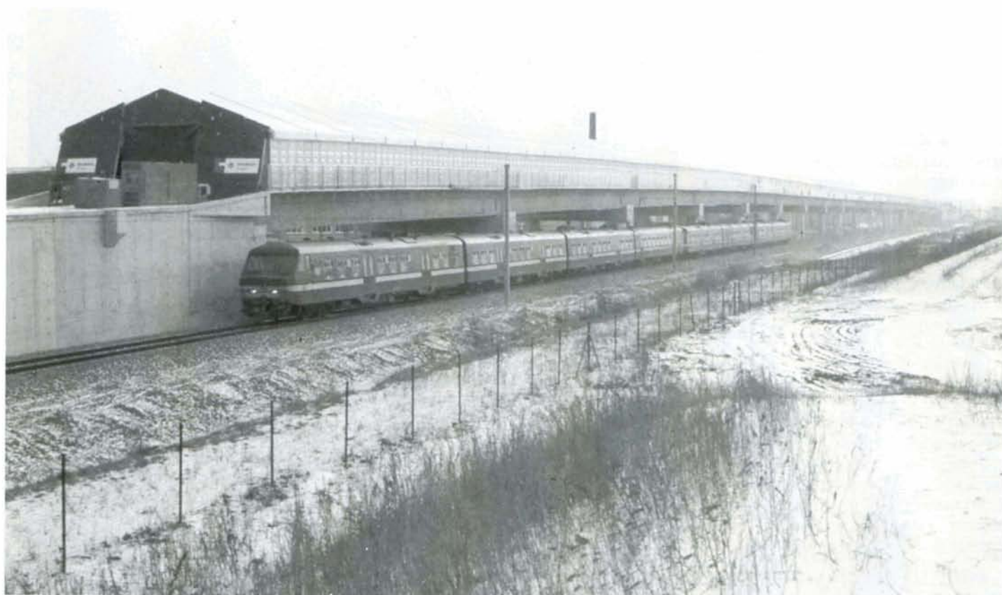
Pour permettre la poursuite des travaux à l'ouvrage, le viaduc de Lot a été complètement protégé par un tunnel... Plongeant vers Bruxelles, un train IR de la relation Binche-Louvain-la-Neuve quitte Lot. La voie B vers Bruxelles a été démontée, et la voie A est devenue voie B. Lot, 31 décembre 1996. Dia : Christian DOSOGNE.
