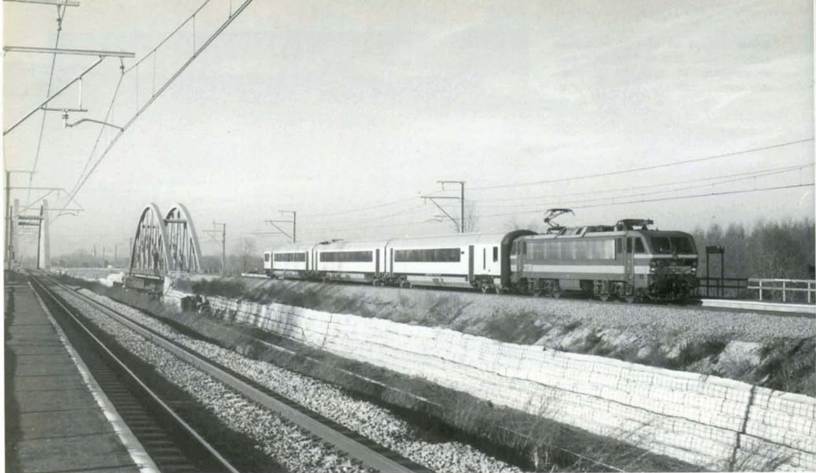
PHOTO 29-24 La surélévation des voies et le grand dégagement offrent une vue impressionnante sur le site de Landegem. La 2136 remorquant l'automotrice 449 vers Mons, vient de franchir le canal du Schipdonk le 14 janvier 1997. Ph. : Jean-Luc VANDERHAEGEN.
