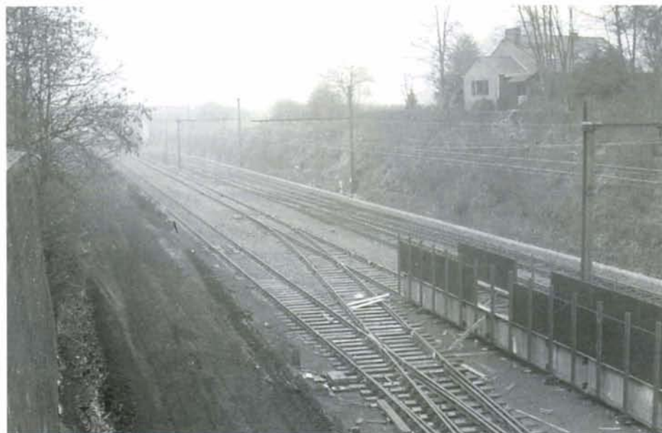
PHOTO 28-36 En gare de Ans, les voies accessoires ont été démontées et seules restent praticables les voies 1 à 4. La ligne 36B est hors service entre Voroux et Ans. Ans, 28 janvier 1997. Photo : B. DIEU.
