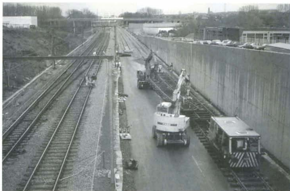
Entre le viaduc de Lembeek et l'entrée de Halle, la voie provisoire a été posée par deux grues routières à la place du portique à pneus. Lembeek, 26-11-1996.
