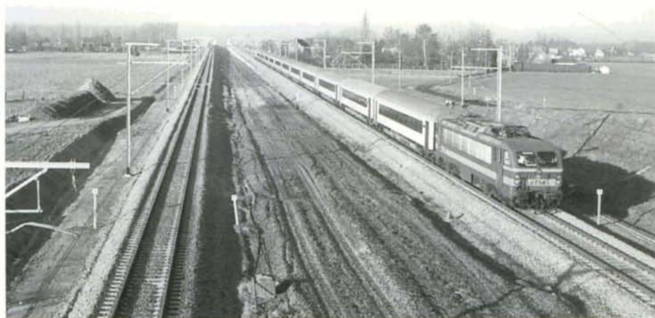
PHOTO 29-23 Les deux nouvelles voies surélevées de Landegem ont été mises en service le 24 novembre 96. Cette vue prise un kilomètre avant les ponts au-dessus du canal, en direction d'Oostende, montre l'amorce des rampes d'accès. La 2714 avec l'IC 509 Oostende-Eupen, 14 janvier 1997. Photo : Jean-Luc VANDERHAEGEN.
