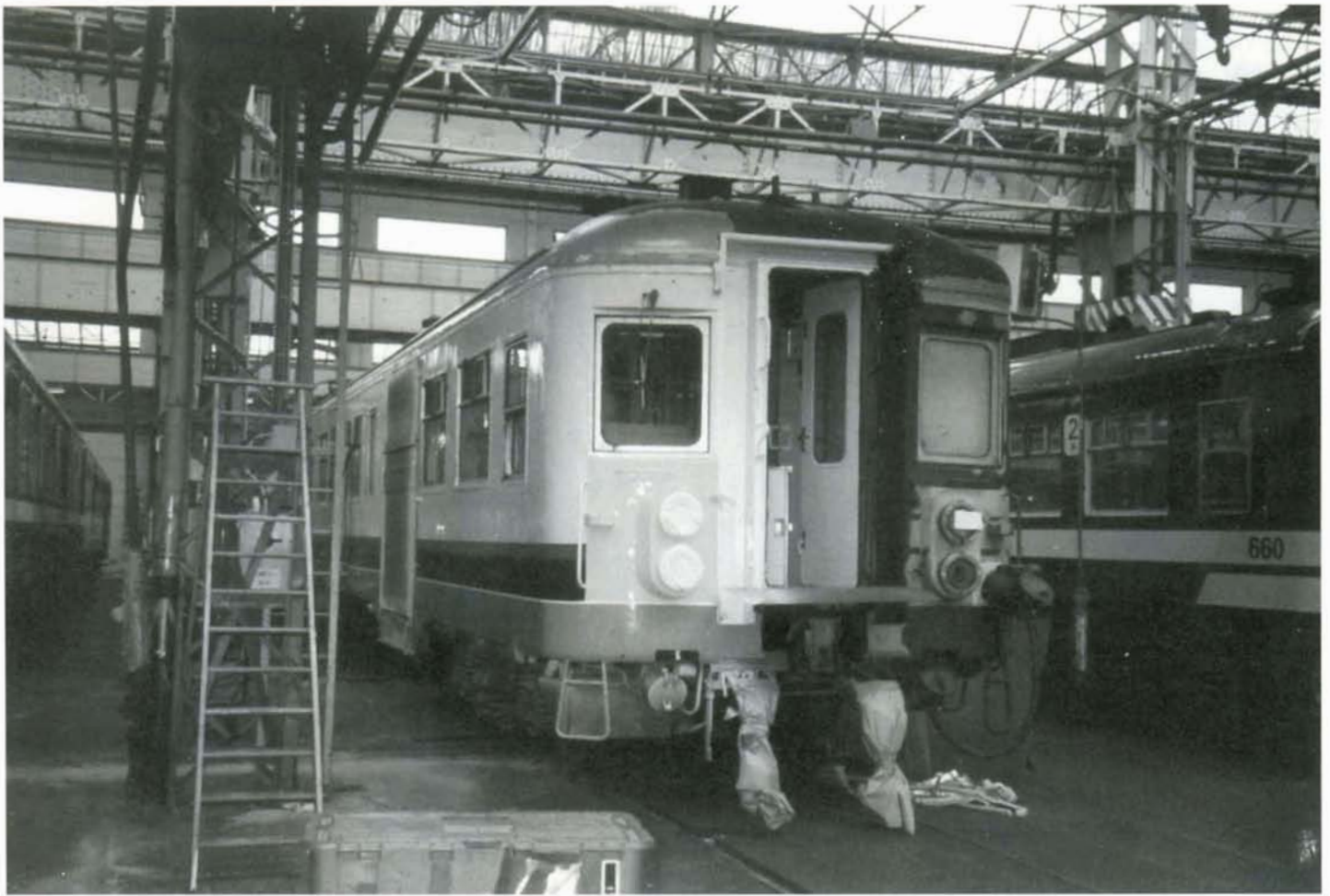
PHOTO 29-17 La voiture de seconde classe (1721) de l'automotrice 172 sert de banc d'essai pour la rénovation programmée des automotrices doubles classiques (595 à 782). Cette voiture a été repeinte dans la décoration I11, identique à celle appliquée sur les voitures M4 modernisées, et a reçu un tout nouvel aménagement intérieur. Atelier Central de Mechelen, 22 novembre 1996.
