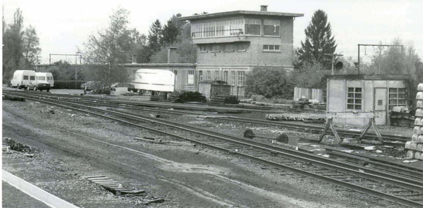
PHOTO 30-47 Le block 5 de Voroux mérite une attention toute particulière. Si extérieurement, le bâtiment n'offre rien d'exceptionnel, l'intérieur par contre recèle un superbe bâti électrique « ACEC ». Mise en service juste après la seconde guerre, cette cabine gérait la partie formation et triage de la gare; un triage automatique, situé à côté du bâti de signalisation et toujours fonctionnel, dirigeait les coupes vers leurs voies respectives. Amateurs de patrimoine, à vos postes! Voroux, 29 avril 1997. Photo : B. DIEU.
