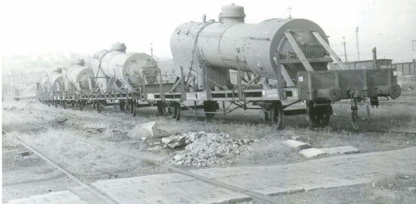
Le 6 septembre 1969 à Ronet, dix chaudières visiblement révisées, récupérées de locomotives des types 64 et 81, se trouvaient solidement arrimées sur des wagons. Sur le document ci-dessus, les trois premières chaudières sont respectivement celles des (entre parenthèses : date et dépôt de radiation) : 81.002 (03/1966, St.Ghislain), 81.266 (05/1966, Monceau) et 81.425 (05/1966, Monceau). Ci-dessous : un second lot de cinq chaudières. Nous ignorons complètement le sort qui leur fut réservé. Un lecteur peut-il nous répondre? Photo : Robert BODDEWIJN.
