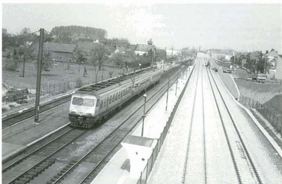
PHOTO 30-41 A hauteur de Lot, passage du train IC 837 Quiévrain-Schaerbeek. A droite, les deux voies TGV qui enjambent, à l'aide d'un viaduc, les deux voies de la ligne 96. Lot, 23 avril 1997. Photo : B. DIEU.
