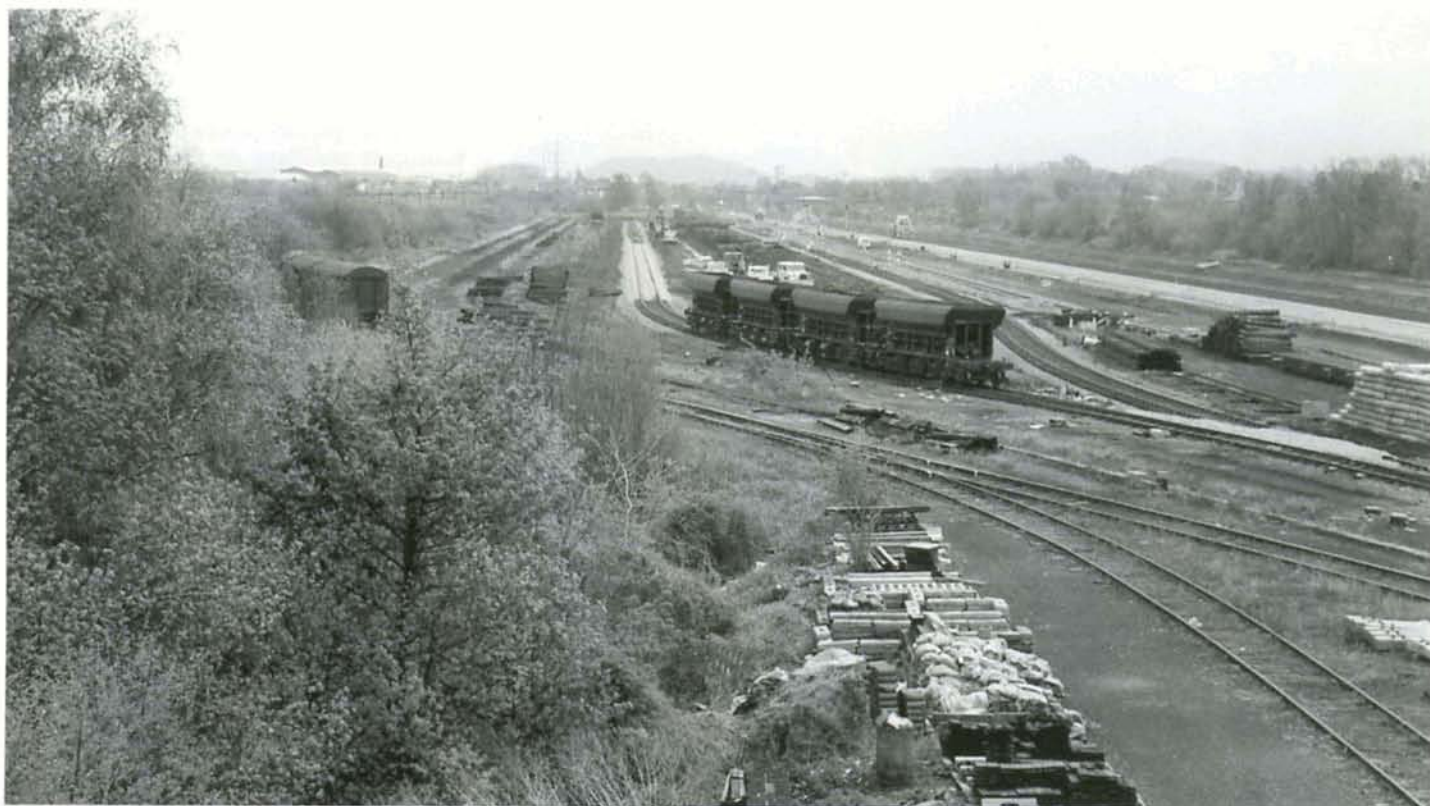
PHOTO 30-46 Prise du block 5 en direction de Ans, cette vue montre l'ancien faisceau de triage et de formation sur lesquels viendront s'ériger les futurs faisceaux « voies » et « caténaires ». En attendant leur construction, on y stocke des longueurs de voies prémontées et des traverses béton. Voroux, 29 avril 1997. Photos : B. DIEU.
