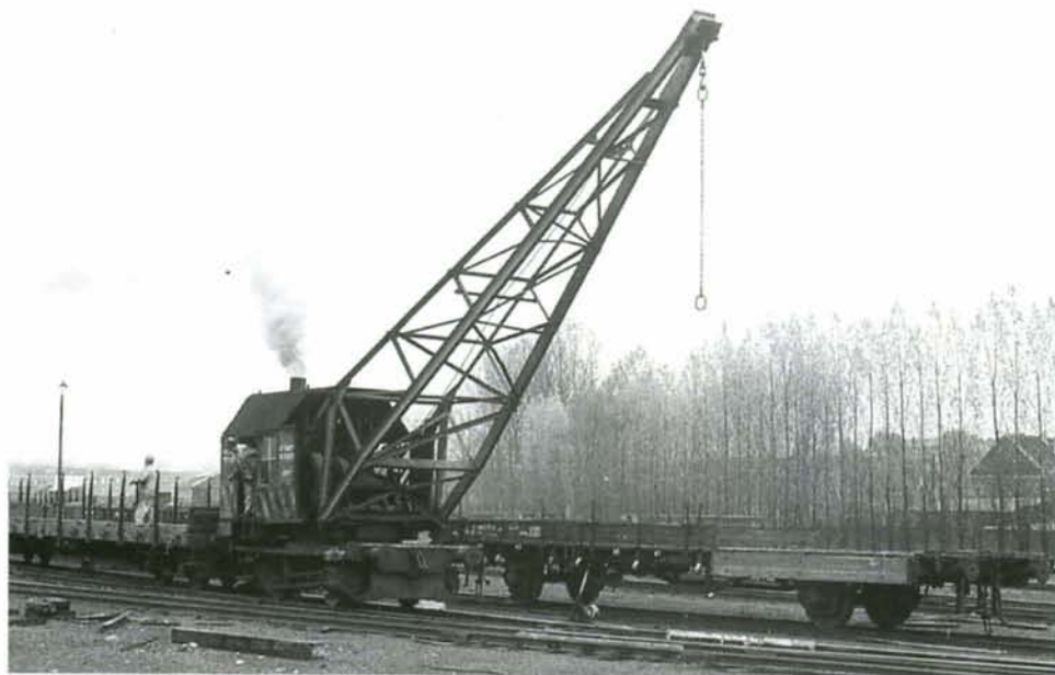
PHOTO 30-07NB Après 1967, d'autres véhicules fonctionnaient toujours à la vapeur : les grues. Jusqu'en 1980, l'Atelier Central de la voie de Schaerbeek utilisait encore la grue 320-1. Aujourd'hui encore, l'atelier de Kinkempois dispose d'une grue de relevage à vapeur. Il s'agit ici du tout dernier véhicule à vapeur en service à la SNCB. Photo : Pierre HERBIET, 31 octobre 1979.
