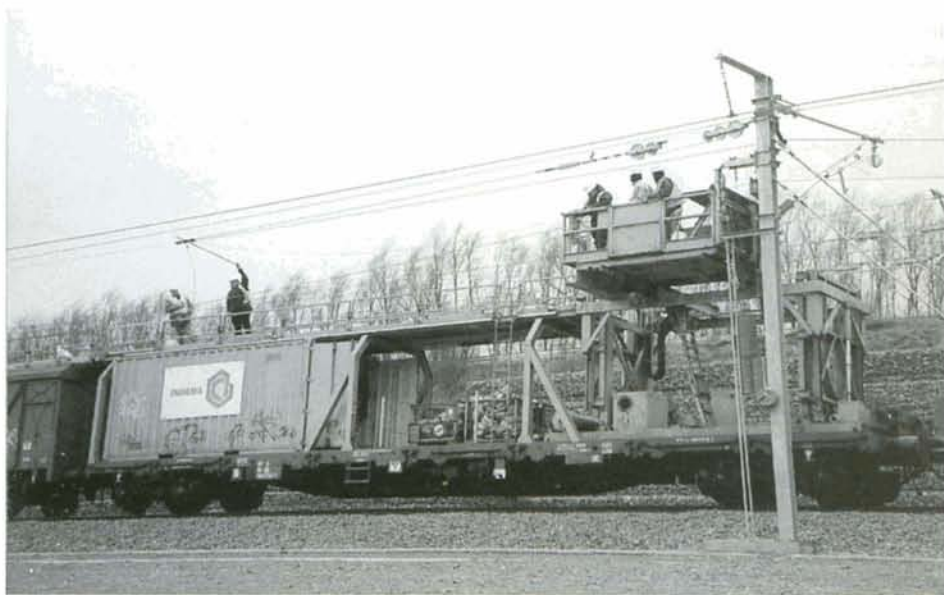
C'est la firme ENGEMA qui procède au déroulage du fil de contact à l'aide de nombreux véhicules spéciaux, tel ce wagon-passerelle qui travaille à hauteur d'un début de «tir», caractérisé par la présence d'appareils tendeurs. Petit-Enghien, 21 février 1997.
