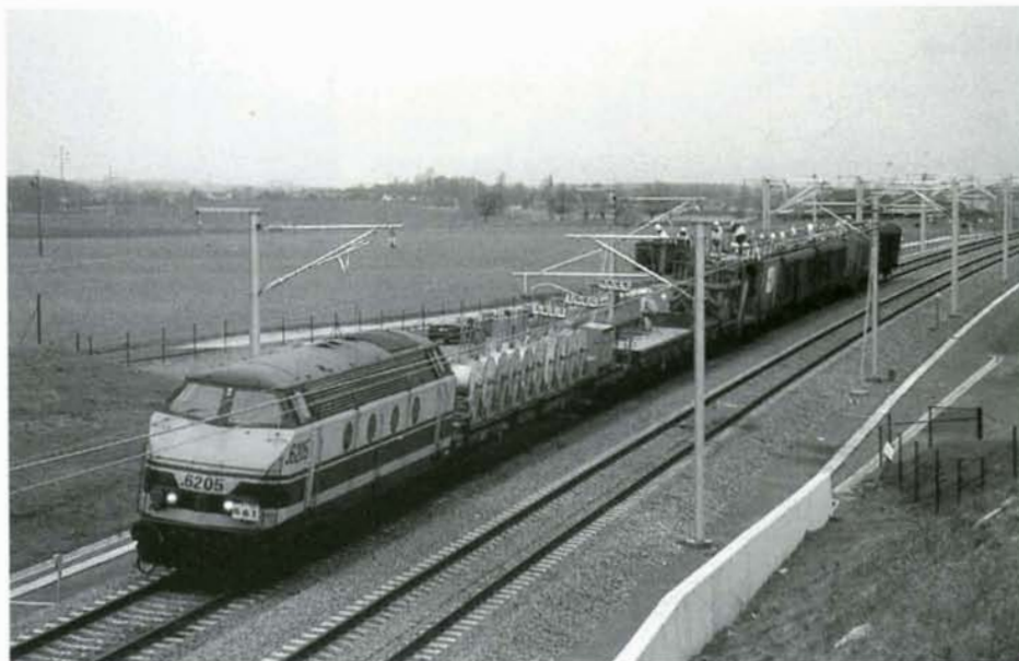
Mise en place des poteaux caténares à l'aide de la grue Labor montée sur wagon. La console supportant le feeder est prémontée à la base de St-Druon. Silly, mars 1997. Photo : Christian LE MEUT.
