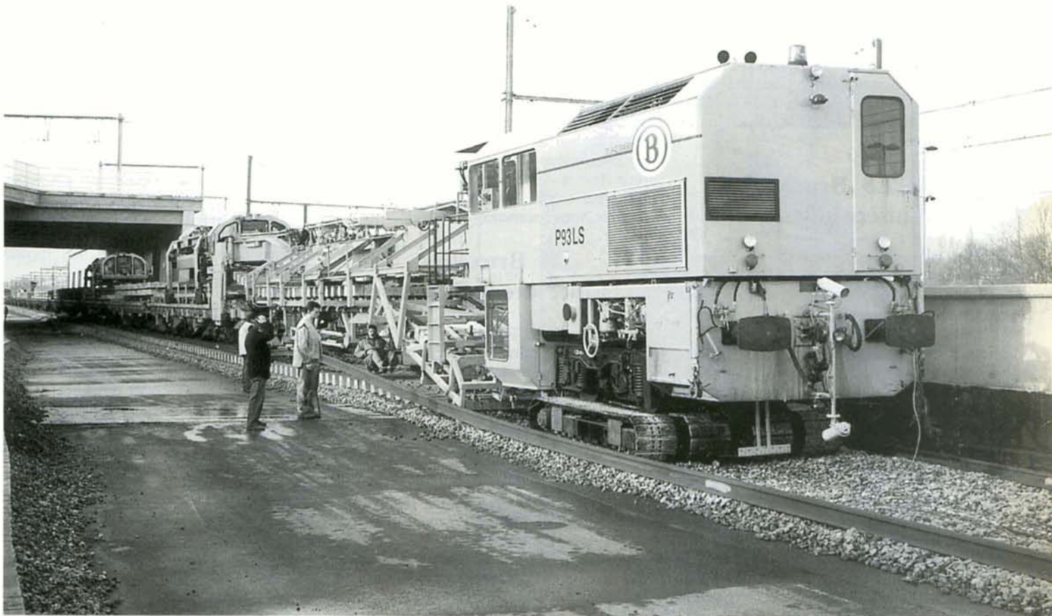
Le train de renouvellement P93 de la SNCB opère sous la ligne 26 à la sortie de Halle vers Bruxelles. On distingue nettement l'avant du train dont la chenille repose sur une sous-couche de ballast, tandis que l'arrière roule sur la nouvelle voie. La machine pose les traverses béton et positionne ensuite les longs rails soudés sur celles-ci. Halle, 11 mars 1997. Photo : Pierre HERBIET.
