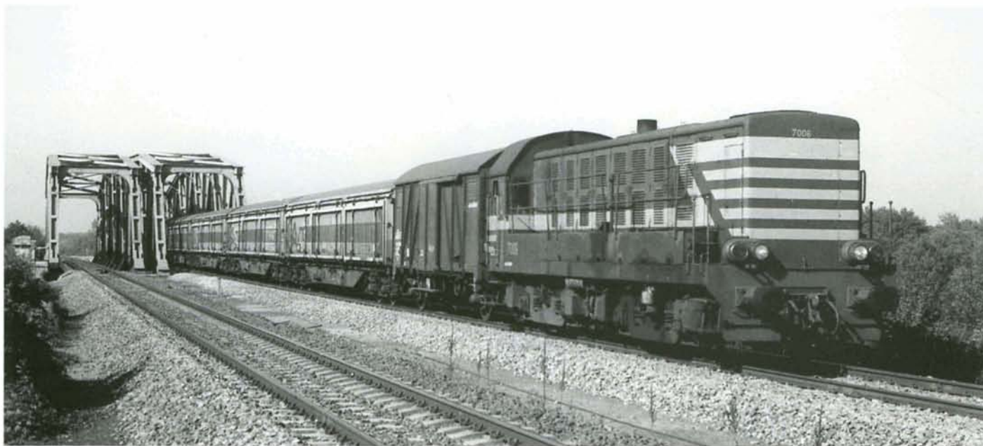
PHOTO 30-33 Le train de desserte du zoning industriel de Olen (ligne 15 Lier-Hasselt) vient de franchir le canal Albert à la sortie d'Herentals le 1er octobre 1985. Photos : Pierre HERBIET.
