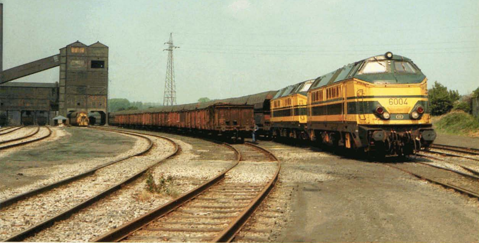
PHOTO 30-18 Après celle de Zeebrugge et d'Haren-Buda (Marly), la cokerie du groupe Carcoke de Tertre cessera à son tour ses activités dans les prochains jours. Le 24 mai 1987, un train de coke y attendait le départ, remorqué par deux locomotives prototypes de la série 60 : les 6004 et 6006. Photo : Serge MARTIN.
