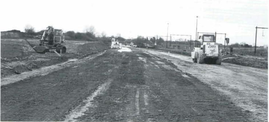
**PHOTO 33-41** La ligne 36 rectifiée à hauteur de l'ancien block 35 de Fexhe. les engins de terrassement procèdent à l'aménagement de la plate-forme avant mise en place des voies. Fexhe, 15 janvier 1998. Photo : B. DIEU.
