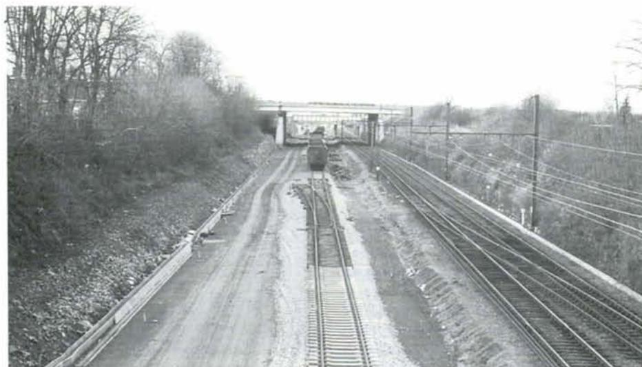
PHOTO 33-43 La ligne 36 photographiée à Ans vers Fexhe. A gauche, les deux voies de la ligne 36 rectifiées; à droite, les deux voies actuelles qui laisseront la place aux deux voies TGV. Ans, 15 janvier 1998. Photo : B. DIEU.
