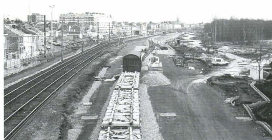
PHOTO 33-44 La gare de Ans en pleins travaux. Il ne reste que les deux voies principales en service. La voie de droite est la future voie 5, tandis que la voie 4 servira de voie d'évitement commune aux deux sens de circulation. Ans, 15 janvier 1998. Photo : B. DIEU.
