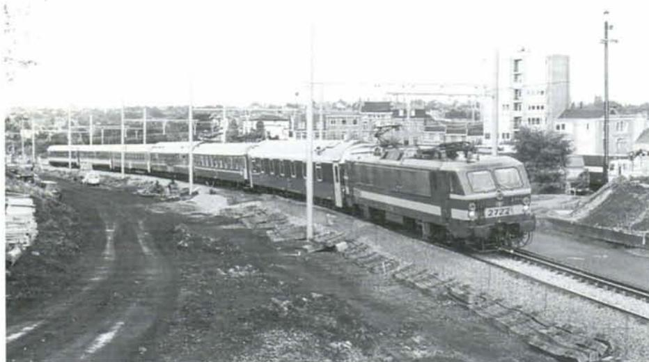
A Liège-Haut-Pré, la courbe est rectifiée pour permettre l'augmentation de la vitesse dans les plans inclinés. Le 13 septembre 97, le train international « Ost-West Express », emmené par la 2722 roule à contre-voie sur la nouvelle voie A, pendant l'aménagement de la voie B. Photo : Philippe VANDELOISE.
