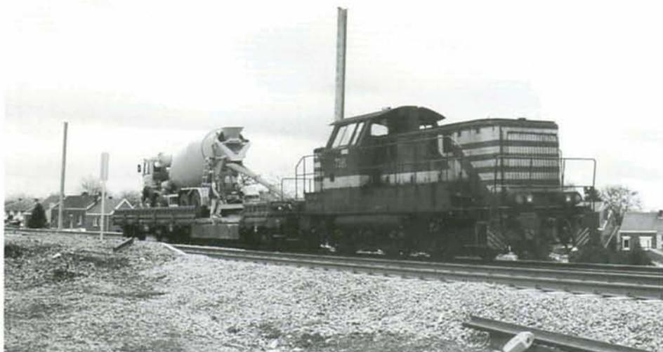
**PHOTO 34-47** Le bétonnage des poteaux caténaires de la ligne 36N entre Ans et Fexhe est assuré par un mixer routier placé sur un wagon plat. La 7381 de Kinkempois assure la remorque de ce train pour le moins singulier. Bierset, 20 avril 1998.
