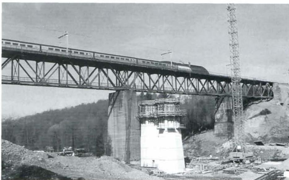
*Les travaux de construction du viaduc de Hammerbrücke. Au centre, la future pile qui supportera le tablier métallique. Le Thalys 9428 Cologne Paris-Nord passe sur l'ancien ouvrage à armature inférieure. Hergenrath, 22 avril 1998. Photo : M. LEBEAU.*
