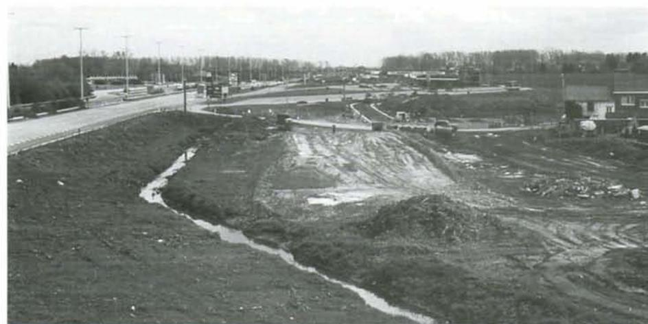
**PHOTO 34-49** A Bettincourt, à hauteur de la station-service autoroutière, les travaux avancent également. La voirie locale est en cours de déviation pour permettre la construction des ouvrages d'art qui permettront au TGV d'être en tranchée. 21 avril 1998.
