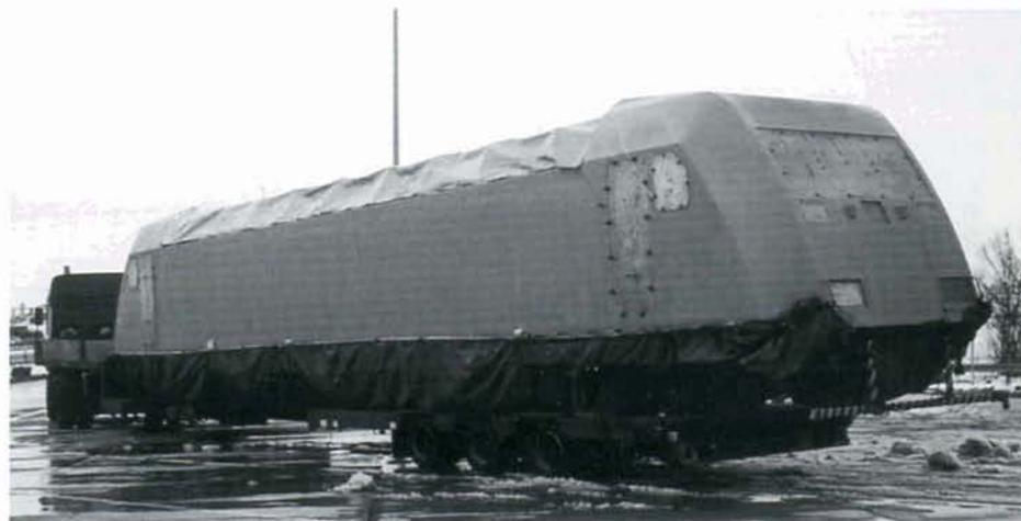
**PHOTO 34-18** *Les caisses des nouvelles locomotives de la série 101 de la DB sont assemblées par la firme polonaise PAFWAG. Elles sont ensuite transférées par... camions vers l'usine ADtranz de Kassel en Allemagne où la locomotive recevra tout son équipement. Une future 101 posée sur une remorque routière, photographiée sur un parking d'autoroute près de Dresden, le 8 décembre 1997. Photo : A. DEFECHEREUX.*
