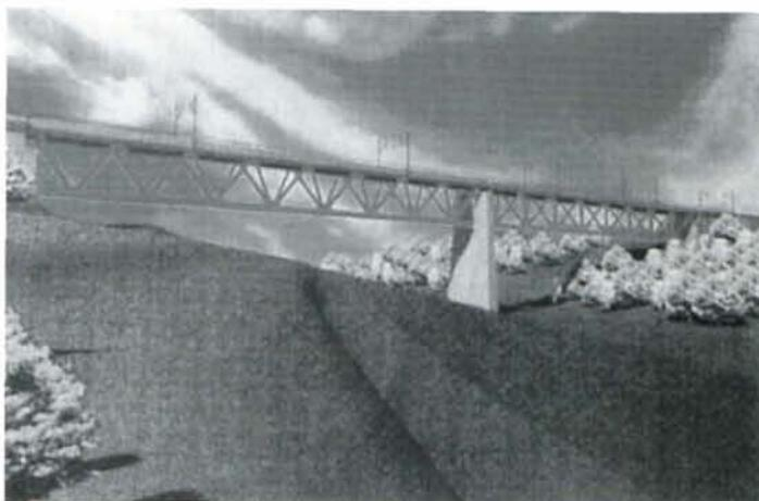
*Le futur viaduc de Hammerbrücke sera constitué de deux tabliers mixtes fer/béton supportés par une pile centrale. L'architecture n'est pas sans rappeler l'ancien ouvrage, avec l'armature inférieure notamment. Document : SNCB.*
