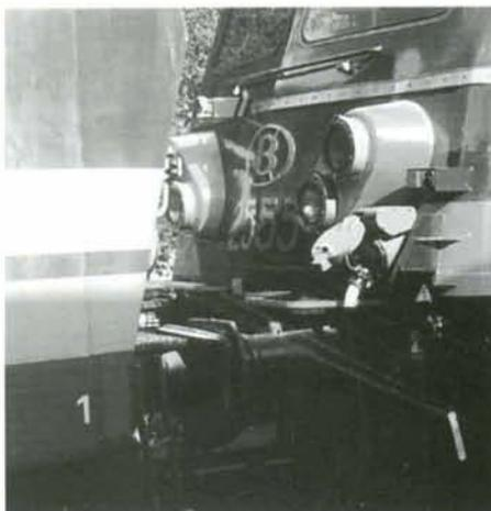
*Les 25.5 ont été équipées du coupleur ACEC pour la réversibilité, installé à l'extrémité droite de chaque face avant, à côté des phares. Ici, la 2555 à Antwerpen-Dam pendant les essais du nouvel équipement, le 19 mars 98.*
