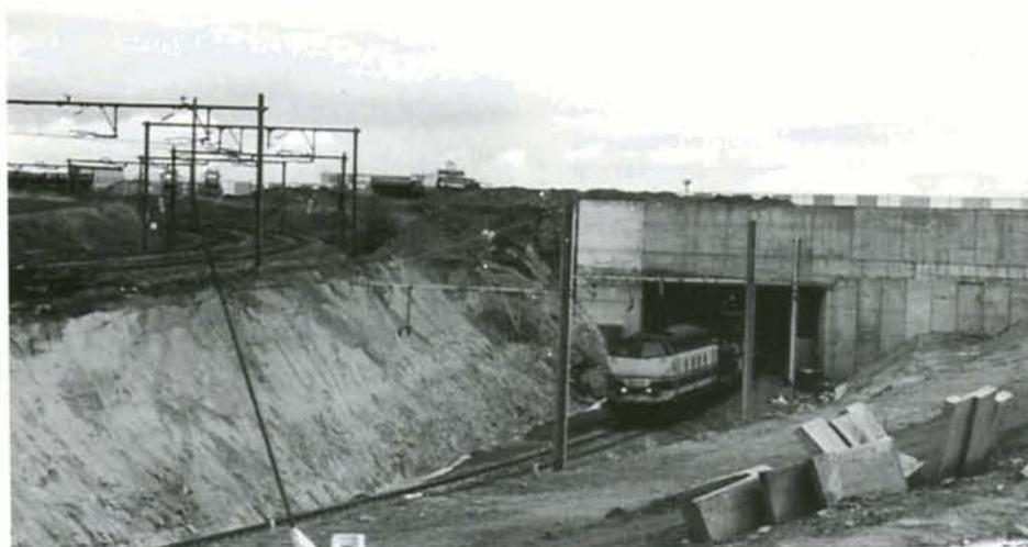
La nouvelle ligne 36C et la nouvelle gare de Bruxelles-National-Aéroport ont été mises en service le 1er mai dernier. Le 18 avril, un train d'électrification CEI remorqué par la 6299 opère sur la nouvelle voie B, à hauteur du tunnel passant sous la piste 07 de l'aéroport. Photo : Marc GRIETEN.
