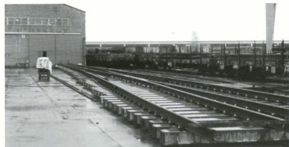
L'Atelier Central de l'Infrastructure de Bascoup a prémonté le tout premier appareil de voie SNCB monté sur des traverses en béton. Il sera ultérieurement posé en gare de Trois-Ponts, Bascoup, 3 avril 1998. Photo : Jacques DELFORGE.
