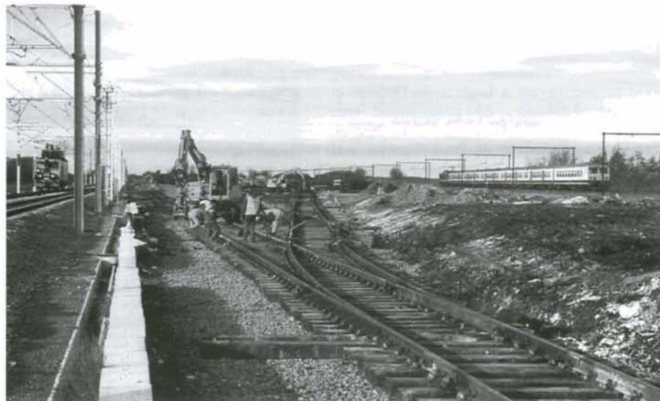
PHOTO 37-57 Le futur faisceau de formation des trains de la base de Voroux, est établi sur les anciennes voies "Formation" de l'ex. gare de triage; les premiers appareils de voie sont en place. A droite, passage d'un IC pour St-Ghislain sur la ligne 36 dont le tracé sera abandonné en février. Voroux, 19 janvier 1999. Photo : Baudouin DIEU.
