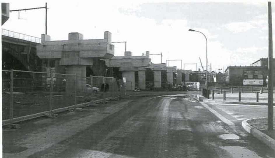
PHOTO 37-54 La construction de la nouvelle ligne 50A entre la sortie de Bruxelles-Midi et la bifurcation de la ligne 50A/1 se poursuit. Les piles en béton s'approprient à recevoir les ponts-bacs. Forest, 29 janvier 1999. Photo : Baudouin DIEU.
