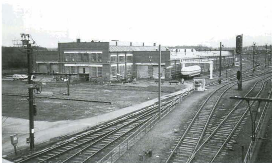
Ces deux vues de l'atelier de Saint-Ghislain prises côté sud et nord nous montrent bien la superficie importante occupée par le site. Seules les deux voies de droite (photo du haut) ne sont, pour l'instant, pas disponibles pour le PFT. Ci-dessus, vue prise depuis le pont enjambant la gare. Ci-dessous : PHOTO 37-01 ↓ Vue prise de l'autre côté, alors que le 554.18 assure des parcours de démonstration lors de la première journée "portes ouvertes" du samedi 12 décembre 1998. Photos : Armand THONET et Jean-Luc VANDERHAEGEN.
