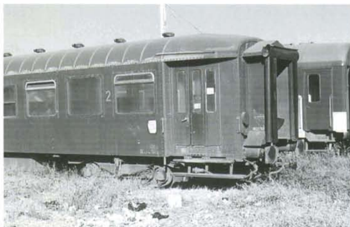
PHOTO 37-26 et PHOTO 37-27 Les voitures belges n'ont subi que peu de modifications après leur arrivée au Maroc. Parmi les plus visibles, on notera le remplacement des soufflets d'intercirculation par des caissons munis de bourrelets de caoutchouc, et l'échange de certains bogies par des bogies provenant d'anciennes voitures françaises. Seules les voitures récemment révisées ont été repeintes dans les nouvelles couleurs de l'ONCF, soit une trentaine d'unités dont les 8 K2 BD transformées en fourgon-générateur et les 10 I3; les autres voitures encore vertes n'ont jamais été repeintes depuis leur départ de Belgique. Ci-dessus à gauche, gros plan sur une plateforme d'accès de la voiture 1464, montée sur des bogies français du type Y20. Fès, 3 octobre 1998. Ci-dessus à droite : la voiture 1285, ex. K2 SNCB 50 88 21 48156-3, montée sur des bogies français du type Y26. Meknès, 5 octobre 98. Photo : J-L VANDERHAEGEN.
