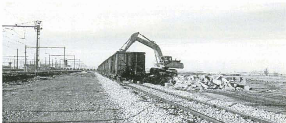
PHOTO 37-61 Les décombres provenant d'Antwerpen-Centraal et Berchem sont déchargés long du faisceau C2 d'Antwerpen-Noord, à l'endroit où la SNCB construit le plus grand terminal conteneurs de la Métropole. Anwerpen-Noord, 15 janvier 1999.
