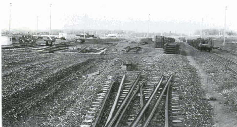
PHOTO 37-51 La base de St-Druon est démontée et les éléments constitutifs transférés vers Voroux. C'est l'entreprise Soluxtrafer qui est chargée des travaux de voies sur les deux bases. St-Druon, le 4 février 1999. Photo : Baudouin DIEU.
