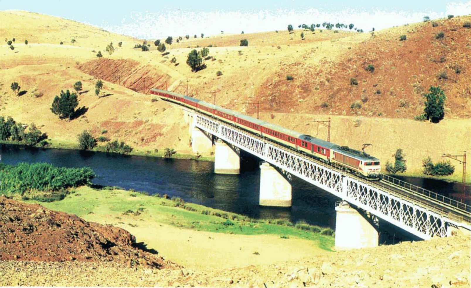
PHOTO 37-32 Le train MNRI Fès - Marrakech remorqué par la E 1306 franchit l'Oum er Rbia sur un remarquable ouvrage métallique. Mechra Benabbou, 8 octobre 1998.
