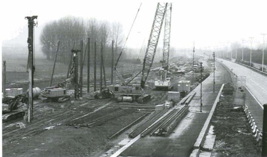
PHOTO 37-56 A Bettincourt, les travaux à hauteur de la station-service se poursuivent; le pont de la route nationale 752 a été coupé pour permettre son élargissement et la modification de l'accès. Bettincourt, 3 février 1999. Photo : Baudouin DIEU.
