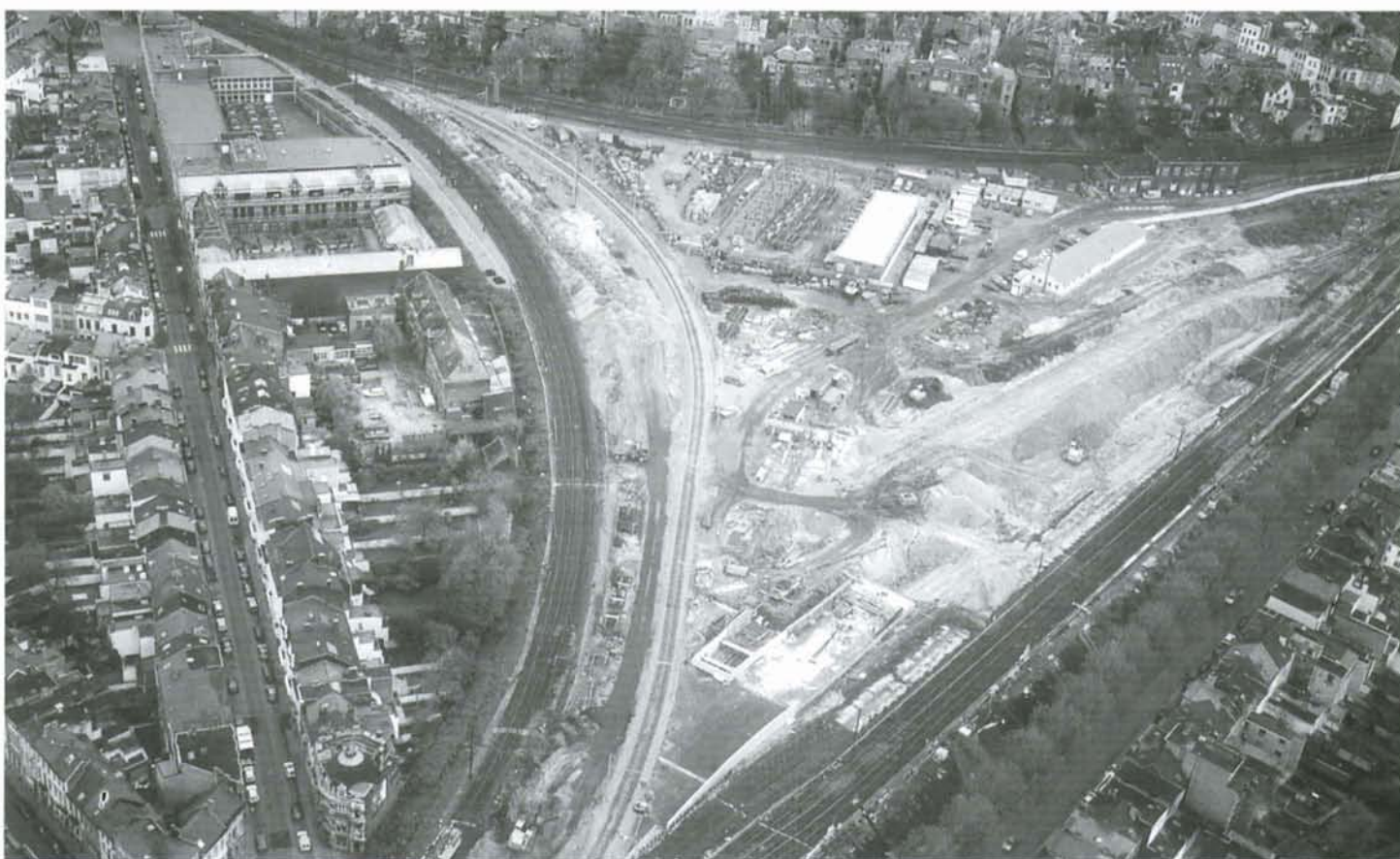
PHOTO 37-63 Vue aérienne du chantier de Berchem. On distingue nettement le creusement de la trémie d'accès vers la gare souterraine, de même que le chantier de chargement des wagons, dans le triangle des lignes 12/27/25. C'est à cet endroit que se trouvait jadis la remise aux locomotives de Berchem, dont il ne reste plus qu'un seul bâtiment administratif.
