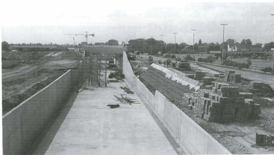
**PHOTO 39-71** Les travaux à hauteur de la station-service de Bettincourt, vers Bruxelles. A droite, un mur antibruit est constitué de déchets de bouteilles en plastique... Bettincourt, 20 juillet 1999. Photo : Baudouin DIEU.
