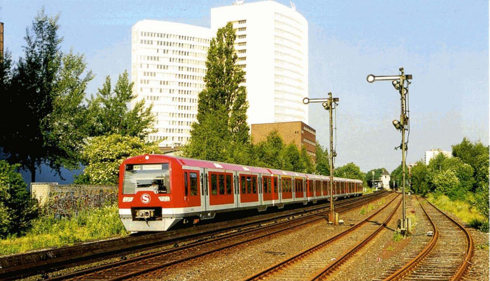
PHOTO 41-11 Un train composé de deux nouvelles automotrices de la série 474, photographié sur la ligne S-Bahn S1 Wedel - Hamburg - Poppenbüttel, le 7 juin 1999. Pierre HERBIET.
