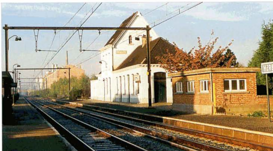
PHOTO 41-30 Dans le cadre des travaux de mise à quatre voies de la ligne 36 entre Bruxelles et Leuven, la gare d'Herent a été démolie dans le courant du mois de décembre 1999. Voir également à ce sujet notre rubrique "Le point sur les travaux TGV". 9-11-1990.
