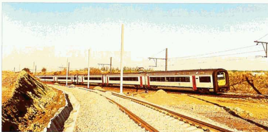
PHOTO 41-27 Une vue prise le 4 novembre 1999, de la construction de la nouvelle voie A de la ligne 21, à la sortie de Landen. Sur la voie B, on aperçoit l'IC-K 2236 Genk - Gent-St.Pieters assuré par les automotrices 486 + 504. Marc GRIETEN.
