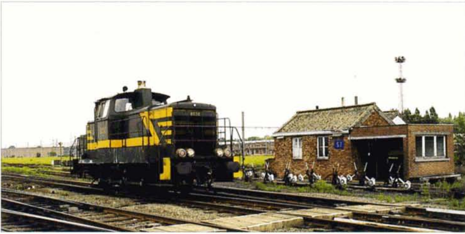
PHOTO 41-55 Le poste de signalisation SI de Schaerbeek-formation commande la tête sud du groupe B. Datant de 1943, il devrait disparaître dans le courant de cette année. Ce genre de poste à terre devient extrêmement rare sur notre réseau. Kristof AVONDS, juin 1998.
