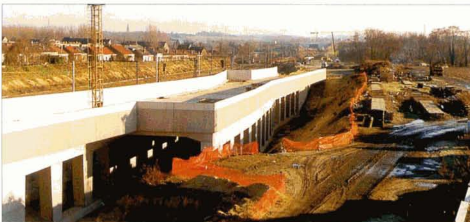
PHOTO 41-65 Leuven, Bifurcation Tivoli, vers Liège. Le saut-de-mouton qui sera emprunté par les deux voies TGV et qui leur permettra de franchir la voie B de la ligne 36. Leuven, 24 janvier 2000. Baudouin DIEU.
