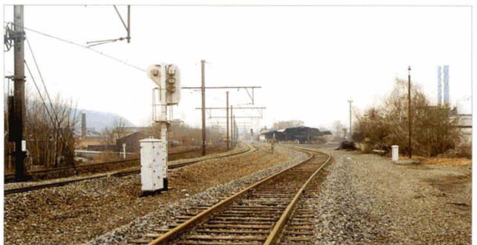
PHOTO 41-72 A Chênee, une voie est posée pour permettre l'évacuation des déblais du futur tunnel, à l'emplacement de l'ancienne ligne 38. Chênee, 17 janvier 2000. Baudouin DIEU.
