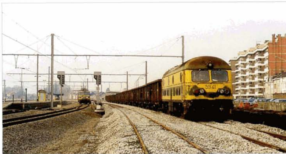
PHOTO 41-69 Les voies 1 et 2 en gare d'Ans sont en cours de pose. Et toujours une 59 bien présente... A la voie 3 stationne la 2250, qui assure le service d'allège sur les plans. Ans, 17 janvier 2000. Baudouin DIEU.
