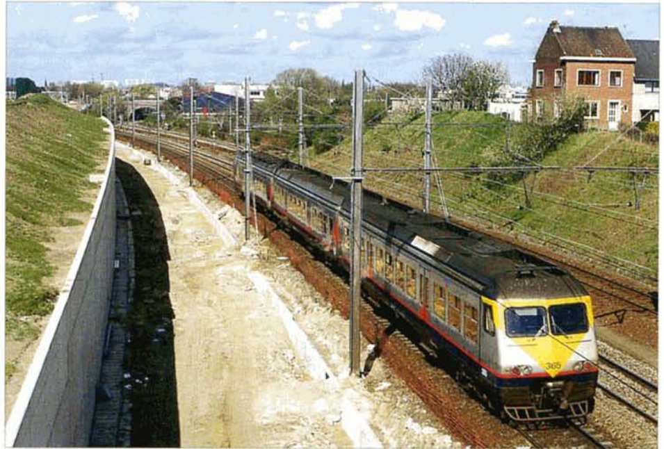
PHOTO 42-76 Diegem, le 17 avril 2000. Venant de Bruxelles, un train de voyageurs se dirige vers Leuven. A gauche, la plate-forme de la future voie B de la ligne 36. Baudouin DIEU.
