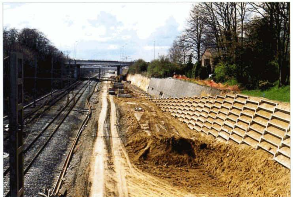
PHOTO 42-80 La sortie de la gare de Ans vers Waremme. A gauche, la ligne 36. La plateforme est prête à recevoir la voie. Ans, 26 avril 2000 Baudouin DIEU.
