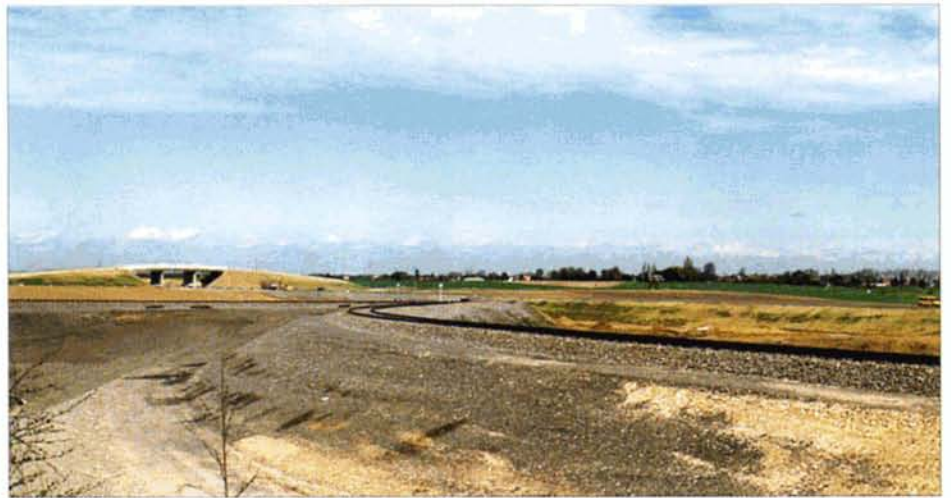
PHOTO 42-79 La courbe de raccord entre la base de Voroux et la LGV. Baudouin DIEU.
