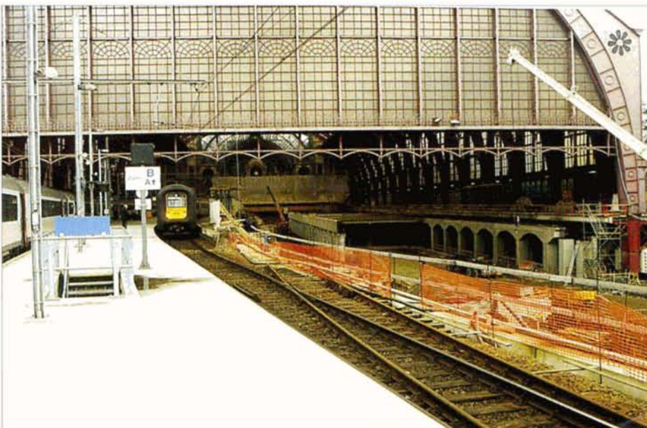
Les impressionnants travaux à Antwerpen-Centraal, photographiés le 2 mars 2000. Roger CRIKELAIRE.
