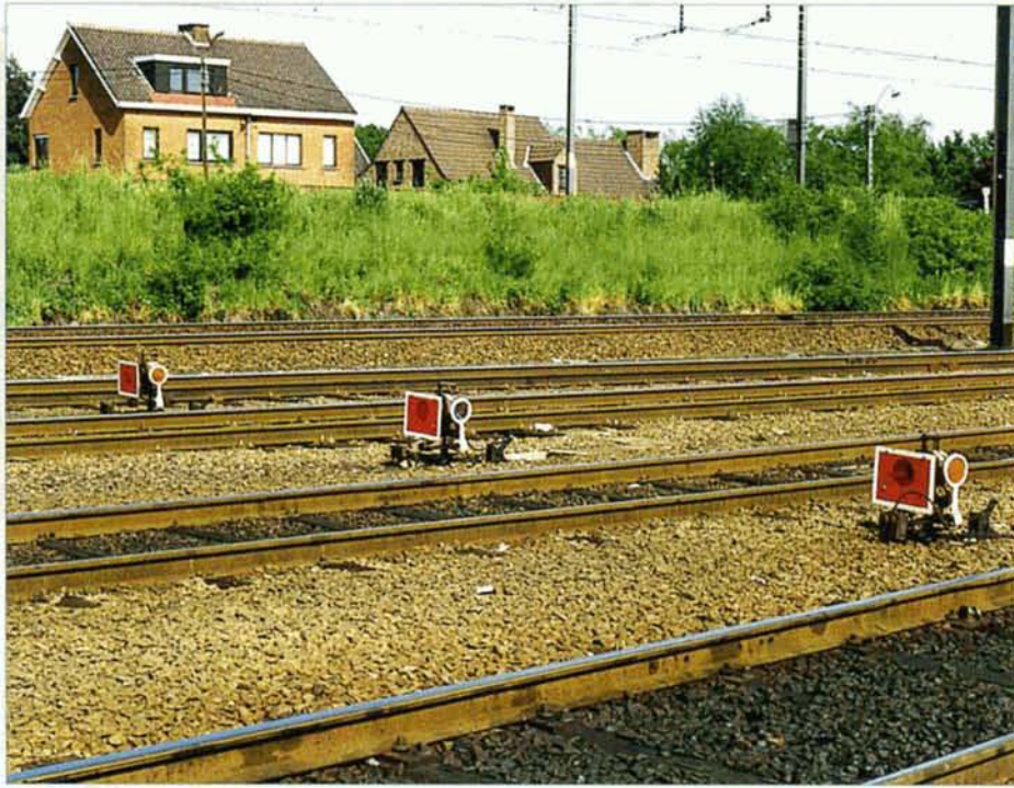
PHOTO 42-55 La belle brochette de signaux d'arrêts simplifiés qui étaient placés à l'extrémité des voies du faisceau A. Jean-Luc VANDERHAEGEN, 16 mai 1997.
