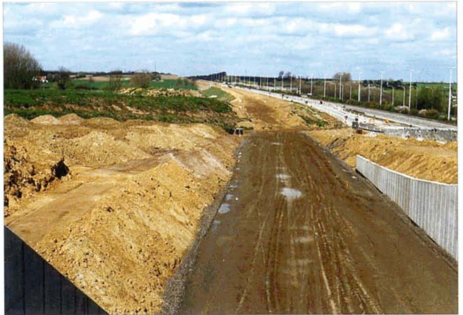
PHOTO 42-78 L'avancement des travaux le long de l'autoroute Bruxelles-Liège à hauteur de Boutersem, le 17 avril 2000. Baudouin DIEU.
