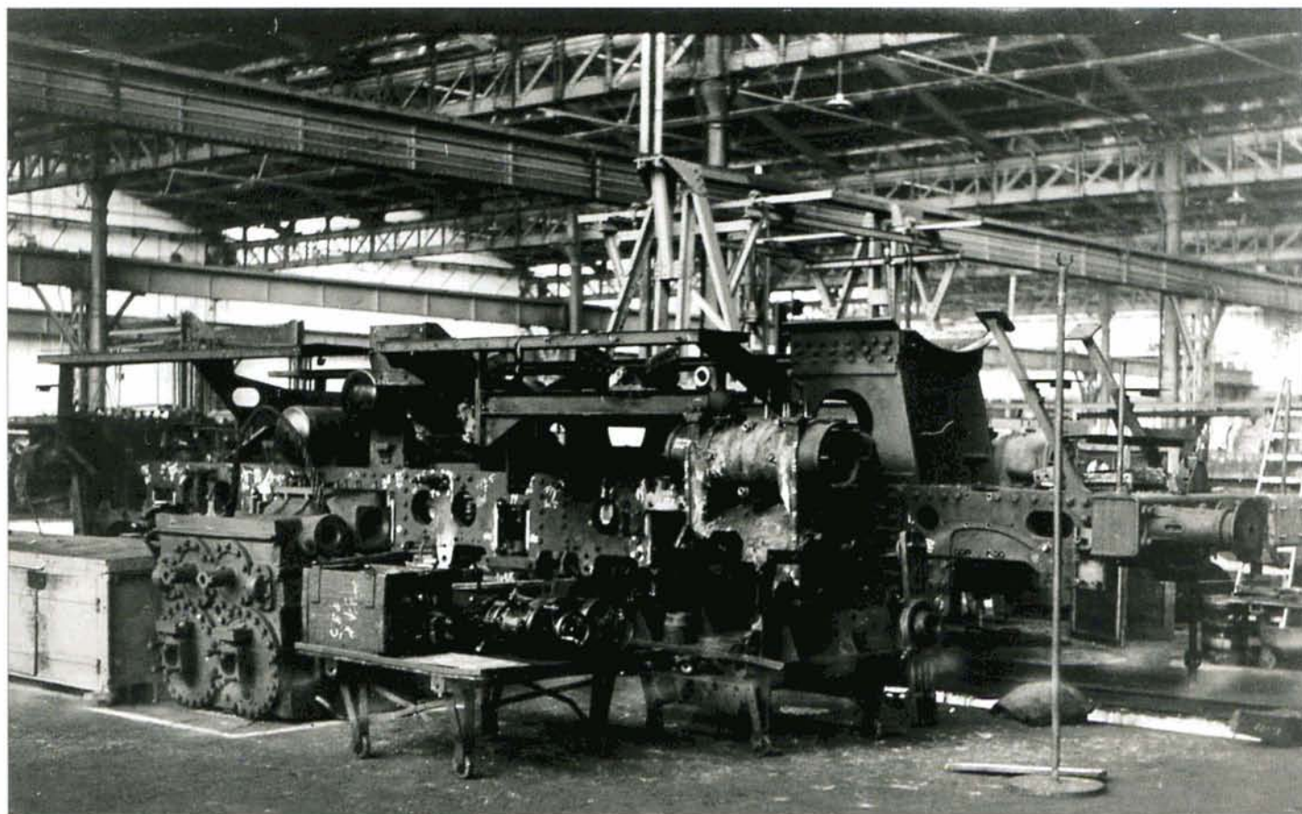
PHOTO BD-099 Le châssis d'une locomotive du type 26 non identifiée en cours de grande réparation. Les Ateliers centraux effectuaient les moyennes et grandes réparations. Les moyennes réparations étaient caractérisées par la réparation du châssis, des cylindres, du mécanisme, des roues, des organes de frein, de suspension, de choc et de traction, mais sans travail important à la chaudière. Les grandes réparations consistaient en la réparation complète du châssis, des cylindres, du mécanisme, des roues, des organes de frein, de suspension et de traction, ainsi qu'une réparation complète de la chaudière.
