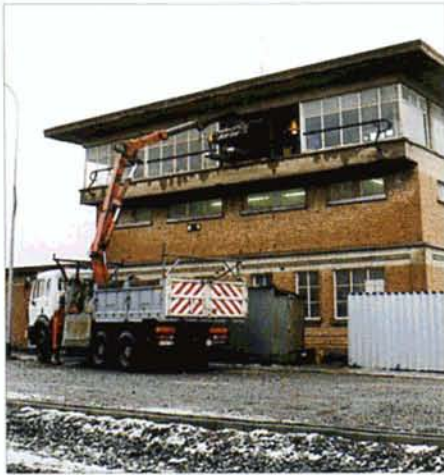
Le déménagement du bâti électrique "ACEC" de l'ancien block 5 de Voroux, qui se trouve actuellement dans l'abris-musée de Saint-Ghislain. Baudouin DIEU.
