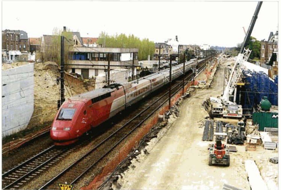
PHOTO 42-77 Les travaux en gare de Zaventem. A droite, construction des murs de soutènement pour élargir la plate-forme à quatre voies. Le 19 avril 2000 Baudouin DIEU.
