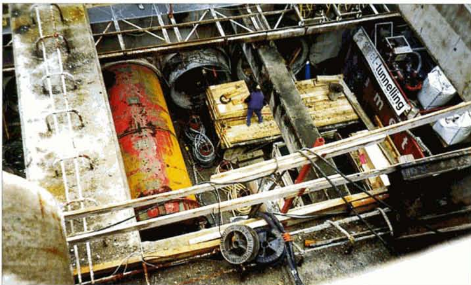
Des mini-tunneliers percent la voûte du futur tunnel de jonction Nord-Sud sous le bâtiment de la gare d'Antwerpen-Centraal, le 15 avril 2000. Baudouin DIEU.
