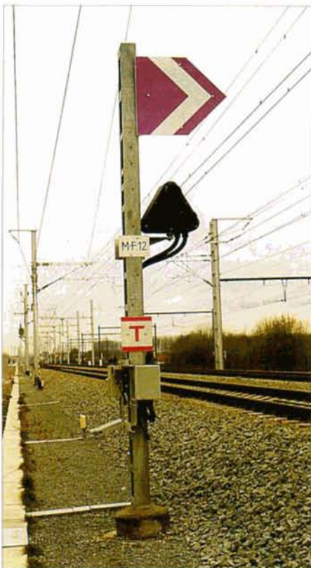
PHOTO 43-11 Un «petit repère». Le franchissement du signal est autorisé lorsque les deux feux blancs apparaissent sur le boîtier triangulaire noir. Ce modèle de repère est implanté à proximité des appareils de voie (voies d'évitements par exemple) où des manoeuvres sont susceptibles d'être effectuées. Ph. SCHOLL.
