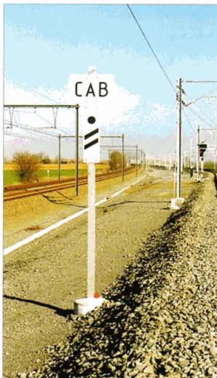
PHOTOS 43-99 et 43-13 Les deux panneaux «CAB» : à gauche, le panneau d'approche d'un signal CAB est monté sur une balise (à la sortie de la base du Coucou). Le conducteur d'un véhicule non équipé de la TVM sait ainsi qu'il ne pourra pas franchir le signal suivant, quel que soit l'aspect présenté par celui-ci. A droite, un panneau de fin de zone à signalisation de cabine, ici celui implanté à la sortie du viaduc de Lembeek et jumelé avec un triangle indiquant la vitesse de référence de la ligne 96N : 160 km/h. Ph. SCHOLL.
