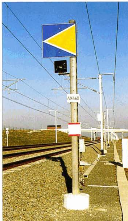
PHOTOS 43-08 - 43-09 - 43-10 Trois modèles de «grands repères» (tous trois sont des repères de contre-voie, puisqu'ils sont placés à droite de la voie parcourue): les deux premiers sont permissifs permanents ; celui de droite, muni d'un oeillette de franchissement, du panneau à deux bandes rouges et T rouge, ainsi que du boîtier pouvant présenter les feux blanc et rouge, est permissif par intermittent et transforme un grand mouvement en petit mouvement lorsque ces feux sont allumés. Philippe SCHOLL.
