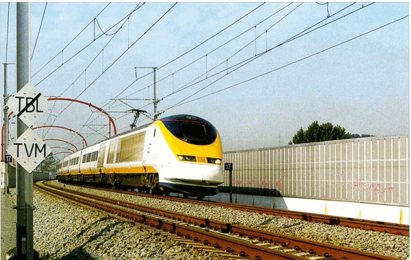
PHOTO 43-14 Implanté à l'entrée du viaduc de Lembeek, panneau de transition entre les deux systèmes de signalisation de cabine : de la TBL, qui est actuellement en développement à la SNCB, vers la TVM, d'origine française. Philippe SCHOLL.
