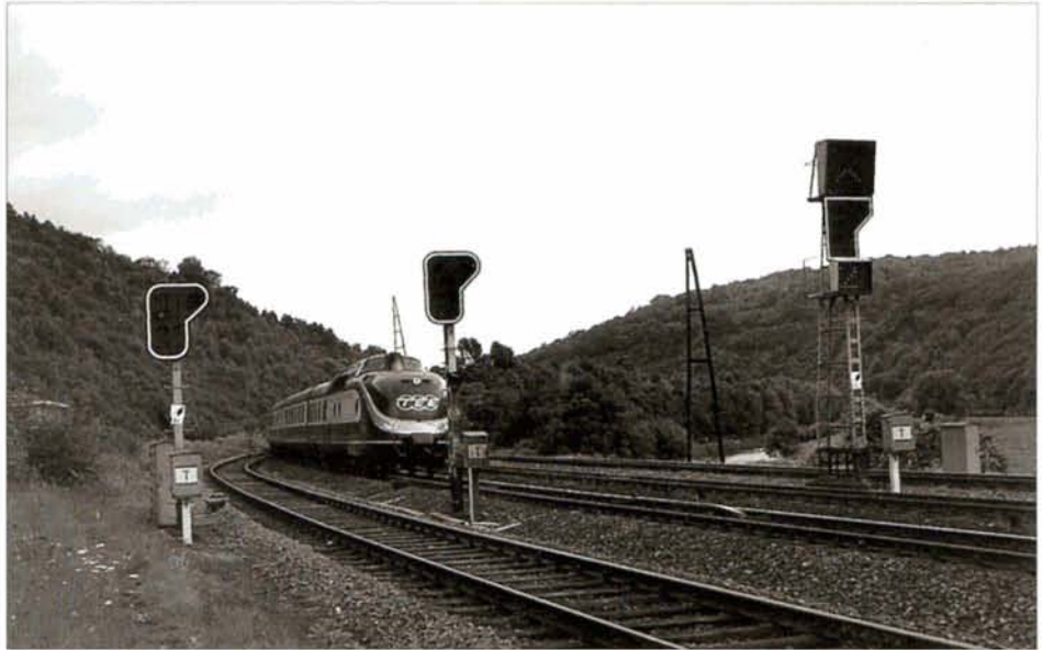
PHOTO BD-104 Nous sommes maintenant un peu plus loin sur la ligne, à Olne, où sont aménagées deux voies de garage. Vers 12.05, le TEE M19 "Saphir" Frankfurt - Oostende, assuré par une rame TEE du type VT11.5 de la DB, s'éloigne vers Liège.
