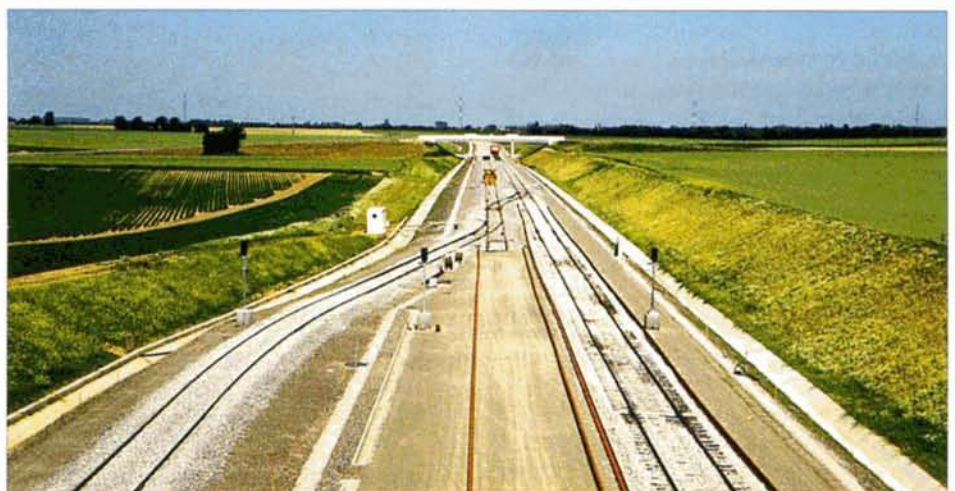
A hauteur de Voroux, la pose du " poste de raccordement " est entamée. A gauche, la voie qui donne accès à la base de travaux. Voroux, 17 juin 2000. Armand THONET.
