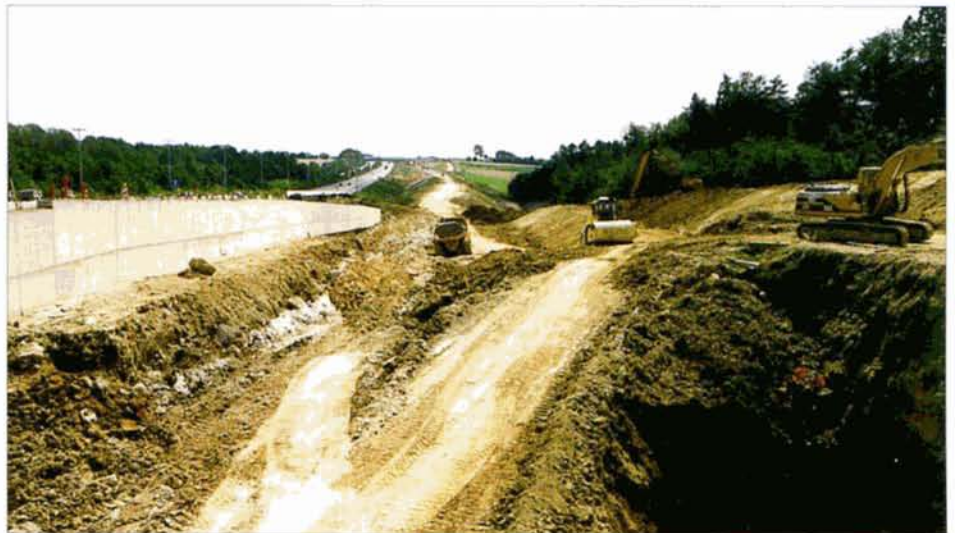
PHOTO 43-83 L'avancement du chantier à hauteur de Lincent. Il reste encore pas mal de travail à effectuer avant la pose de la superstructure, 28 juillet 2000. Baudouin DIEU.
