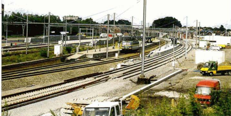
PHOTO 43-82 La gare d'Ans a trouvé sa physionomie définitive avec ses cinq voies à quai. Les voies 1 et 2 ne seront accessibles que pour les trains circulant sur la LGV. Ans, 28 juillet 2000. Baudouin DIEU.
