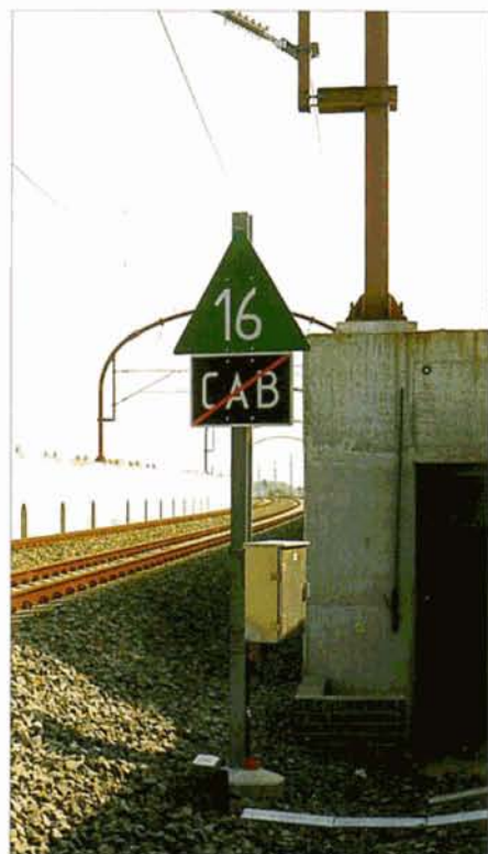
PHOTOS 43-99 et 43-13 Les deux panneaux «CAB» : à gauche, le panneau d'approche d'un signal CAB est monté sur une balise (à la sortie de la base du Coucou). Le conducteur d'un véhicule non équipé de la TVM sait ainsi qu'il ne pourra pas franchir le signal suivant, quel que soit l'aspect présenté par celui-ci. A droite, un panneau de fin de zone à signalisation de cabine, ici celui implanté à la sortie du viaduc de Lembeek et jumelé avec un triangle indiquant la vitesse de référence de la ligne 96N : 160 km/h. Ph. SCHOLL.
