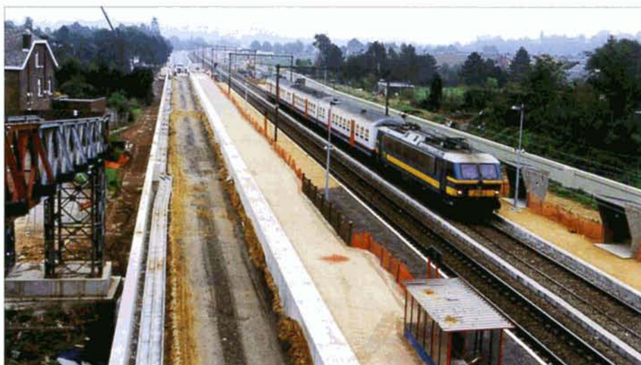
PHOTO 44-71 Cette vue de la gare de Kortenberg appartiendra bientôt au passé. Un train IC pour Bruxelles et Gand passe devant le BV, qui disparaîtra prochainement du paysage. A gauche, le quai de la voie A a été allongé pour permettre le creusement du passage sous voies à hauteur de la grue. Kortenberg, 2 octobre 2000.
