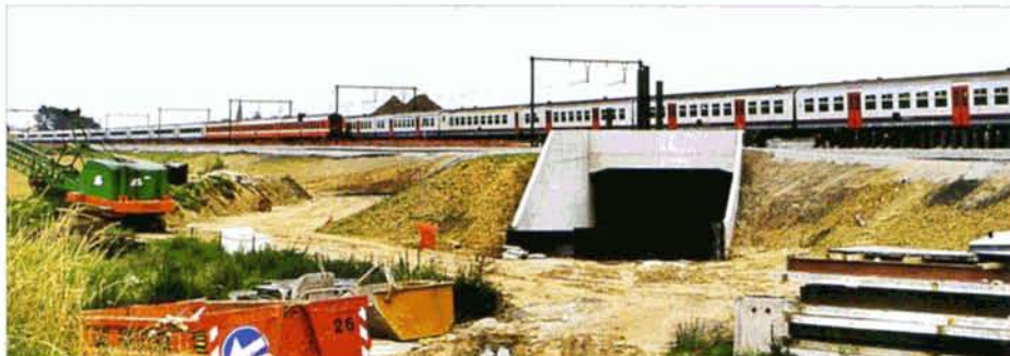
PHOTO 44-70 Entre Zaventem et Nossegem, deux IC se croisent au-dessus de l'ouvrage qui permettra de rejoindre l'aéroport en venant de Leuven. M. GRIETEN, 7 août 2000.
