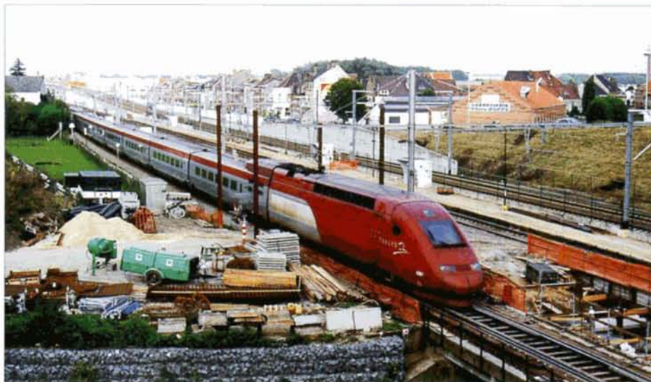
PHOTO 44-67 Passage à Lot d'une rame TGV vide se rendant à l'atelier de Forest. La voie B est démontée et on distingue nettement les travaux de construction du pont sur la Senne. Lot, 3 octobre 2000. Baudouin DIEU.
