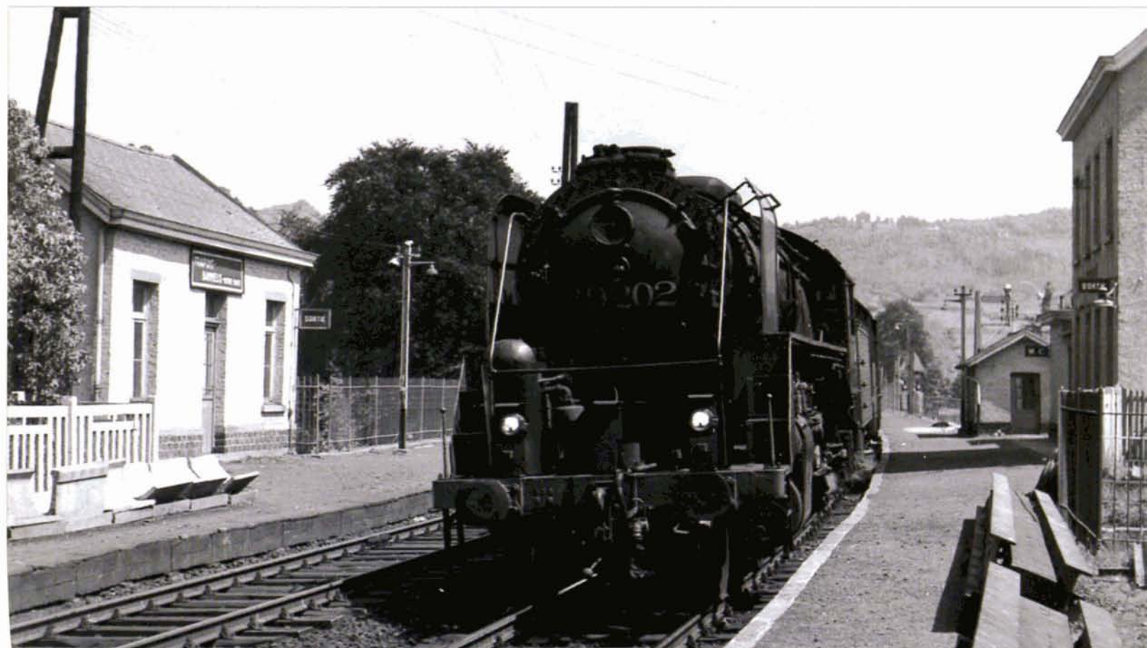
PHOTO BD-116 Quelques minutes plus tard, en sens inverse, passage du caboteur 44231 Dolhain 12.56 - Kinkempois 15.43, remorqué par la 29.202 du dépôt de Kinkempois. Cette locomotive vivait alors ses tous derniers jours; sa carrière s'achèvera le 27 septembre. Construite par la Canadian Locomotive Co., elle fut mise en service le 28 août 1946 à Jemelle, et transférée en mars 1958 à Kinkempois.
