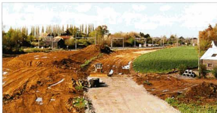
PHOTO 44-38 et PHOTO 44-39 Les travaux de reconstruction de la ligne 147 entre Fleurus et Tamines avancent à grands pas. La pose de la voie a été entamée dans le courant du mois de septembre. Ces deux vues montrent l'état d'avancement des travaux de terrassements en juillet. A gauche, à la sortie de la gare de Fleurus, à l'emplacement de la bifurcation avec la ligne 140 Ottignies - Charleroi. A droite, dans les environs de Lambusart, l'assiette est terminée.
