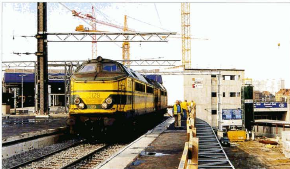
PHOTO 44-27 En septembre dernier, deux locomotives de la série 51 ont procédé aux essais sous charge du tablier de la nouvelle voie 3 de Bruxelles-Midi. Cette voie a été mise en service le 2 octobre 2000. Alain DEFECHEREUX.
