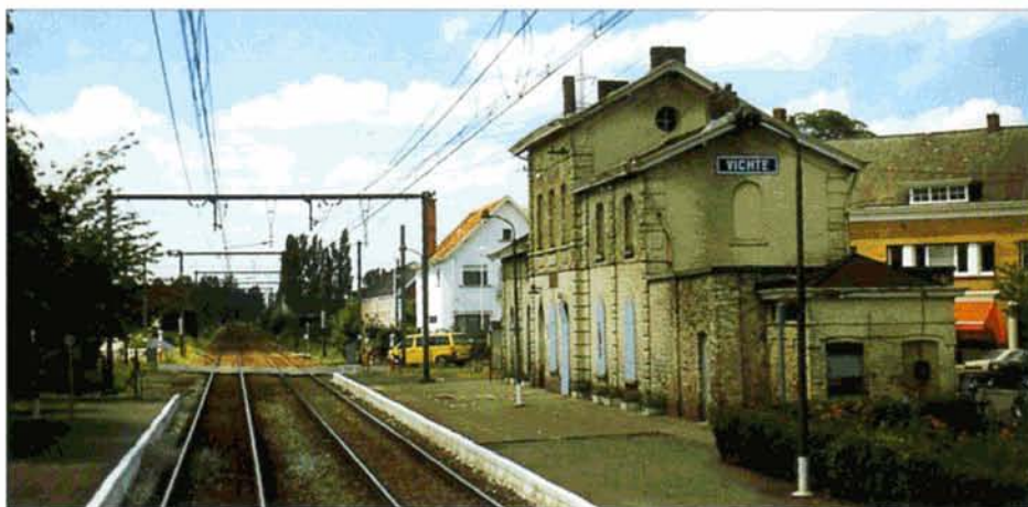
L'ancienne gare de Vichte située sur la ligne 89 entre Kortrijk et Oudenaarde a été démolie au début de l'année.
