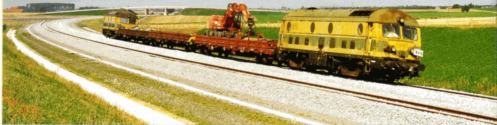
PHOTO 44-66 De Voroux à Ans, la voie est déjà posée. Le 4 septembre un train de travaux retourne vers la base de Voroux. P. HERBIET.
