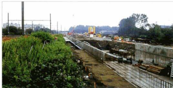
PHOTO 44-74 Vue du chantier au nord d'Antwerpen, à hauteur de Luchtbal. Plusieurs ouvrages permettront l'insertion des voies TGV dans celles de la ligne 12. Antwerpen-Luchtbal, 31 juillet 2000. Kristof AVONDS.
