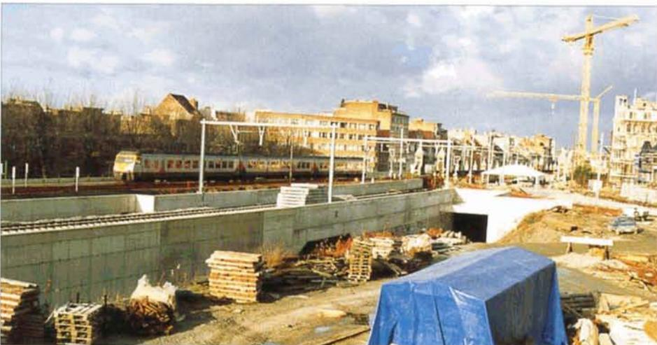
**PHOTO 45-70** Le triangle de Berchem, le 8 décembre 2000. On distingue les nouvelles voies de la ligne 59, la pose de la nouvelle bifurcation vers la ligne 12, l'entrée du tunnel qui permettra de rejoindre les étage inférieurs. Baudouin DIEU.
