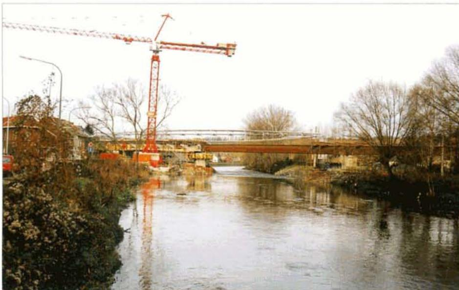
**PHOTO 45-68** La Vesdre sera traversée, à la sortie de Chênée, par un ouvrage mixte acier-béton, construit à l'emplacement de l'ancienne ligne 38. Chênée, 20 décembre 2000. B. DIEU.
