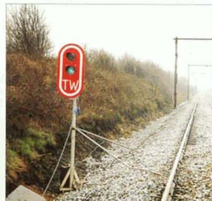
PHOTO 45-44 ↖ et PHOTO 45-45 ↗ Les nouveaux signaux TW sont utilisés pour la protection de travaux avec empiètement possible du gabarit de la voie parcourue, ici à Blanmont (signal TW jaune) et Chastre (signal TW rouge).
