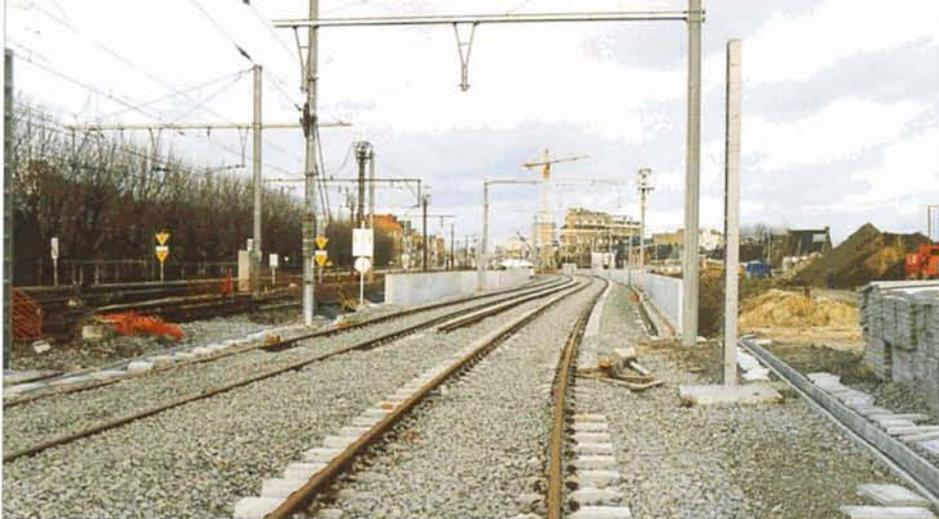
**PHOTO 45-69** Les nouvelles voies de la ligne 59. A gauche et à droite viendront les deux voies qui seront affectées à la desserte des voies inférieures. Berchem, 8-12-2000. B.D.
