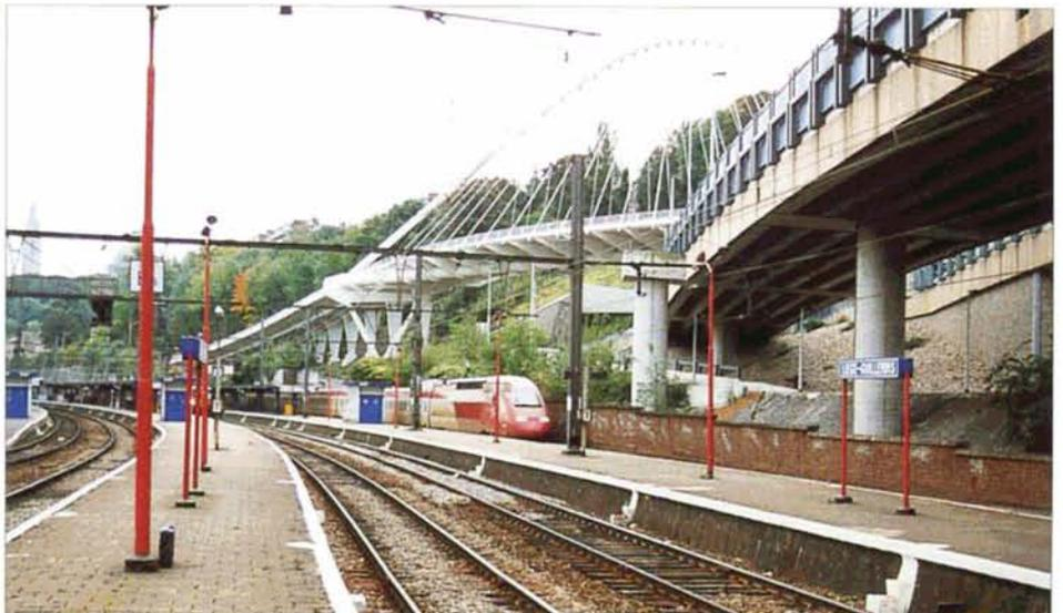
PHOTO 45-66 La gare des Guillemins côté Bruxelles. Le très bel ouvrage routier qui permettra d'atteindre la dépose-minute et les parkings est déjà construit. On aperçoit nettement les quais en courbe, qui disparaîtront au profit d'un alignement droit. Liège-Guillemins, 18 octobre 2000.
