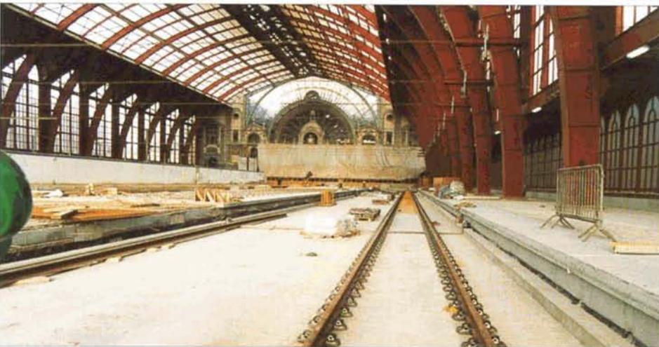
**PHOTO 45-71** L'intérieur de la gare Centrale d'Antwerpen. La future voie 6 est posée sur béton, desservie par un large quai. Celui des voies 4 et 5 est déjà construit. Ils permettront de recevoir deux rames TGV accouplées. Baudouin DIEU.
