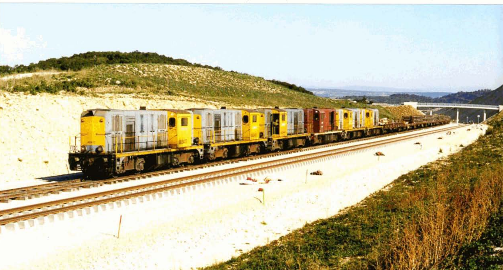
PHOTO 46-24 En raison des rampes très sévères atteignant des déclivités maximales de 3,5 %, la construction du TGV Méditerranée aura donné lieu à des couplages exceptionnels d'engins moteurs, comme ici un train transportant des coupons de voie provisoire mené par six hollandaises : les BB 62.477 + 62.405 + 62.449 + 62.501 + 62.430 + 62.439. Le convoi se trouve dans le triangle des Angles, sur la ligne Lyon - Nîmes. A l'avant plan, la voie normale Nîmes - Avignon est déjà définitive mais non encore ballastée. La seconde voie sur laquelle se trouve le train est provisoire (future voie Avignon - Nîmes). Pierre HERBIET, 9 mars 2000.
