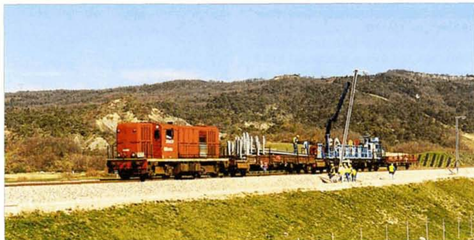
PHOTO 46-20 Le 8 mars 2000, à Roynac, la BB 62.450 (ex. 2450 des NS), encore habillée de sa livrée brun-rouge d'origine, opère en tête d'un train de mâtage de poteaux supports de caténaires. Pierre HERBIET.
