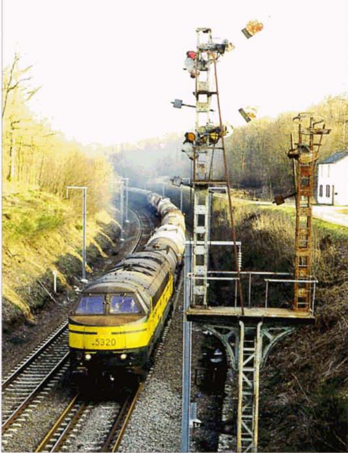
PHOTO 46-82 Le signal d'arrêt K37 de St.Vincent-Bellefontaine, vu de dos. La palette d'arrêt et la palette avertisseur levées à 45° indiquent que le signal suivant autorise le passage. La nuit, deux feux verts sont allumés. Pierre HERBIET, 2 avril 1999.
