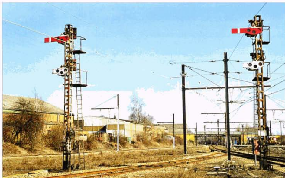
PHOTO 46-85 Le signal d'arrêt simplifié surélevé M IV de Châtelet. Lorsque le signal autorise le passage, la plaque rouge pivote de 90°, le feu rouge est alors remplacé par un feu jaune. Jean-Luc VANDERHAEGEN, 3 mars 2001.
