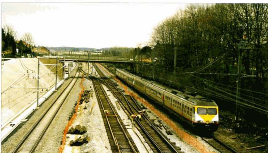
PHOTO 46-64 Venant de l'aéroport, le train IR E3734 pour Quévy arrive à Zaventem. A gauche, la nouvelle voie A; au centre, les travaux du futur gril qui permettra d'accéder à la ligne 36C au départ des lignes 36 et 36N. Baudouin DIEU, 3 avril 2001.
