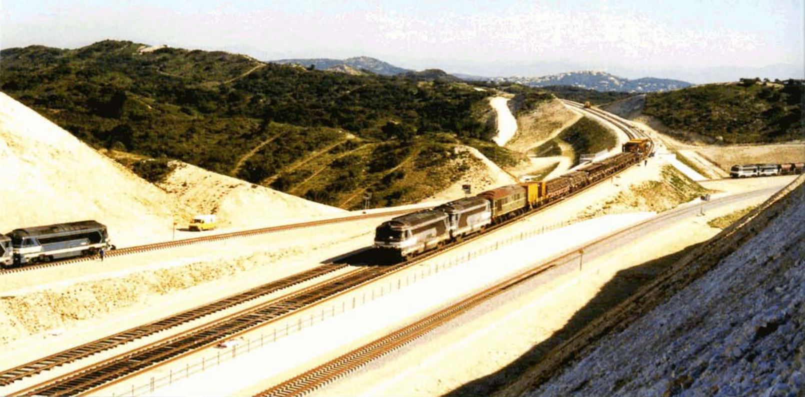
PHOTO 46-23 Le 9 mars 2000, trois trains de chantier s'entrecroisent dans le site du triangle des Angles. Au centre, sur la ligne Lyon - Nîmes, on voit un train de substitution de la voie provisoire, mené par les BB 67.027 + BB 67.035 + CC 65.516. A l'arrière du train, la voie provisoire est démontée et remplacée par la voie définitive (traverses en béton et longs rails soudés). A droite et à gauche, sur la liaison Nîmes - Marseille, deux trains de ballast remorqués par des A1A A1A 68.000/68.500 attendent leur déchargement. Pierre HERBIET.
