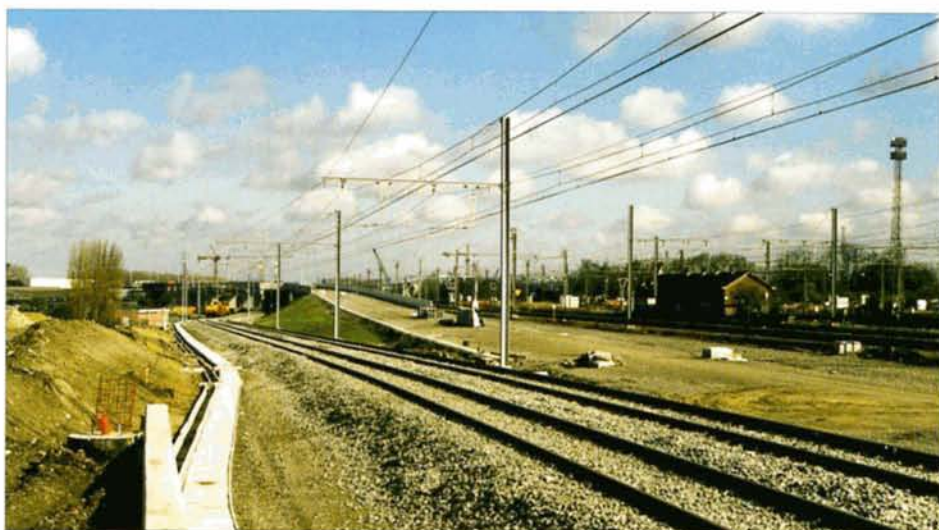
PHOTO 46-65 L'entrée de la gare de Leuven coté Bruxelles. A gauche, les voies de la ligne 36 qui accéderont aux voies à quai I et II et à la gare latérale. B. DIEU, 3 avril 2001.
