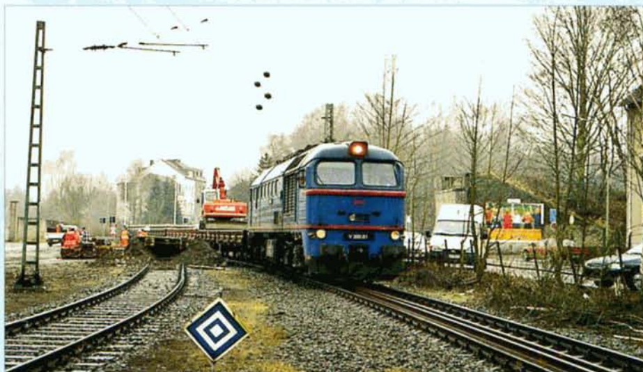
PHOTO 46-50 Déchargement de traverses en béton à la sortie de la gare de Stolberg. Le train est tracté par la V200.01 du PEG (ex. locomotive tchèque 781.436 des CD). Yves STEENEBRUGGEN.
