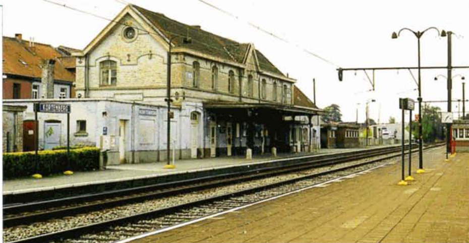
PHOTO 46-46 La gare de Kortenbergh a été démolie en mars dernier. Elle fut construite par l'Etat Belge en 1866, simultanément à la mise en service de la section Bruxelles-Nord - Leuven de la ligne 36, ouverte le 17 décembre 1866. J-L VANDERHAEGEN, 07-10-1999.
