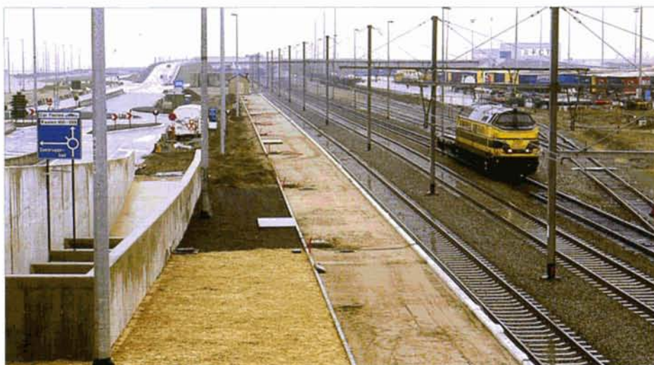
DIA 46-47 La nouvelle gare de Zeebrugge-Strand sera mise en service les week-ends et jours fériés à partir du 10 juin. Le 14 avril dernier, l'unique quai était en cours de finition. L'accès à la plage s'effectuera par un passage souterrain visible à gauche. Christian DOSOGNE.
