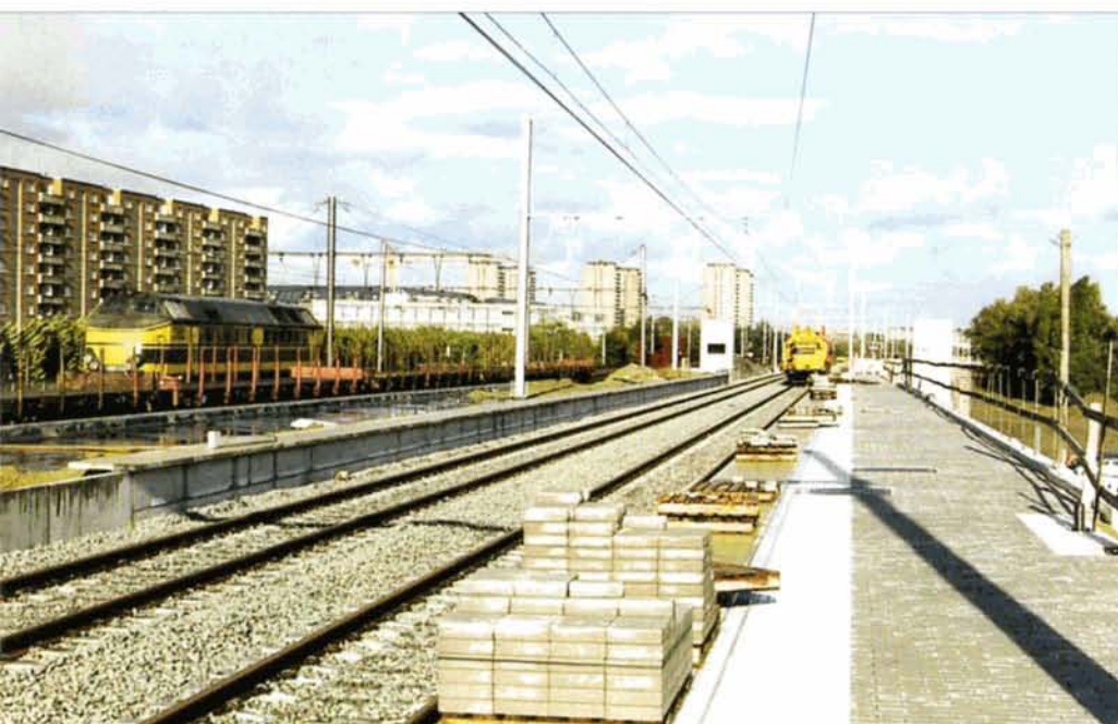
PHOTO 48-84 La nouvelle halte de Groenendaallaan remplacera Luchtbal et Dam. Les deux voies de la nouvelle ligne 27A sont déjà posées et les quais sont en cours de finition. Antwerpen, 9 novembre 2001. Ci-dessous: PHOTO 48-85 Le chantier de la L3 entre Luchtbal et Noorderdokken. A droite, les deux voies de la nouvelle ligne 27A vers Antwerpen-Noord; au centre la future voie B de la ligne 12 et à gauche, les emprises de la nouvelle ligne 4 qui passera sous les trois autres grâce au tunnel visible à l'arrière-plan. 9 novembre 2001. B. DIEU.
