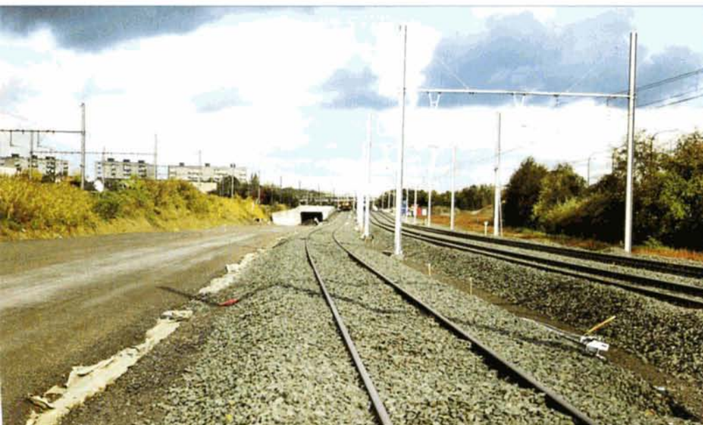
PHOTO 48-84 La nouvelle halte de Groenendaallaan remplacera Luchtbal et Dam. Les deux voies de la nouvelle ligne 27A sont déjà posées et les quais sont en cours de finition. Antwerpen, 9 novembre 2001. Ci-dessous: PHOTO 48-85 Le chantier de la L3 entre Luchtbal et Noorderdokken. A droite, les deux voies de la nouvelle ligne 27A vers Antwerpen-Noord; au centre la future voie B de la ligne 12 et à gauche, les emprises de la nouvelle ligne 4 qui passera sous les trois autres grâce au tunnel visible à l'arrière-plan. 9 novembre 2001. B. DIEU.
