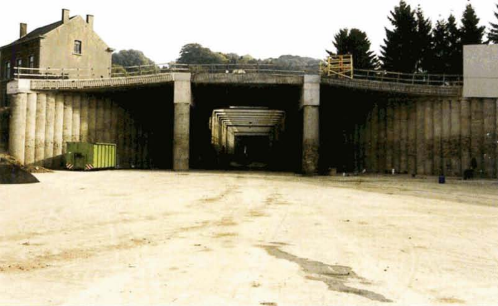
PHOTO 48-83 Vue prise vers le fond de la tranchée couverte précédant le tunnel de Soumagne. C'est ici que le forage du tunnel sera opéré. Vaux-sous-Chèvremont, 17 octobre 2001.
