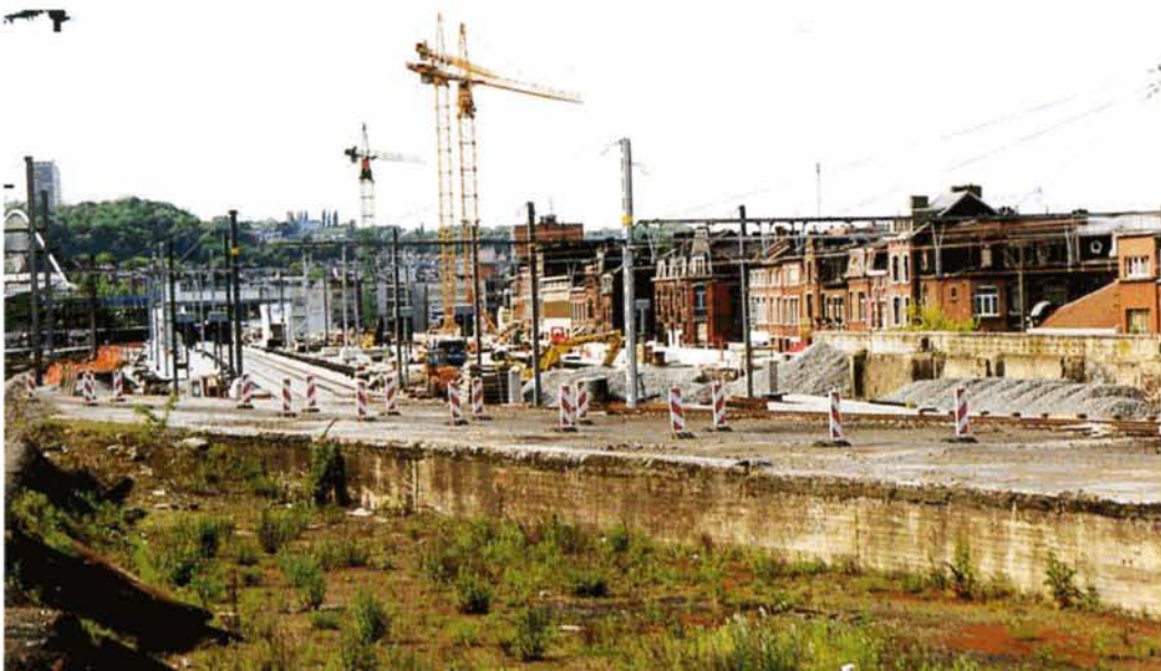
PHOTO 51-84 La gare des Guillemins en construction le 21 mai 2002. Au fond, les voies 3 et 4 sont posées et leur électrification entamée. Baudouin DIEU.
