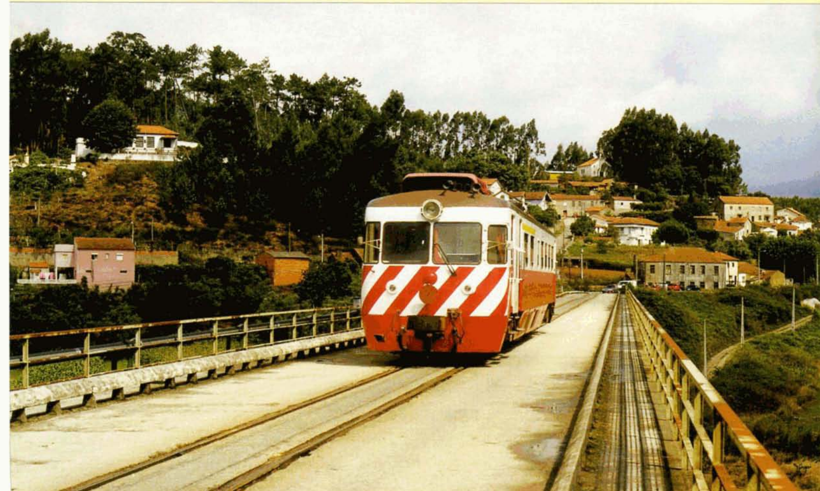
PHOTO 54-19 A la sortie de Sernada do Vouga en direction de Aveiro, la ligne franchit la Vouga par un pont mixte rail-route. Le 13 septembre 1998, l'autorail Allan 9305 traverse la Vouga. La circulation routière est arrêtée de part et d'autre de l'ouvrage. Philippe DE GIETER.
