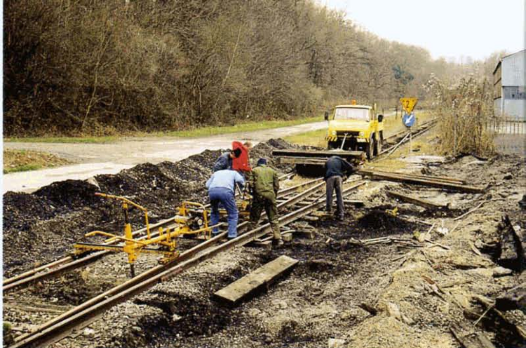
Le 12 janvier 2003, l'équipe de bénévoles du PFT s'active à remplacer des traverses d'un aiguillage situé à l'entrée de la gare de Spontin, qui imposait un ralentissement à 10 km/h.
