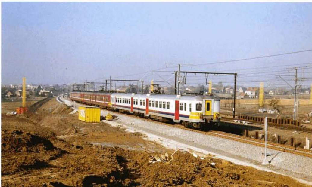
Le train omnibus E3032 Leuven-Geraardsbergen circule sur la nouvelle voie B entre Nossegem et Zaventem. L'enlèvement des voies médianes a commencé. Baudouin DIEU, 13 février 2003.
