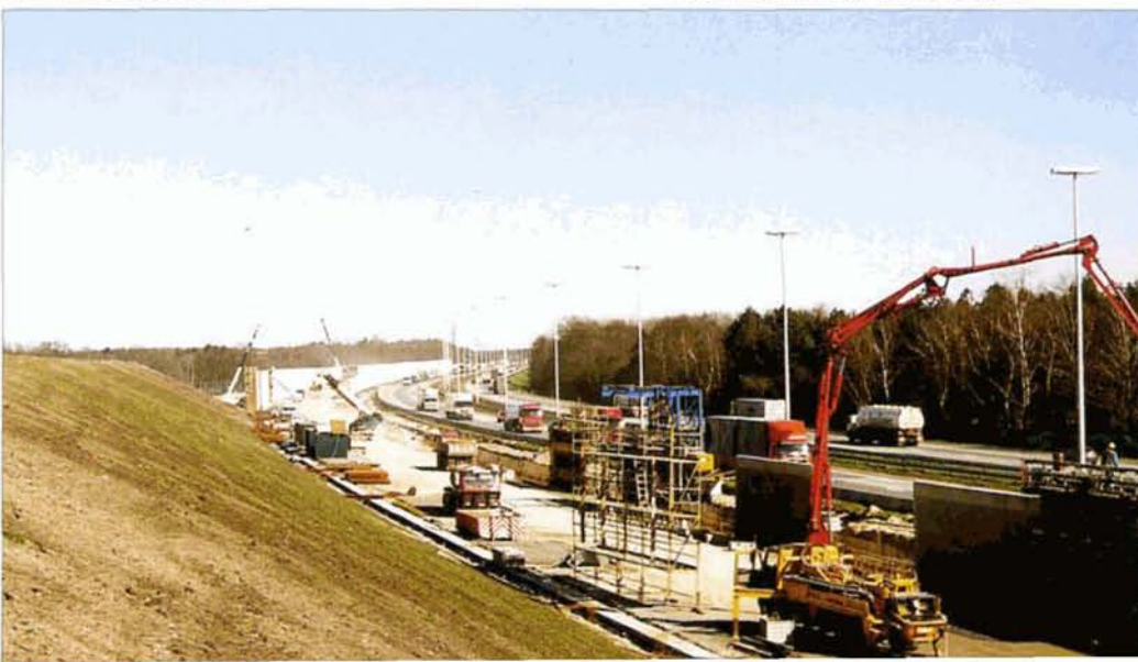
Le chantier de construction de la plate-forme de la LGV 3 vers les Pays-Bas, à hauteur de Brasschaat. La proximité des habitations nécessite la construction de nombreux murs, qui les protégeront également du bruit, certainement plus conséquent, du trafic autoroutier. Baudouin DIEU, 14 mars 2003.
