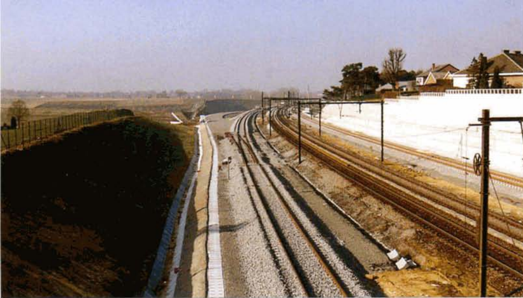
Prise de Nossegem vers Zaventem, cette vue montre l'avancement des travaux. Les nouvelles voies de la ligne 36 sont posées mais non électrifiées, tandis que les anciennes voies, au centre, sont toujours en service. Dans la voie vers Bruxelles, l'aiguillage qui donnera accès à l'aéroport venant de Leuven. Nossegem, 13 février 2003. Baudouin DIEU.
