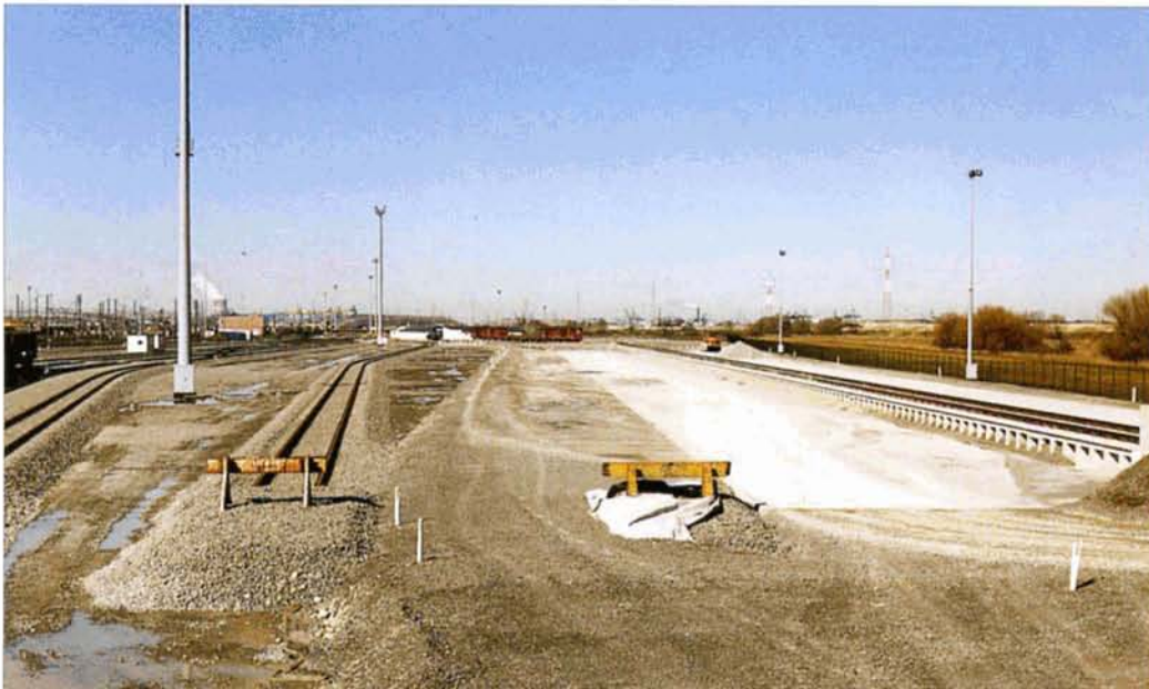
La base de travaux d'Anwterpen-Noord est construite; elle ne sera pleinement opérationnelle qu'en août 2004. A droite, l'estacade de déchargement des wagons-trémies. Baudouin DIEU, 14 mars 2003.
