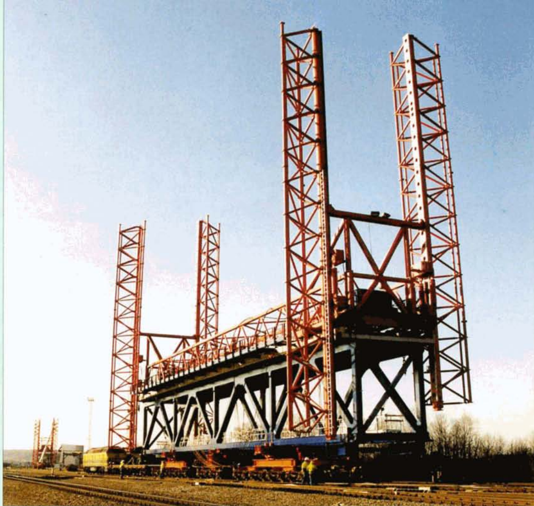
Parcours d'essais de la traverse 2 à hauteur du block 16 de Montzen. Ce convoi exceptionnel a un poids total avoisinant 1200 t (700 t pour le tablier et 500 t pour le portique de levage). Alain KÖTTGEN.
