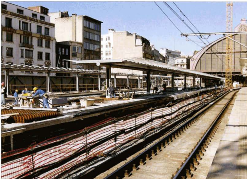
Les quais des futures voies 1 à 3 de la gare d'Antwerpen-Centraal sont en construction. Ils se prolongent à l'extérieur de la verrière, pour permettre la réception de trains de 400 mètres. Baudouin DIEU, 14 mars 2003.
