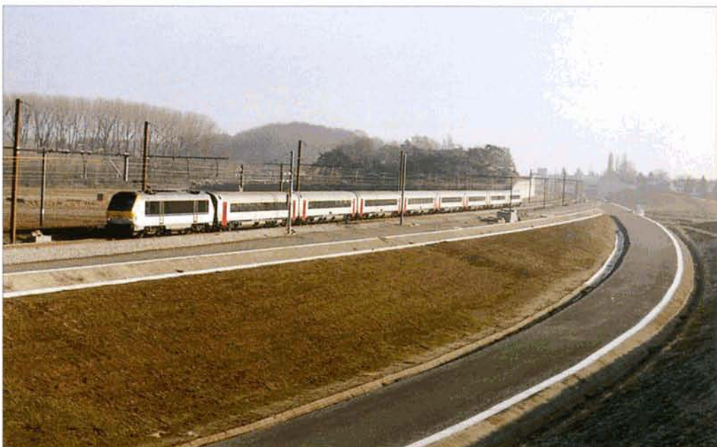
Venant de Eupen, le train IC E532 pour Oostende arrive à Zaventem. A droite, l'assiette de la future voie B qui permettra aux trains venant de Leuven de rejoindre directement l'aéroport. Le train passe de l'ancienne voie B à la nouvelle.
