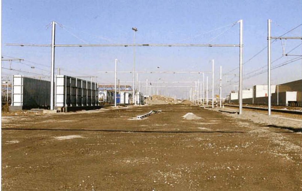
Entre Forest et Bruxelles-Midi, le faisceau T a reçu ses poteaux caténaires. A gauche, le futur car-wash; à droite la voie B de la ligne 96. Forest, 17 février 2003. Baudouin DIEU.
