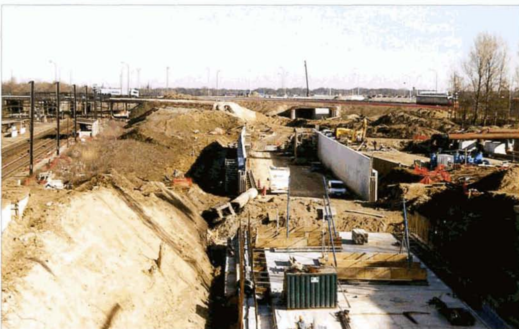
Antwerpen-Noorderdokken. La future ligne vers les Pays-Bas franchit l'échangeur autoroutier E19/A12 par une série d'ouvrages en béton. A gauche, la halte de Noorderdokken. Baudouin DIEU, 14 mars 2003.
