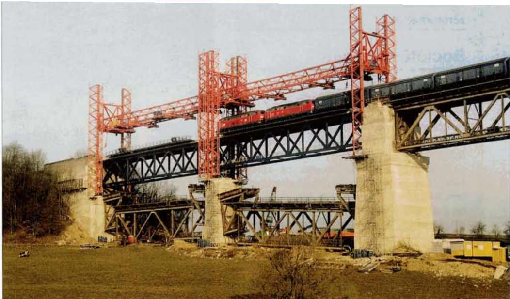
Le 18 avril 2003, un train complet à destination de l'usine Ford de Genk traverse le viaduc de Moresnet, dont les deux premières travées ont été remplacées les trois jours précédents. Les deux portiques ayant servi au transport des tabliers et au démontage des anciens, sont toujours en place. Roger CRIKELAIRE.
