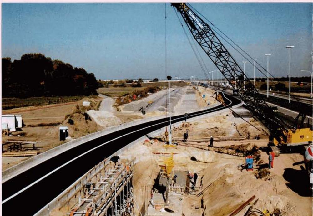
**Brecht, 8 octobre 2003. Une gare réservée au trafic intérieur est en construction le long de l'autoroute E19. Un passage sous voies, en construction, desservira les différents quais.** Baudouin DIEU.
