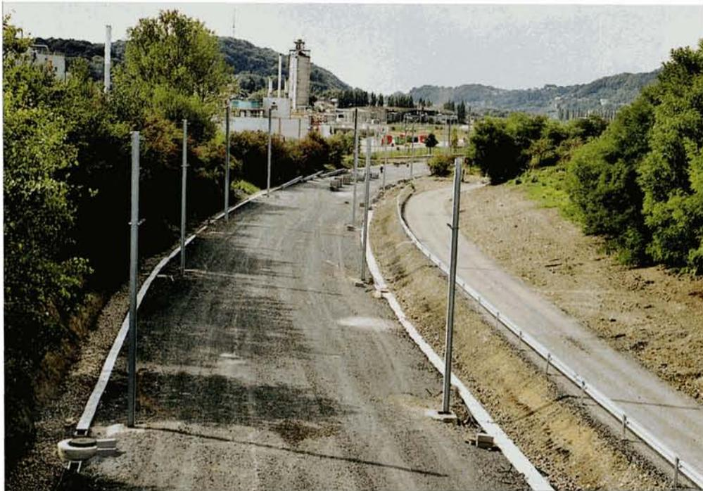
**La reconstruction de la ligne Athus - Mont-Saint-Martin progresse lentement. Côté France, l'assiette est pratiquement terminée et les poteaux supports de caténaires sont déjà implantés. Ces travaux ont nécessité un léger déplacement de la ligne vers Rodange, à la sortie de Mont-Saint-Martin. Côté belge, les travaux progressent plus lentement. Mise en service prévue dans le courant du printemps.** Pierre HERBIET, 4 septembre 2003.
