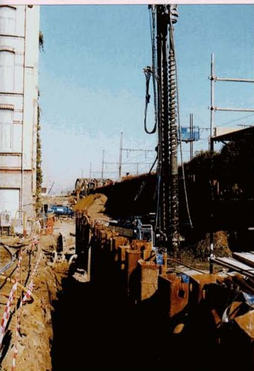
*Entre la Damplein et Noorderdokken, la ligne nouvelle est accolée aux deux voies existantes des lignes 12 et 27A. Pour éviter des expropriations trop importantes, un mur de soutènement est construit entre la Damplein et le canal Albert. Antwerpen, 8 octobre 2003. Baudouin DIEU.*
