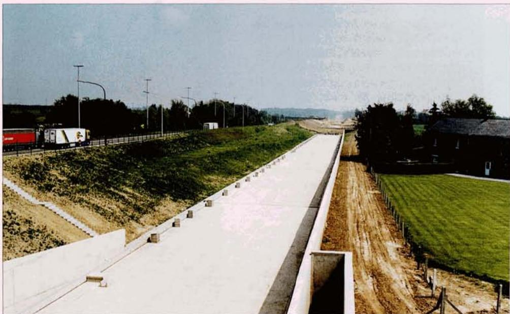
*La configuration des terrains, la nature des lieux et les desiderata des riverains ont entraîné la construction d'ouvrages supplémentaires, comme la tranchée couverte d'Elsaute, entre Battice et Welkenraedt. On voit ici la sortie de l'ouvrage côté Allemagne, et une vue générale des chantiers, dans le fond. Elsaute, 17 mai 2004.*
