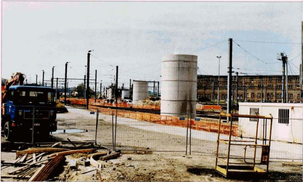
↑ Les piles du viaduc de Schaerbeek doivent s'insérer dans les voies des faisceaux de garage. Dans le fond, la culée et le bâtiment administratif. Le viaduc, dont le tablier sera par endroit à une hauteur de vingt mètres, doit franchir la future voie A de la ligne 36 pour s'y insérer. Schaerbeek, 25 avril 2004. Baudouin DIEU.
