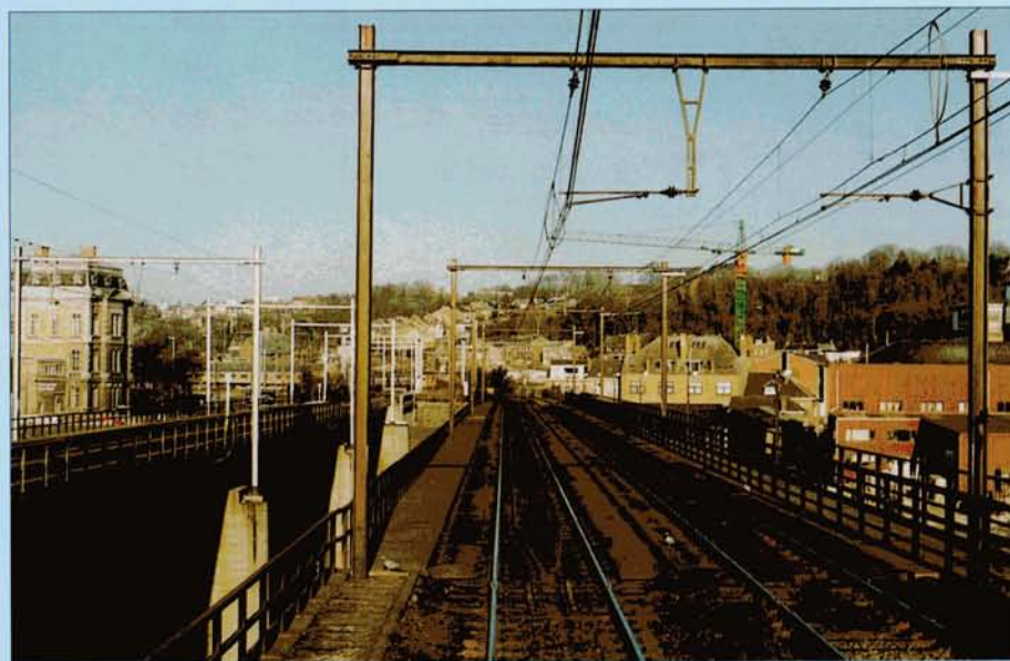
Les deux voies de la ligne 162 franchissant le pont au-dessus de la Meuse à Namur sont pourvues de deux files de rails pour limiter les conséquences d'un éventuel déraillement.
