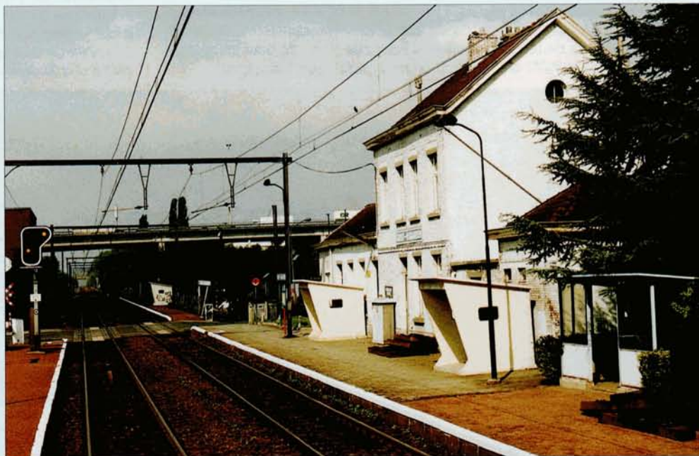
Située sur la ligne 50 Bruxelles-Nord - Jette - Denderleeuw, le bâtiment de la gare de Groot-Bijgaarden a été démoli dans le courant du mois d'avril. Seul subsiste un petit local annexe. La gare de Groot-Bijgaarden avant démolition, le 20 mai 1996.
