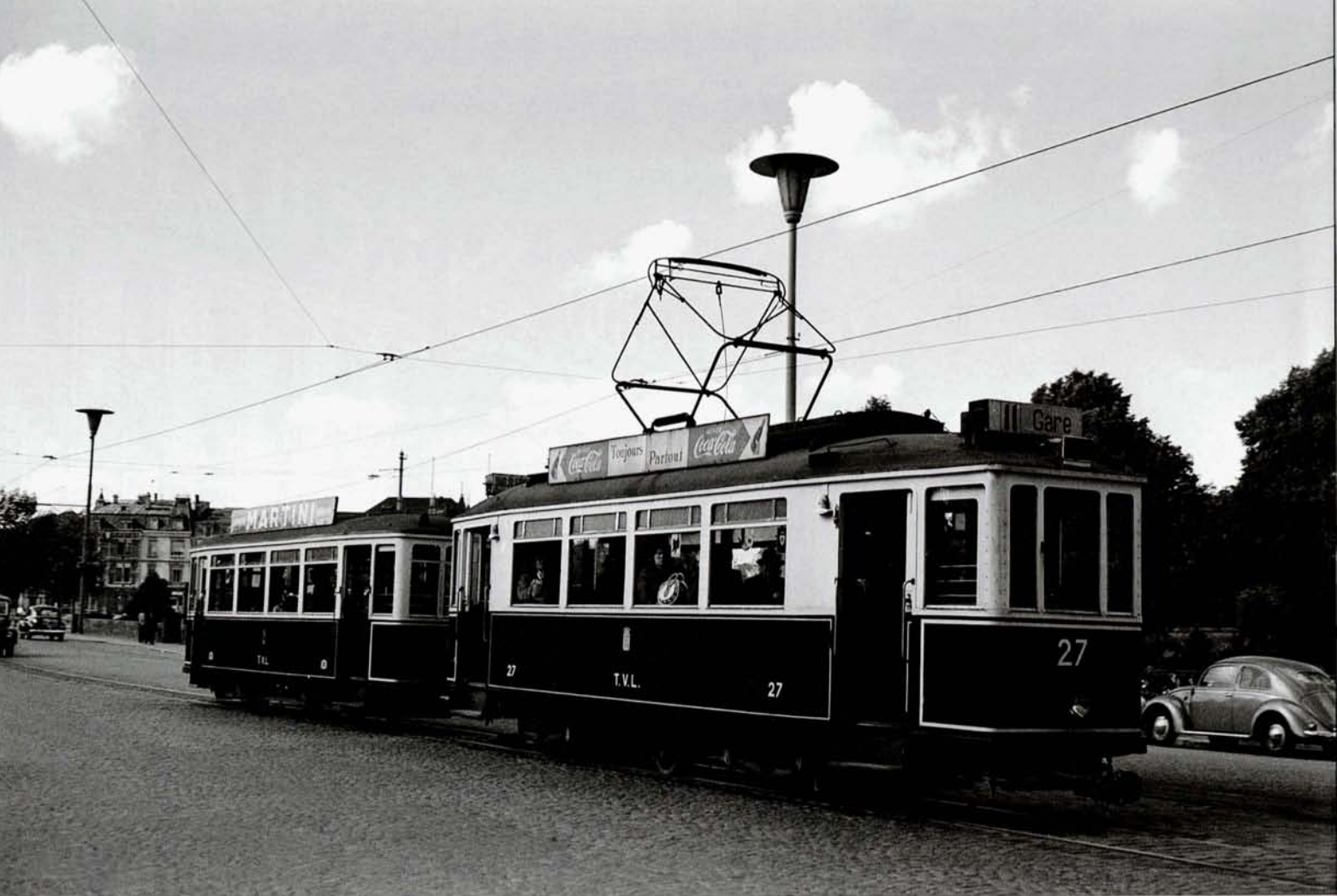
PHOTO BD-197 En juin 1956, la motrice n°27 avec la remorque 101 passent sur le pont Adolphe en direction de la gare. Cet ouvrage franchit le fameux ravin de la Pétrusse qui sépare la vieille ville de la nouvelle. Bruno DEDONCKER, collection PFT.
