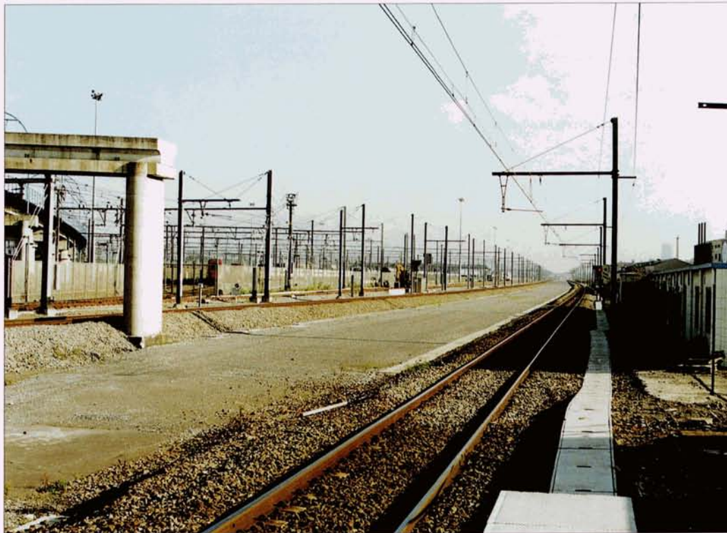
La ligne 96 à Forest-Midi en direction de Bruxelles. A gauche, le faisceau M, coincé entre l'atelier TGV et la ligne 96. Son électrification est en cours. Forest, 22 août 2004. Baudouin DIEU.
