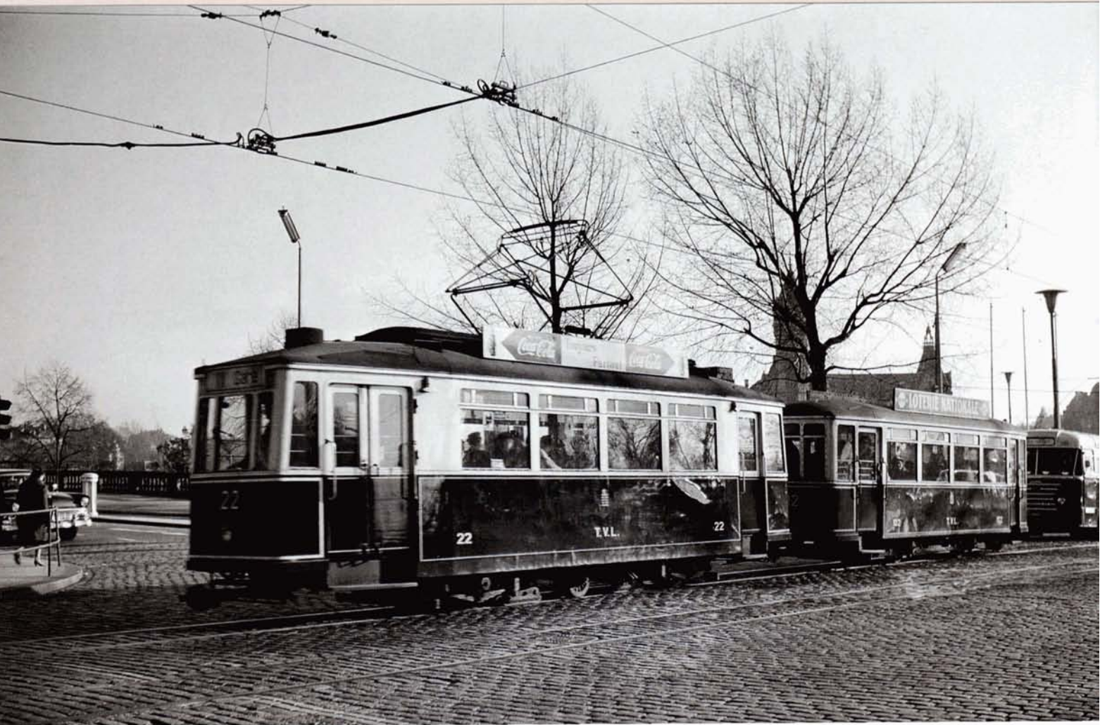
PHOTO BD-194 Le même jour au même endroit, la motrice n° 22 accouplée à la remorque 102, se dirige également vers la gare. Ce type de motrices comportait à trois essieux. Bruno DEDONCKER, collection PFT.
