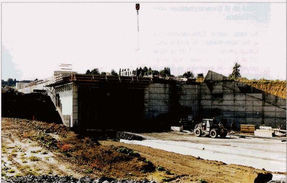
*La sortie du tunnel de Soumagne côté Allemagne : le tunnel proprement dit est prolongé par une tranchée couverte de 300 mètres que l'on voit déboucher à l'air libre. Soumagne, 1er octobre 2004. Baudouin DIEU.*
