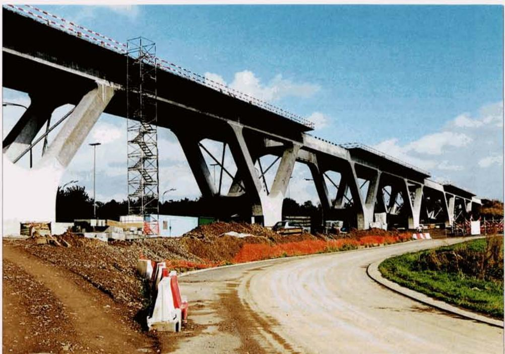
*Le viaduc de Battice est constitué d'éléments préfabriqués en forme de V, reliés entre eux par des poutrelles en béton précontraint. Au-dessus se placent les éléments qui constituent le radier, sur lesquels est coulé un béton. Battice, 1er octobre 2004. Baudouin DIEU.*
