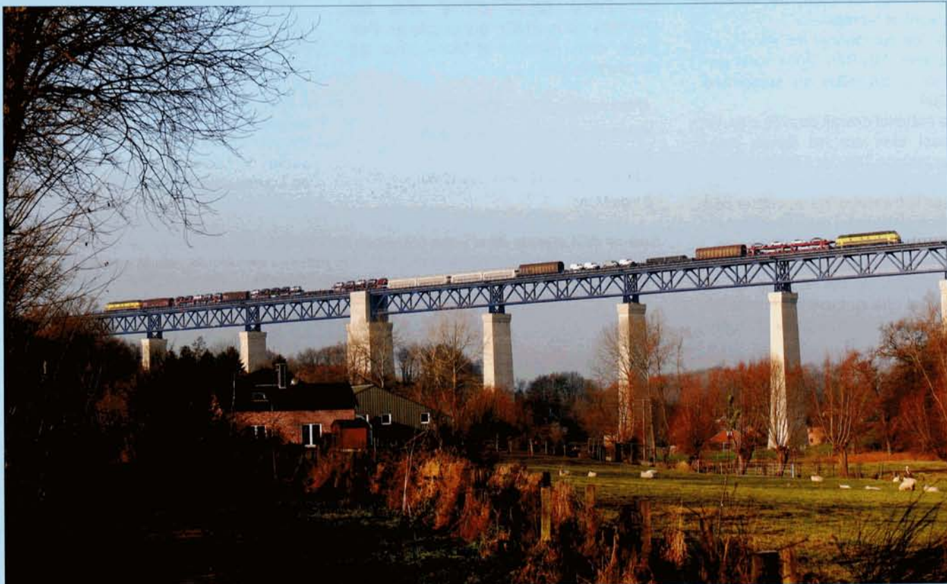
Le parcours d'essai à 70 km/h sur le viaduc de Moresnet le 12 décembre 2004.
