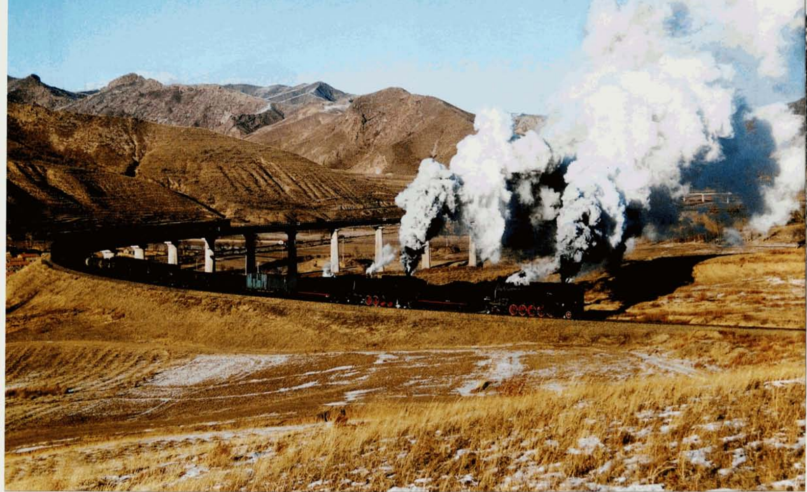
PHOTO 66-48 Nous terminons notre tour d'horizon ferroviaire de Chine avec la visite du site le plus remarquable fréquenté par des locomotives à vapeur : le col de JinPeng. Le 26 décembre 2003, les QJ 7009 et QJ 6828 viennent de franchir l'impressionnant viaduc en courbe de Simingyi.
