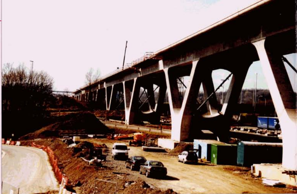
Le viaduc de Battice, avec ses 1300 mètres, est le plus important ouvrage aérien de la ligne nouvelle 3. La couverture et la pose des éléments préfabriqués a commencé. Battice, 20 mars 2005. Baudouin DIEU.
