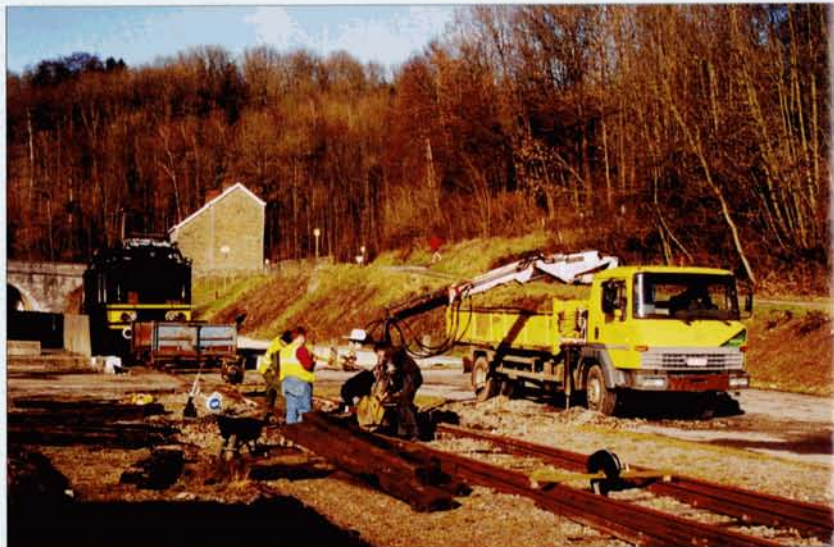
En décembre, des traverses furent remplacées à hauteur de l'ancien aiguillage de Spontin. Les opérations sont grandement facilitées grâce à l'autorail ES 102 et à l'acquisition d'un camion et d'une grue rail-route.
