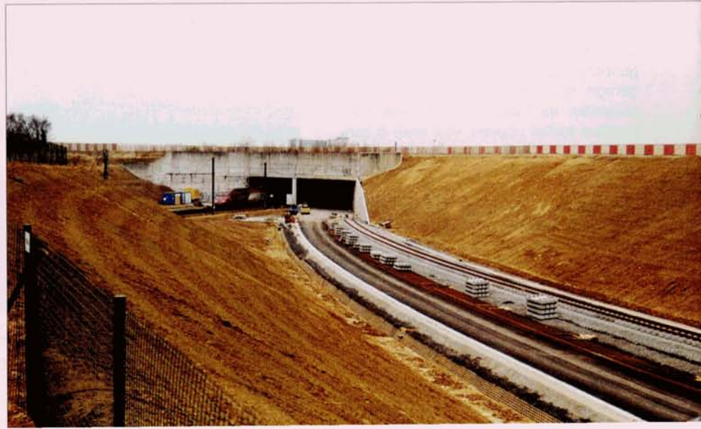
Les voies de la courbe de raccord de la ligne 36C/1, entre Nossegem et l'aéroport, sont en cours de pose. Dans le fond, la rame vide du TGV 9307 débouche du tunnel vers Zaventem. Nossegem, 20 mars 2005. Baudouin DIEU.
