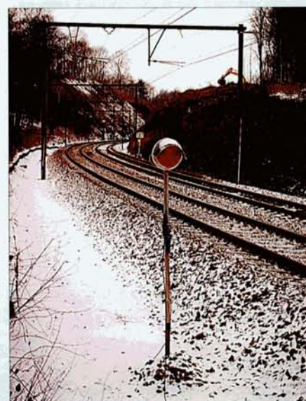
Une signalisation spéciale a été installée le long du chantier de Rhisnes afin de prévenir les chutes de rochers. Une série de lampes rouges ont été placées le long de la voie et entre les rails. Lorsqu'elles s'allument, les trains doivent immédiatement procéder à un freinage d'urgence.
