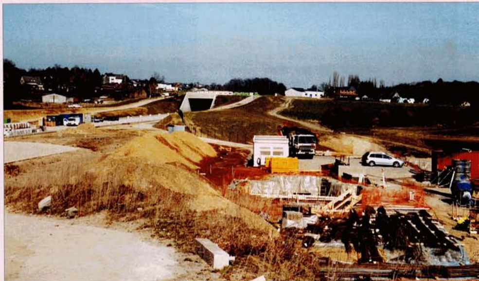
C'est ici à Ayeneux, à la sortie du tunnel de Soumagne, que sera construite la petite base qui alimentera en trains de travaux la ligne nouvelle vers l'Allemagne. A l'avant-plan, les travaux de construction de la future sous-station. Photos : Baudouin DIEU, 20 mars 2005.
