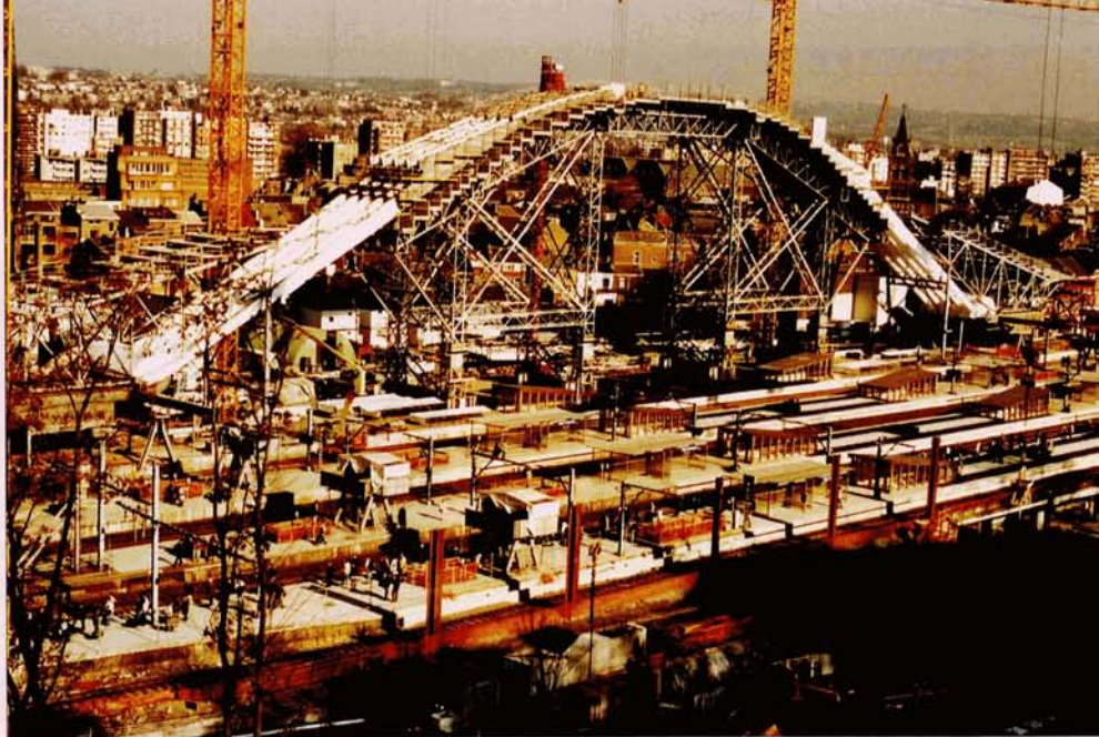
Prise de la colline de Coïnte, cette vue plongeante montre la nouvelle gare des Guillemins ; la construction de la charpente métallique s'effectue par des échafaudages placés sur le quai 1. Liège, 20 mars 2005. Baudouin DIEU.
