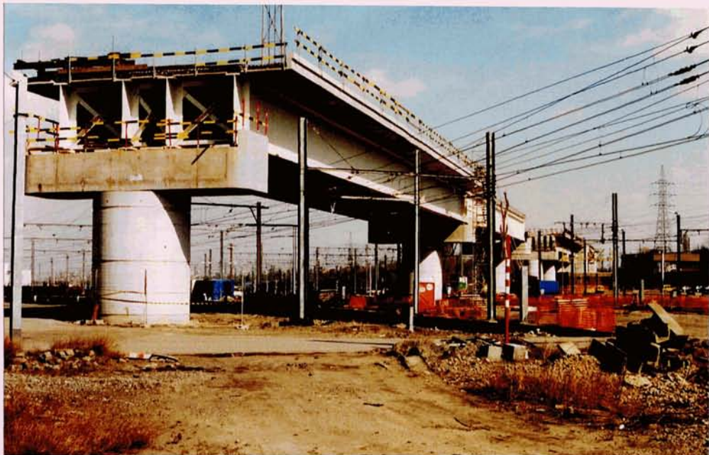
Le viaduc qui surplombe les voies des faisceaux de garage est composé de travées de béton ou métalliques. Presque toutes sont posées. Schaerbeek, 24 mars 2005. Baudouin DIEU.
