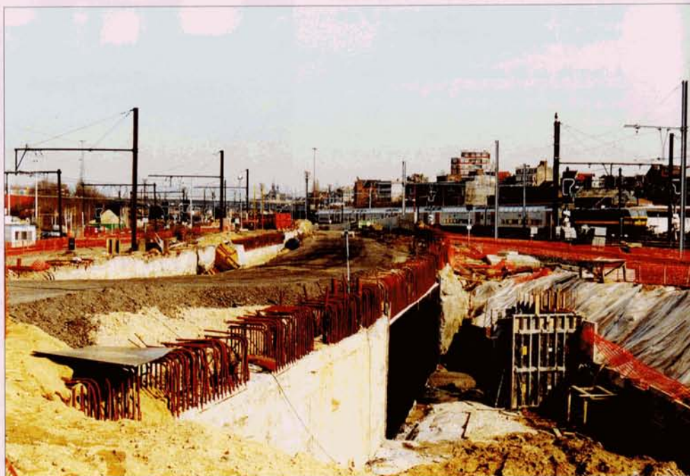
Dans le "quadrilatère" de Bruxelles-Nord, les travaux au passage inférieur qui reliera les voies voyageurs de la gare de Schaerbeek à la ligne 50 sont avancés. 16 mars 2005.
