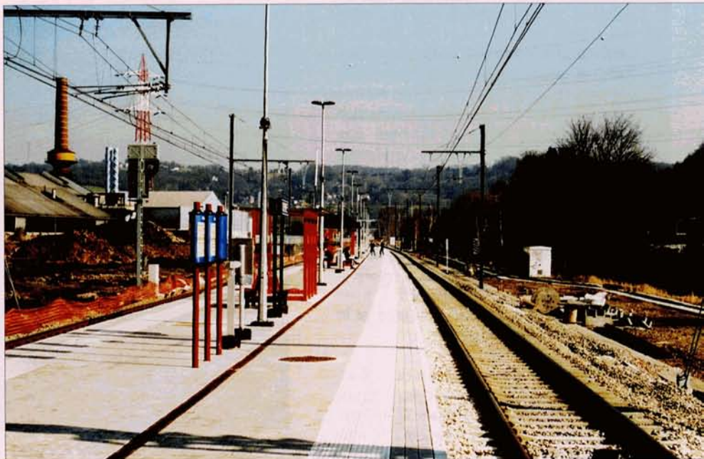
En gare de Chênée, les terrassements liés à l'établissement de la future bifurcation sont en cours. Le nouveau quai est opérationnel ; sa construction a nécessité la fermeture du point d'arrêt pendant quelques mois, de juin à octobre 2004. A gauche, sur l'emplacement de l'ancienne gare, passeront les deux voies de la ligne nouvelle.
