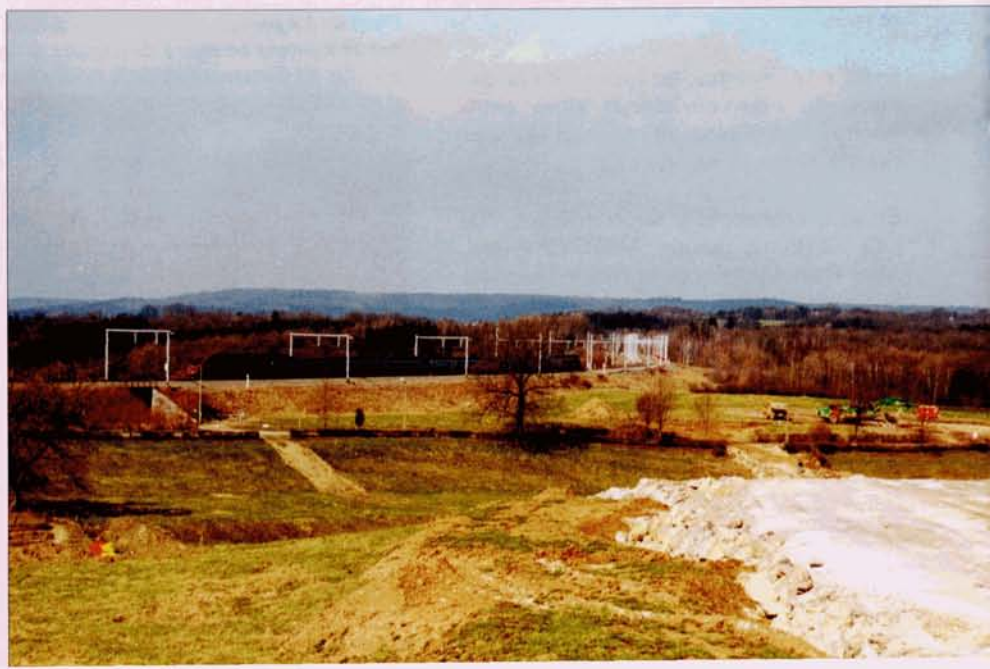
C'est ici que se raccordera la ligne nouvelle à la ligne 37, juste avant le Hammerbrücke, au fond de la photo. En 2007, le TGV 9436 Köln - Paris ne bifurquera plus vers Welkenraedt... Astenet, 20 mars 2005. Photos : Baudouin DIEU.
