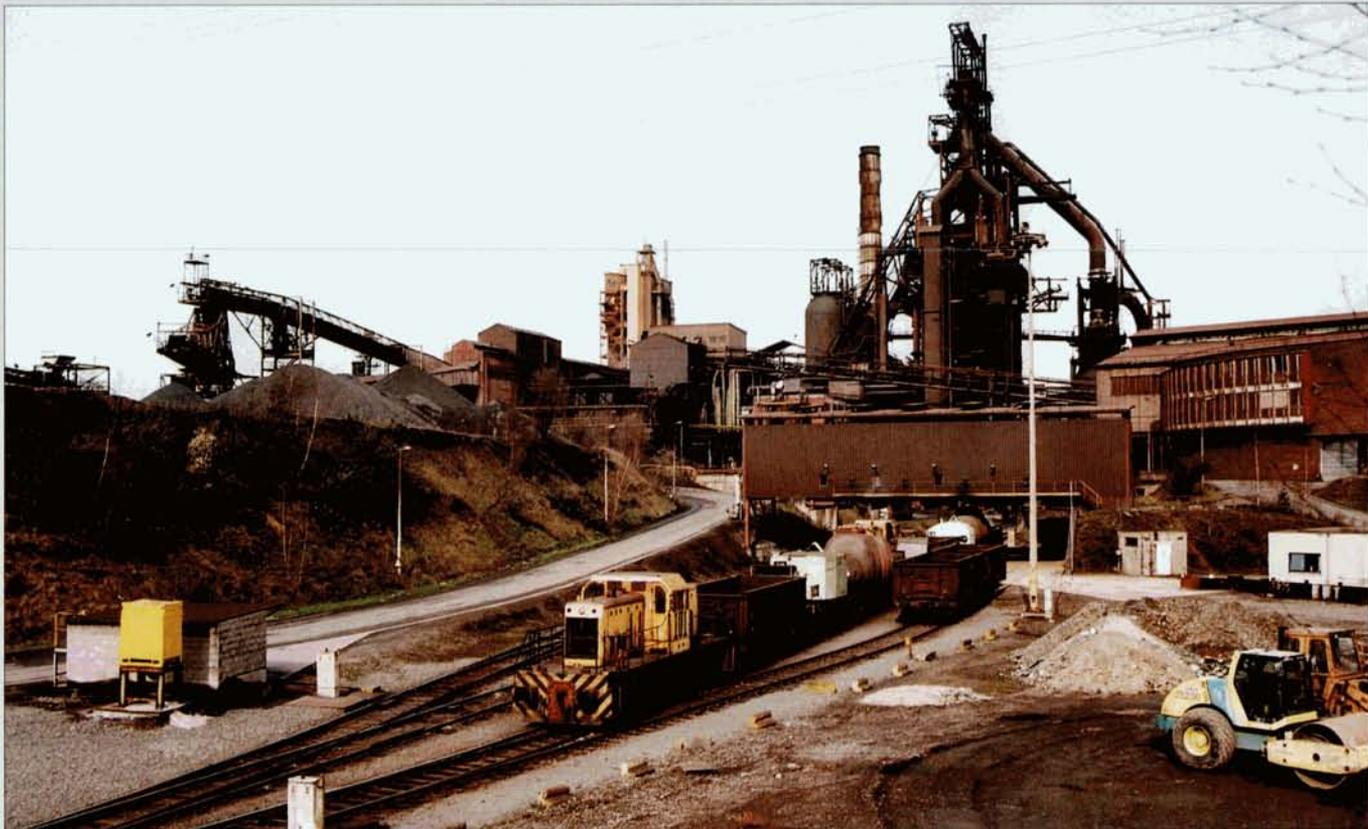
**PHOTO 68-50** Une vue générale du haut fourneau n° 6 de Seraing, prise le 16 mars 2002. A l'avant plan, la locomotive General Electric n° 101 manoeuvre un wagon-torpille sous le stand de fermeture des poches. Jean-Luc VANDERHAEGEN.
