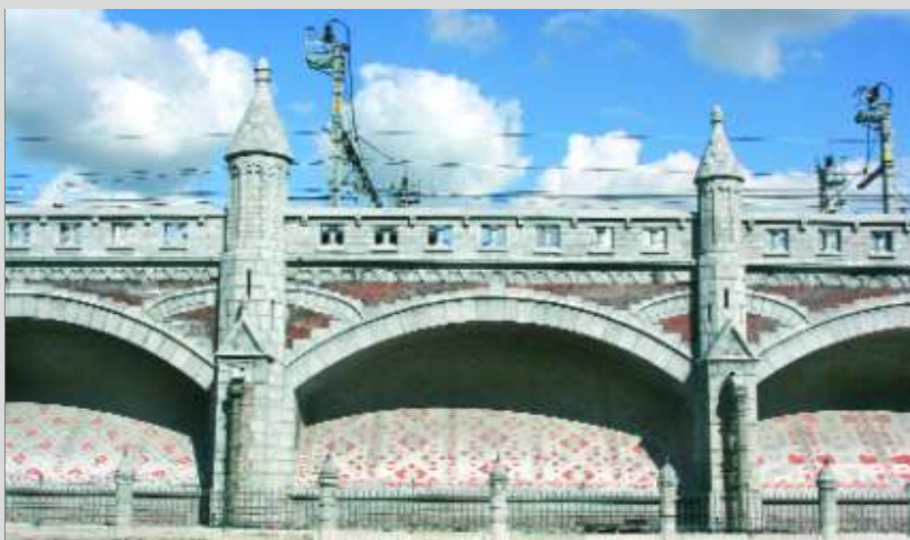
Une vue sur les arcades et les divers dessins en mosaïque situés sur les talus de l'ouvrage. Le talus est séparé de la rue par une clôture constituée de potelets en pierre de taille supportant une grille en fer forgé. Walter PINET.
