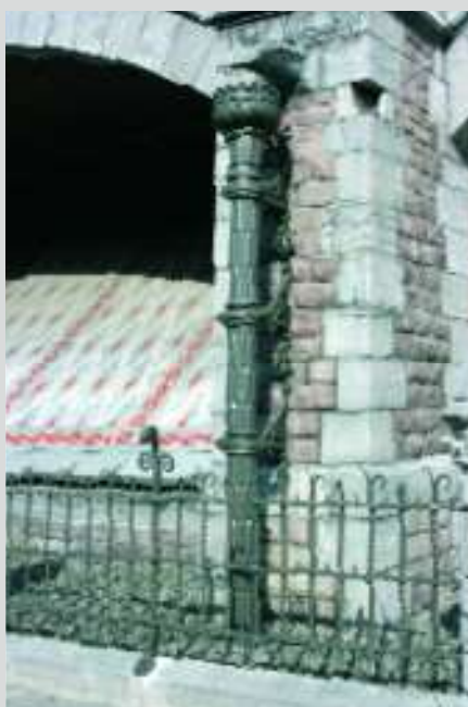
Détails d'une colonne sous gargouille, recueillant l'eau de ruissellement.
