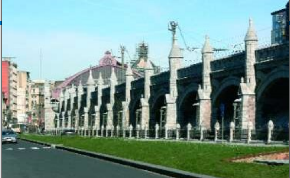
PHOTO 85-48 Les "Centers". Les tourelles d'inspiration romane s'appuient sur des contreforts au niveau de la rue. La Simonsstraat se présente à nouveau sous sa splendeur d'il y a 100 ans. Beaucoup de voyageurs ignorent l'existence des "Centers", invisibles depuis le train, à l'exclusion du sommet des tourelles. Walter
