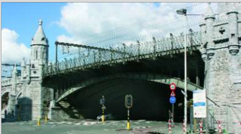
L'ouvrage comporte 5 ponts. Le plus grand enjambe l'avenue Belgiëlei, construit avec des éléments métalliques comme la coupole de la gare et encadré par deux grosses tours. Les autres ponts sont voûtés, en pierres. Walter PINET.
