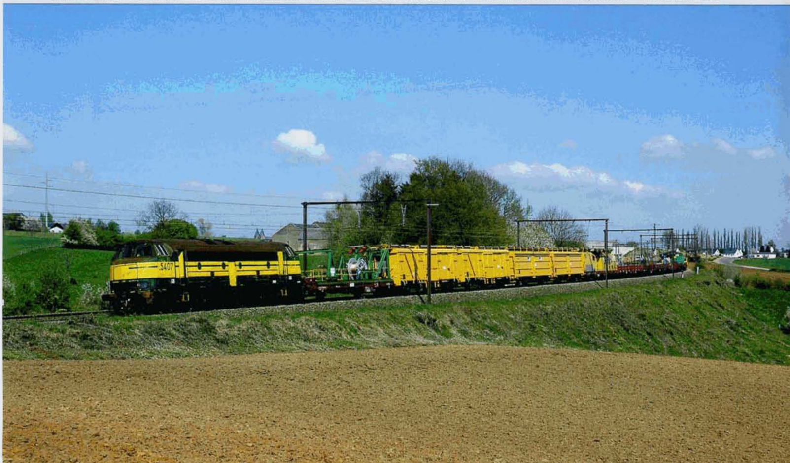
PHOTO 92-20 Les trains de réélectrification de la section Autelbas - Sterpenich sont toujours tractés par des 52, 53 et 54. Le 20 avril 2009, la 5407 transfère le train de travaux vers le chantier, photographié entre Autelbas et Sterpenich. Pierre HERBIET.
