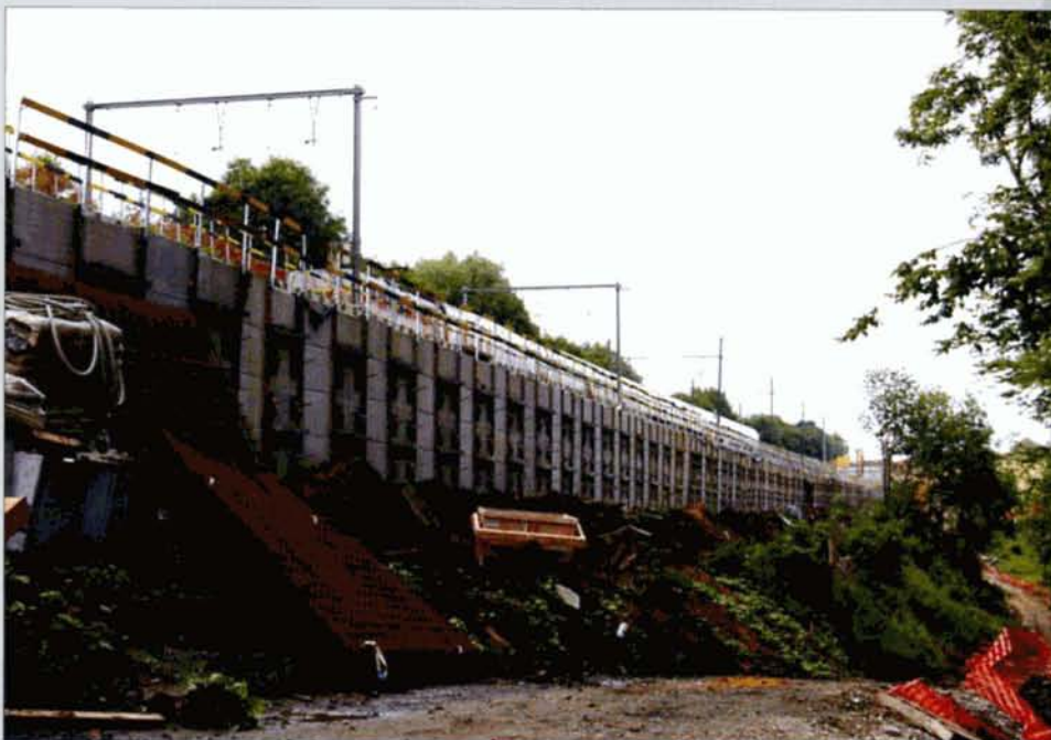
↑ Une vue prise à Braine-l'Alleud en direction de Bruxelles depuis la rue Jean Volders. On voit la structure qui est construite contre le talus existant de la ligne. Sur cette structure seront fixés les caissons du viaduc qui supportera la nouvelle voie.
