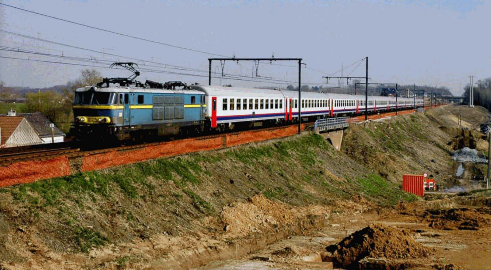
PHOTO 92-14 Le P8002 passe à Dilbeek, où les travaux de mise à quatre voies de la ligne 50A ont débuté.
