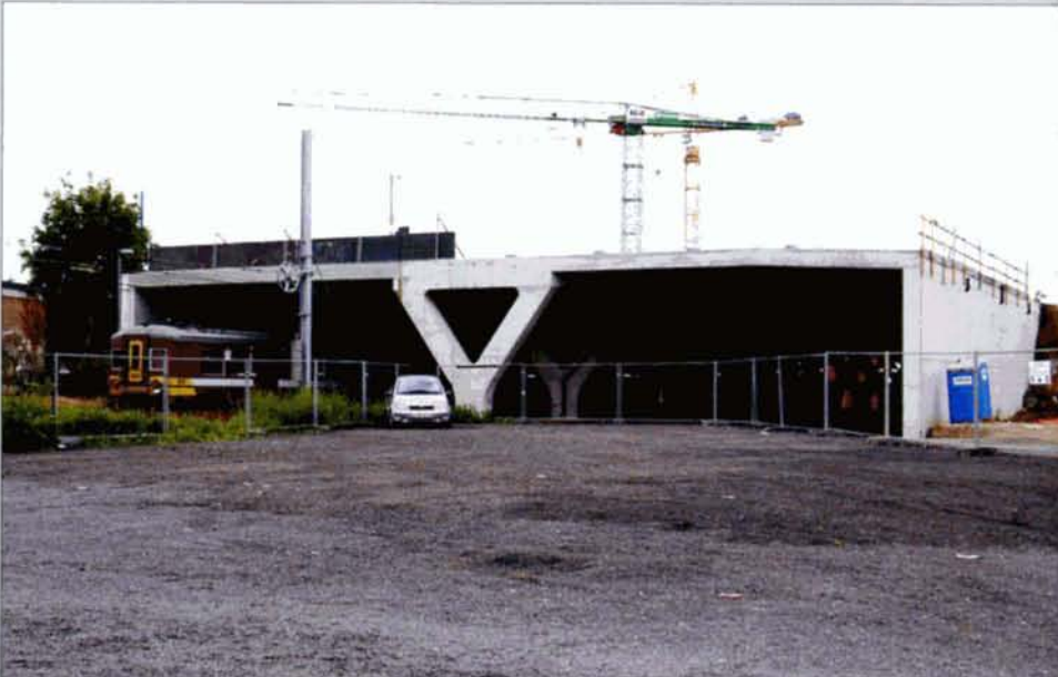
↓ En gare de Braine-l'Alleud, le «Pont Courbe» est complètement reconstruit. Afin de ne pas perturber le trafic routier, les travaux s'effectuent en plusieurs phases successives. Geert PACKET, 15 juin 2009.
