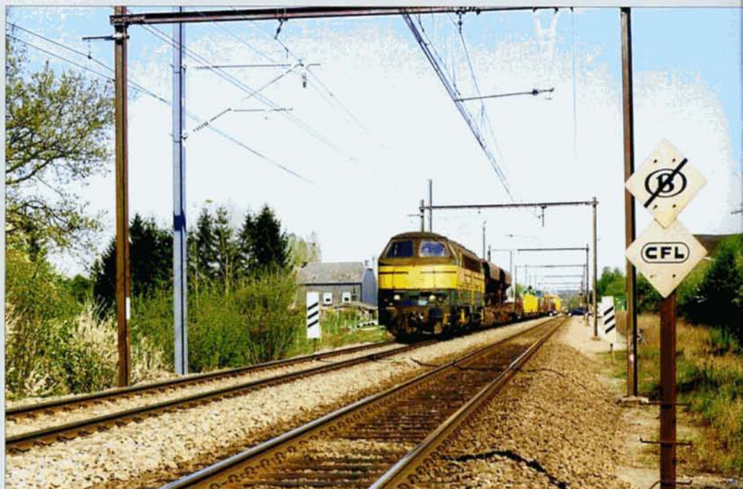
Toujours le 20 avril 2009, le train de réélectrification opère à cheval sur le point frontière entre les deux réseaux, sur la voie vers Luxembourg. Les caténaires sont en phase de placement sur leurs nouveaux supports. Sur la voie de droite (sens Luxembourg - Arlon), les anciens poteaux et caténaires sont toujours utilisés. Simon DERIDDER.
