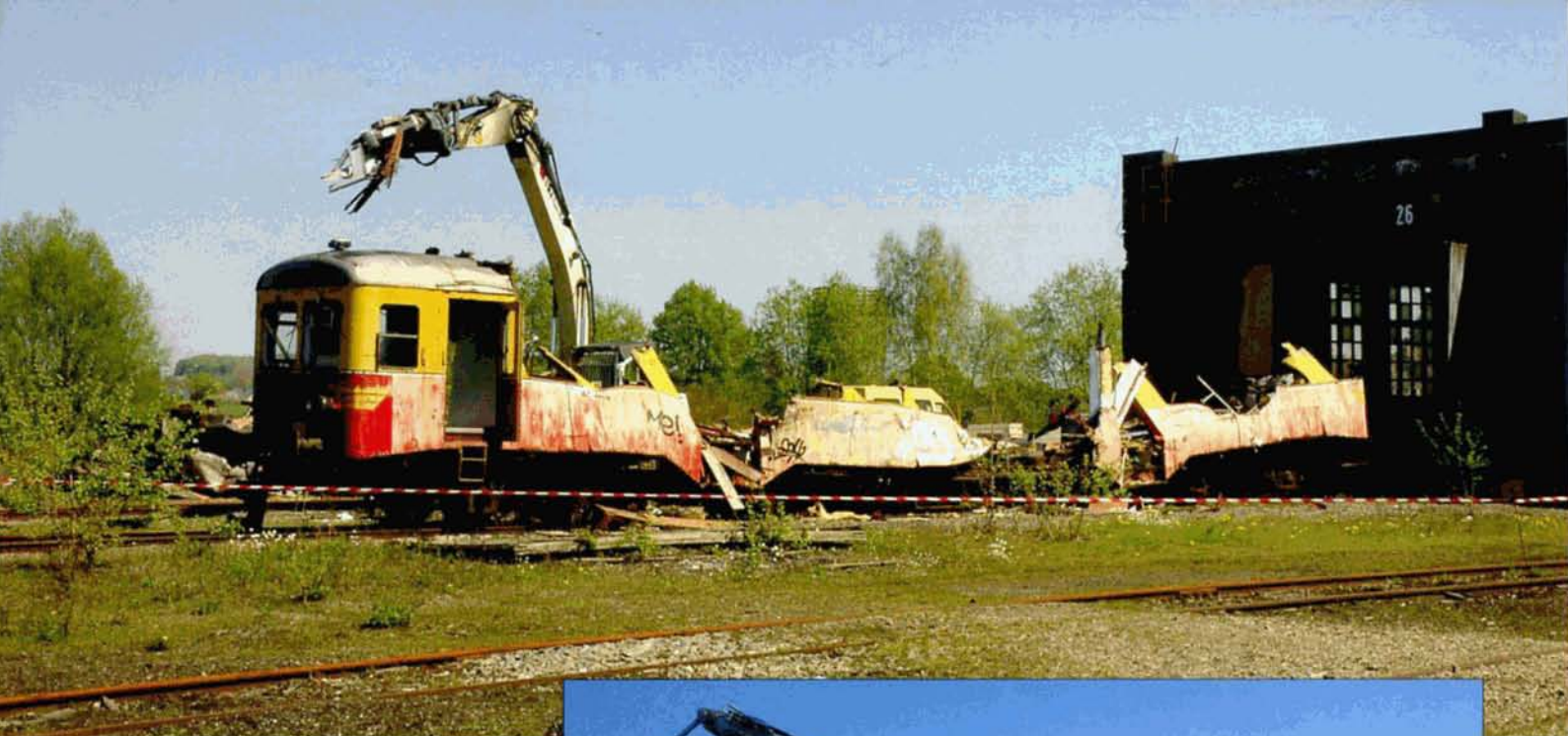
PHOTOS 92-28 ↑ - 92-29 → Ferrailage du 4502, 21 avril.
