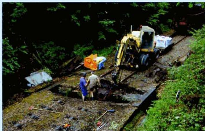
*Après le démontage de la voie et l'enlèvement de la structure métallique déficiente après 105 ans de bons et loyaux services, les culées sont nettoyées et préparées pour recevoir la dalle en béton. PFT.*
