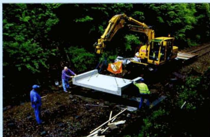
*La grue rail-route met la nouvelle structure en béton en place sur les culées. Les bénévoles assistent cette délicate opération. PFT.*
