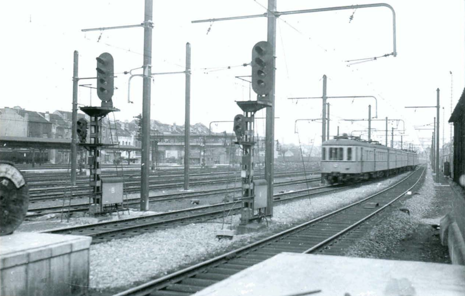
Arrivée d'une automotrice dans l'ancienne gare de Bruxelles-Nord. On remarquera la toute nouvelle signalisation lumineuse mise en service en même temps que la traction électrique sur la ligne 25. Photo SNCB.
