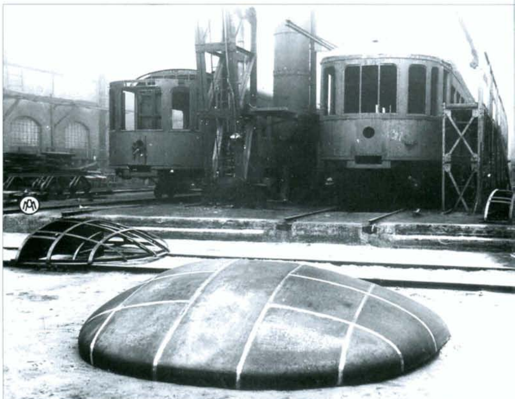
Assemblage des caisses des automotrices de 1935 aux Ateliers Métallurgiques de Nivelles. A l'avant plan, on voit l'ossature et l'arrondi de la partie avant de la toiture des motrices. Photo AMN Nivelles, collection PFT ©.
