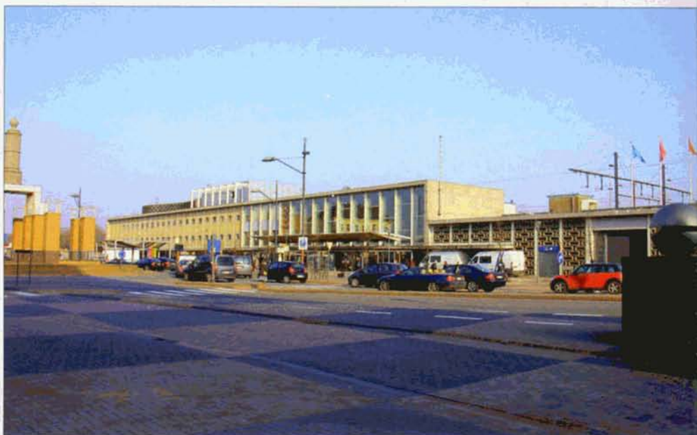
PHOTO 102-31 Le bâtiment de la gare de Mechelen, tel qu'il se présente aujourd'hui. Pas vraiment un chef d'oeuvre architectural... A gauche on voit la La colonne « milliaire ». Pierre HERBIET, 4 mars 2011.
