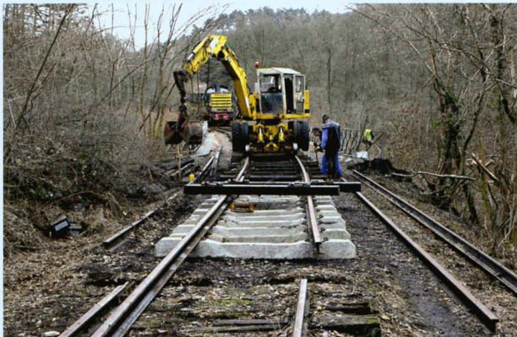
Une fois la voie reposée sur le "pont du mort" et moyennant une connexion provisoire avec l'ancienne voie visible au premier plan, les matériaux ont pu être déchargés derrière Christian Auquière, le photographe. PFT.
