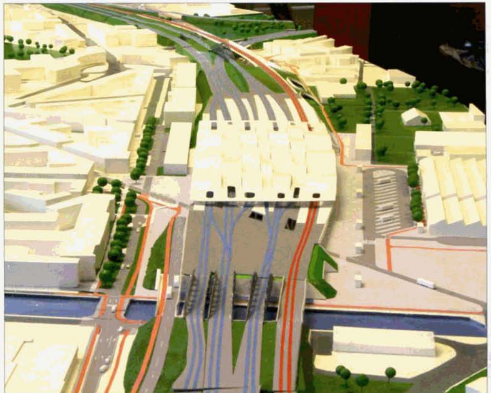
La maquette vue en direction de Bruxelles. En rouge, on aperçoit les deux nouvelles voies rapides du "by-pass", qui seront installées à gauche de la ligne 25 en regardant vers Bruxelles. Au milieu, l'actuel pont Vierendeel qui permet à la ligne 25 de franchir la ligne 53A vers Muizen et Leuven. On remarquera également la tangente routière qui sera établie parallèlement au by-pass et qui occupera une partie des terrains de l'Atelier Central de Mechelen. Copyright TUC RAIL.
