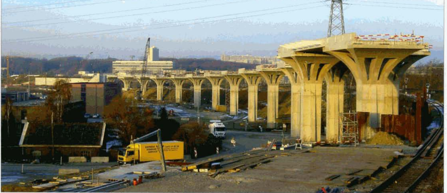
Une vue du viaduc Iris, prise depuis la ligne 26, en direction de Bruxelles. Long de 967 m, il est supporté par un ensemble de 34 piles. Haren, 5 janvier 2011.
